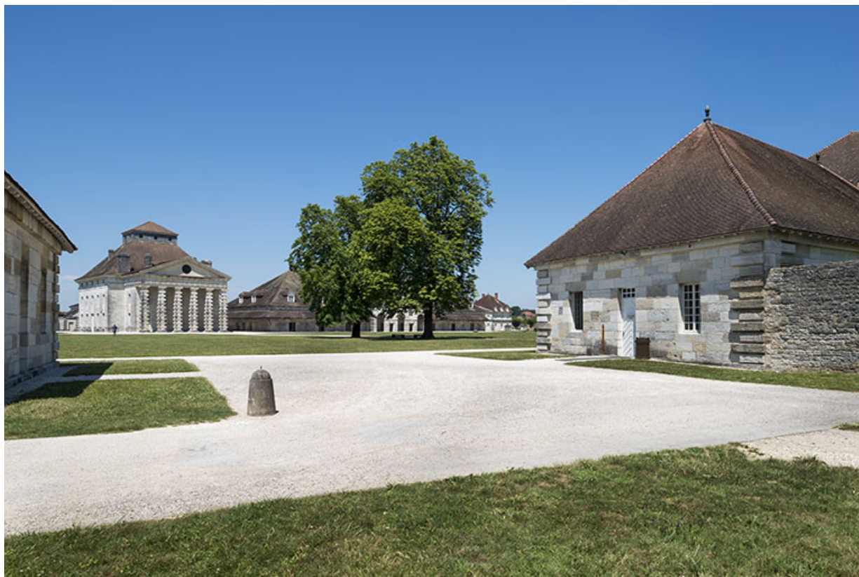
Vue d'ensemble depuis le mur d'enceinte sud.
