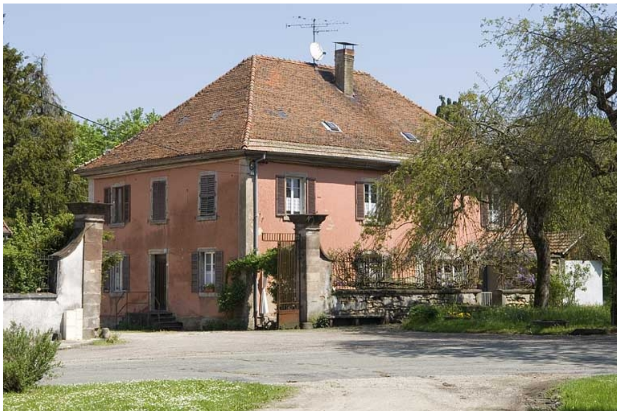
Bâtiment des bureaux (direction).
