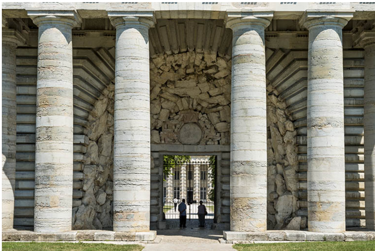
Vue rapprochée du portique et de l'entrée.
