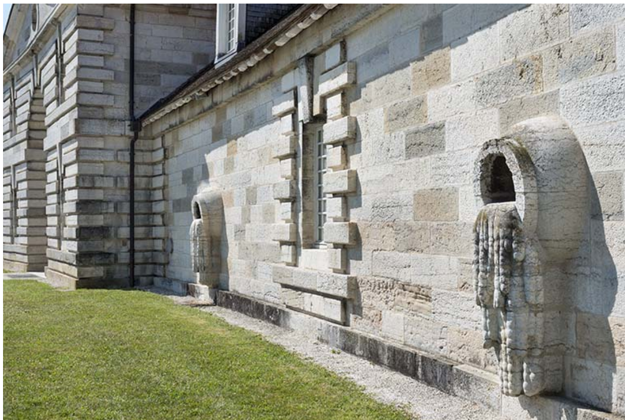
Logement des ouvriers (berniers) ouest. Détail de la façade.
