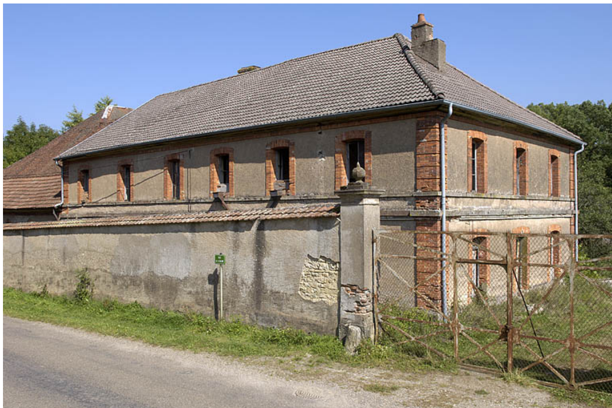
Bâtiment du logement et des bureaux. Vue de trois quarts arrière.
