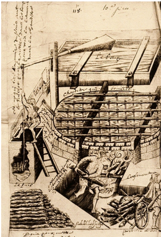
Vue d'une chaudière.
