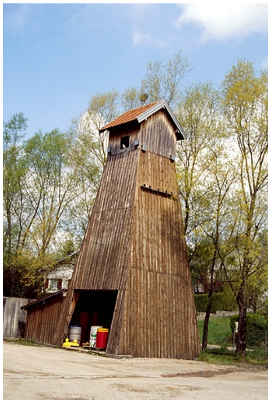
Chevalement du puits n° 7.
