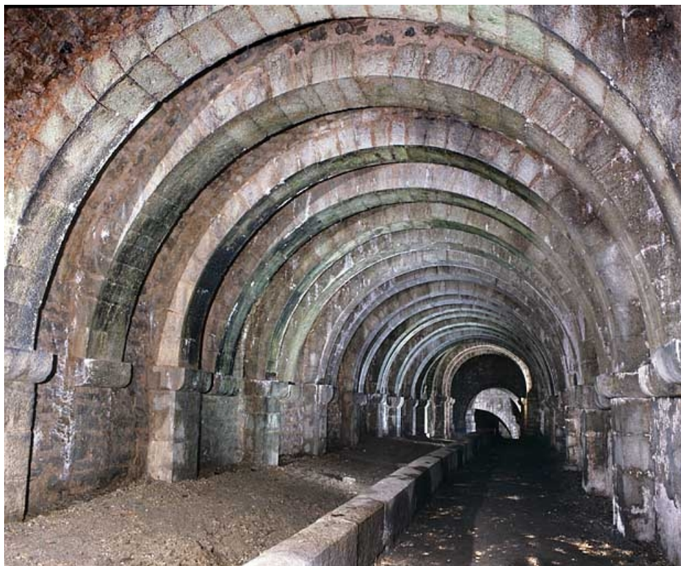
Galerie souterraine voûtée.
