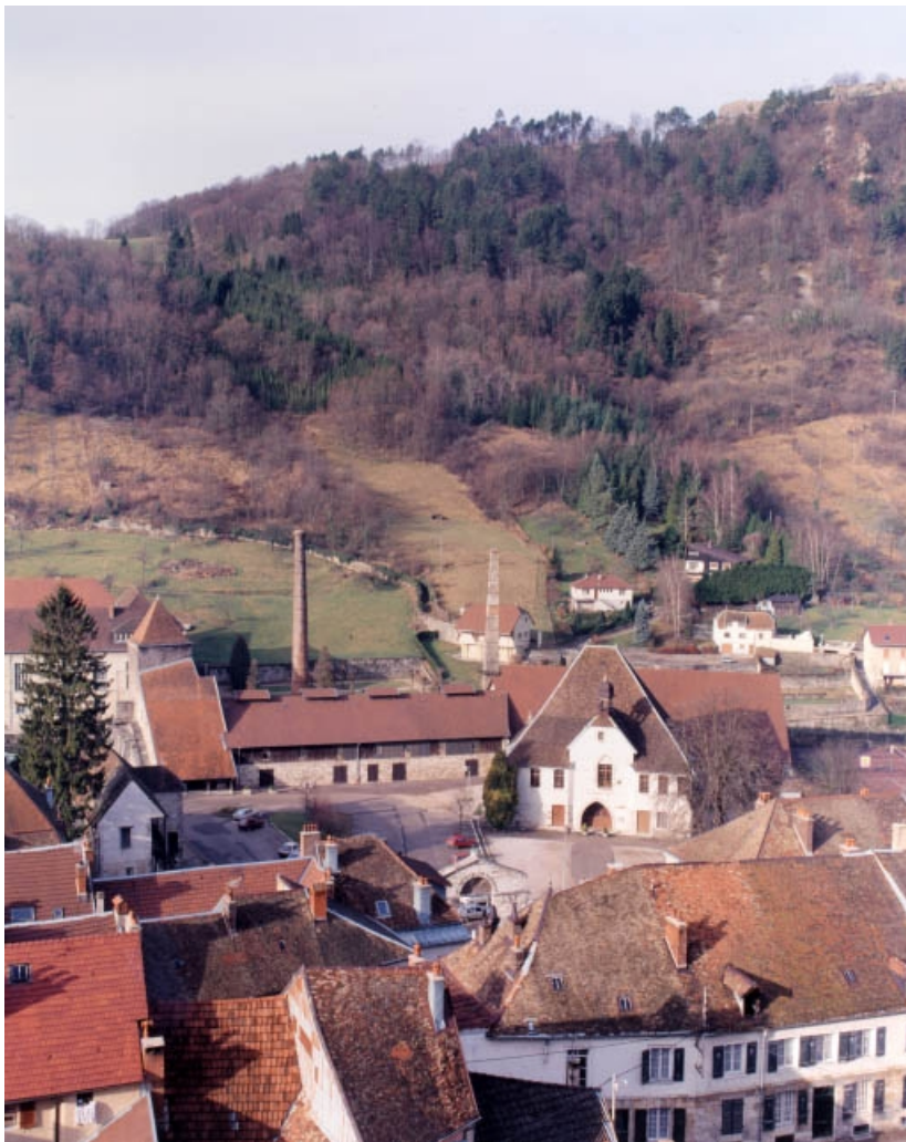
Vue d'ensemble depuis l'est : logement du Pardessus et bâtiment des poêles. 39, Salins-les-Bains place des Salines
