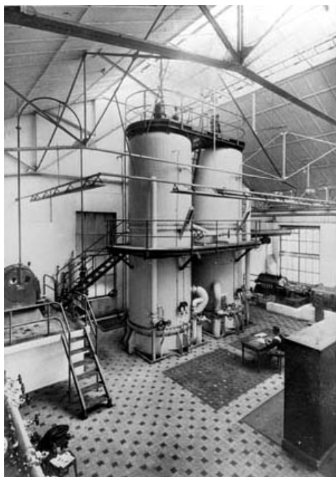
Evaporateur Escher-Wyss pour la fabrication de sel fin aux salines de Montmorot (Jura).
