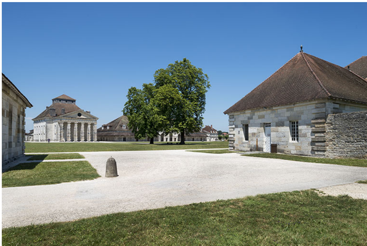
Vue d'ensemble depuis le mur d'enceinte sud.
