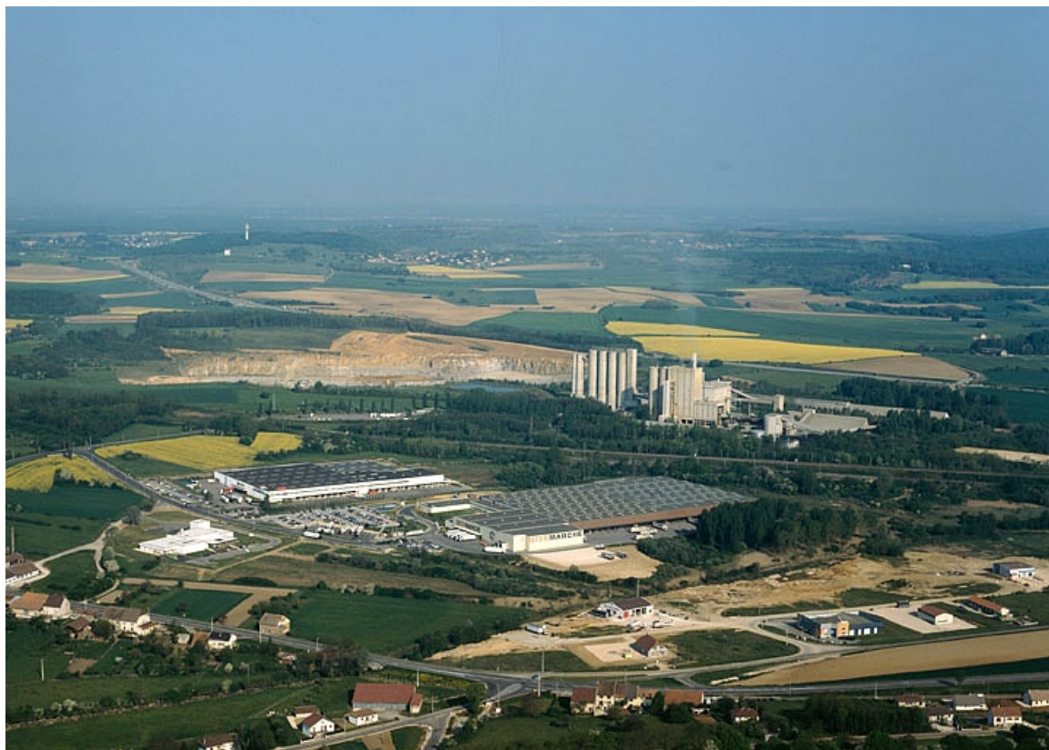
Vue aérienne, depuis le sud-est.
