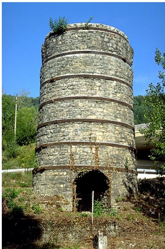
Four à chaux.
