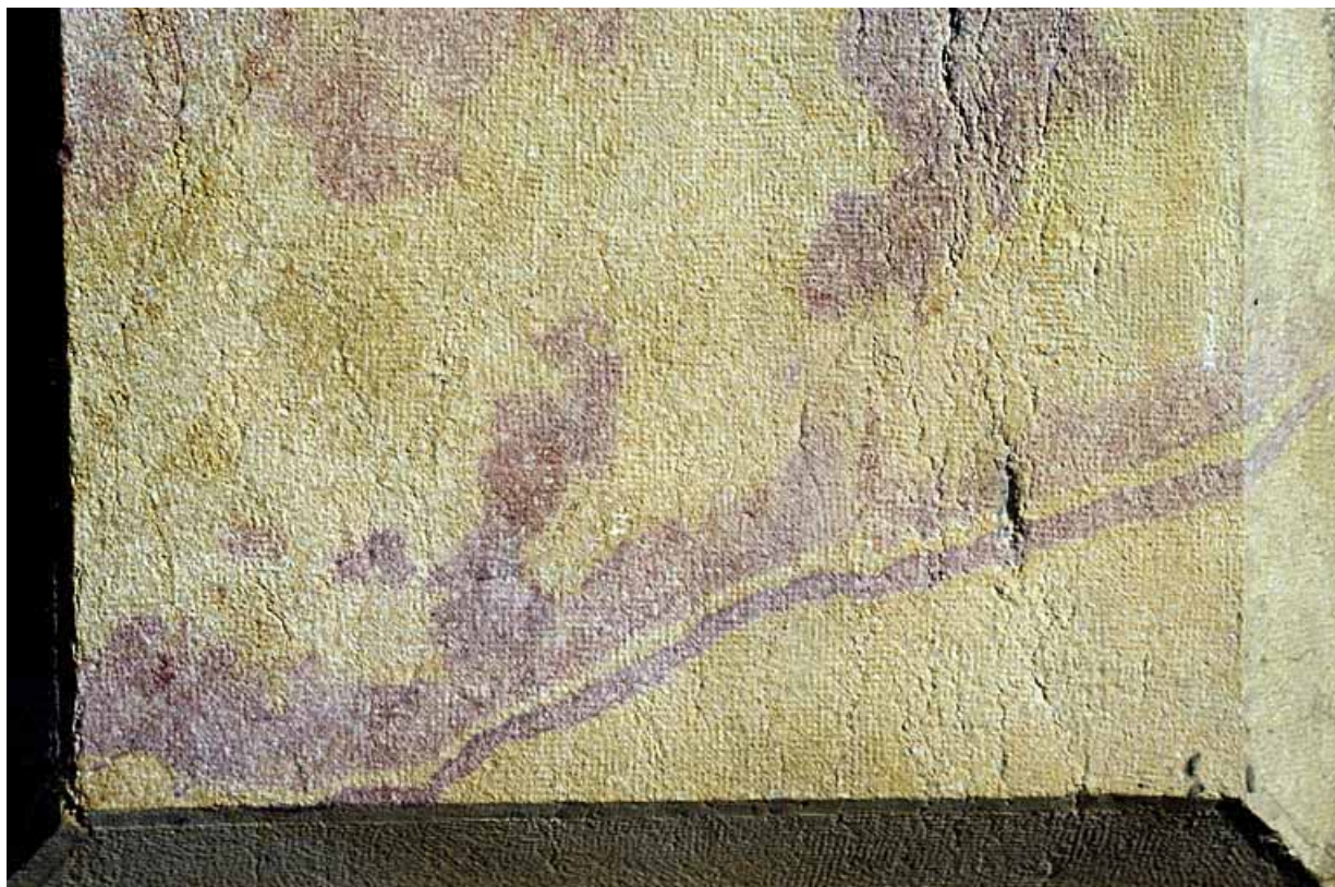
Façade latérale droite : bossage du soubassement, en pierre de Damparis ou Sampans (Jura) veinée de rouge.
