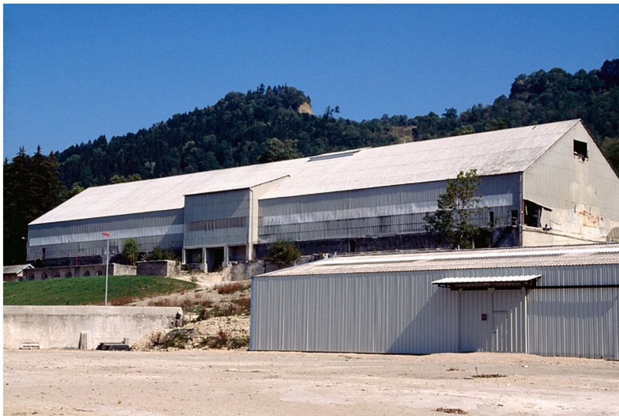
Hall de préhomogénéisation.
