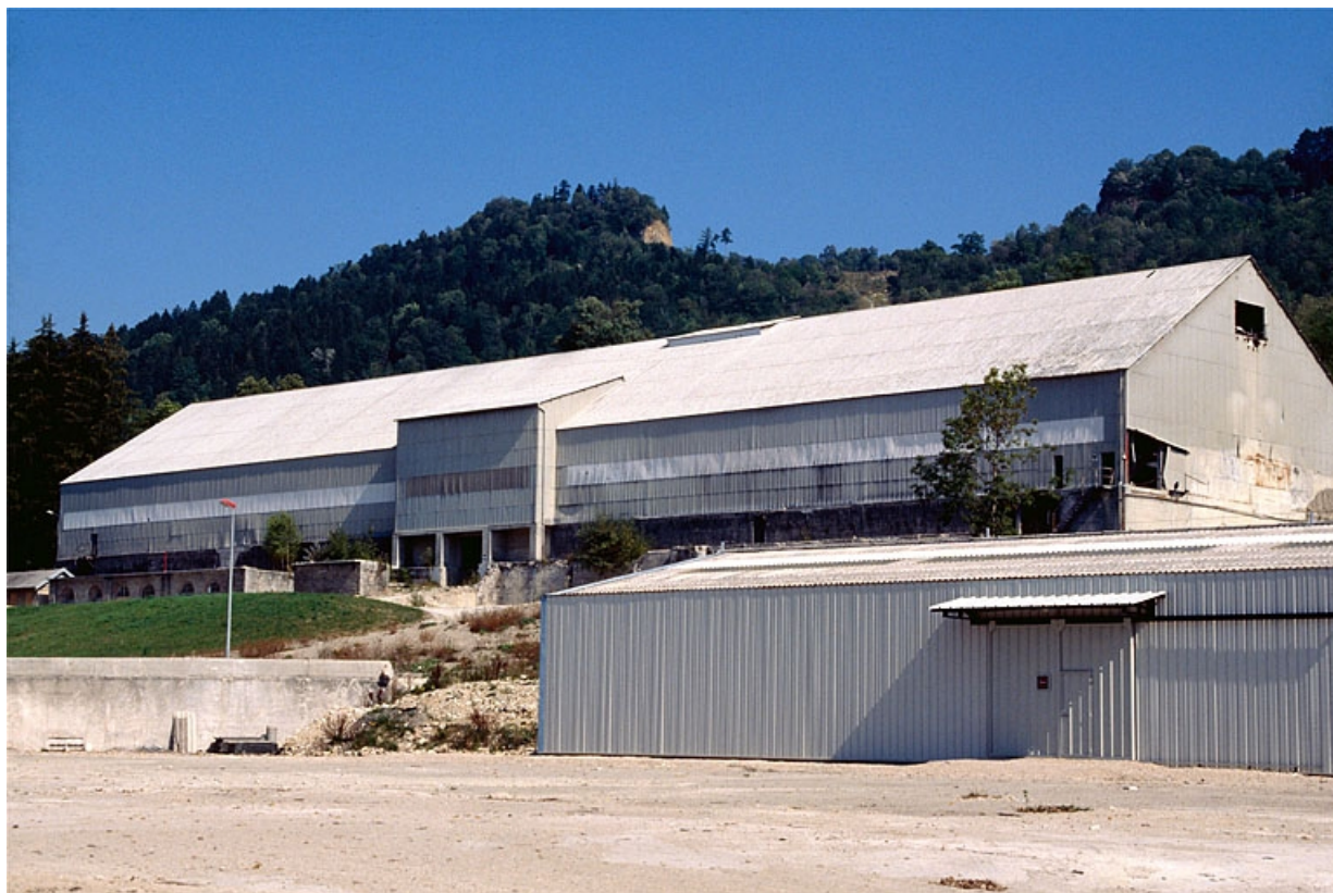
Hall de préhomogénéisation.
