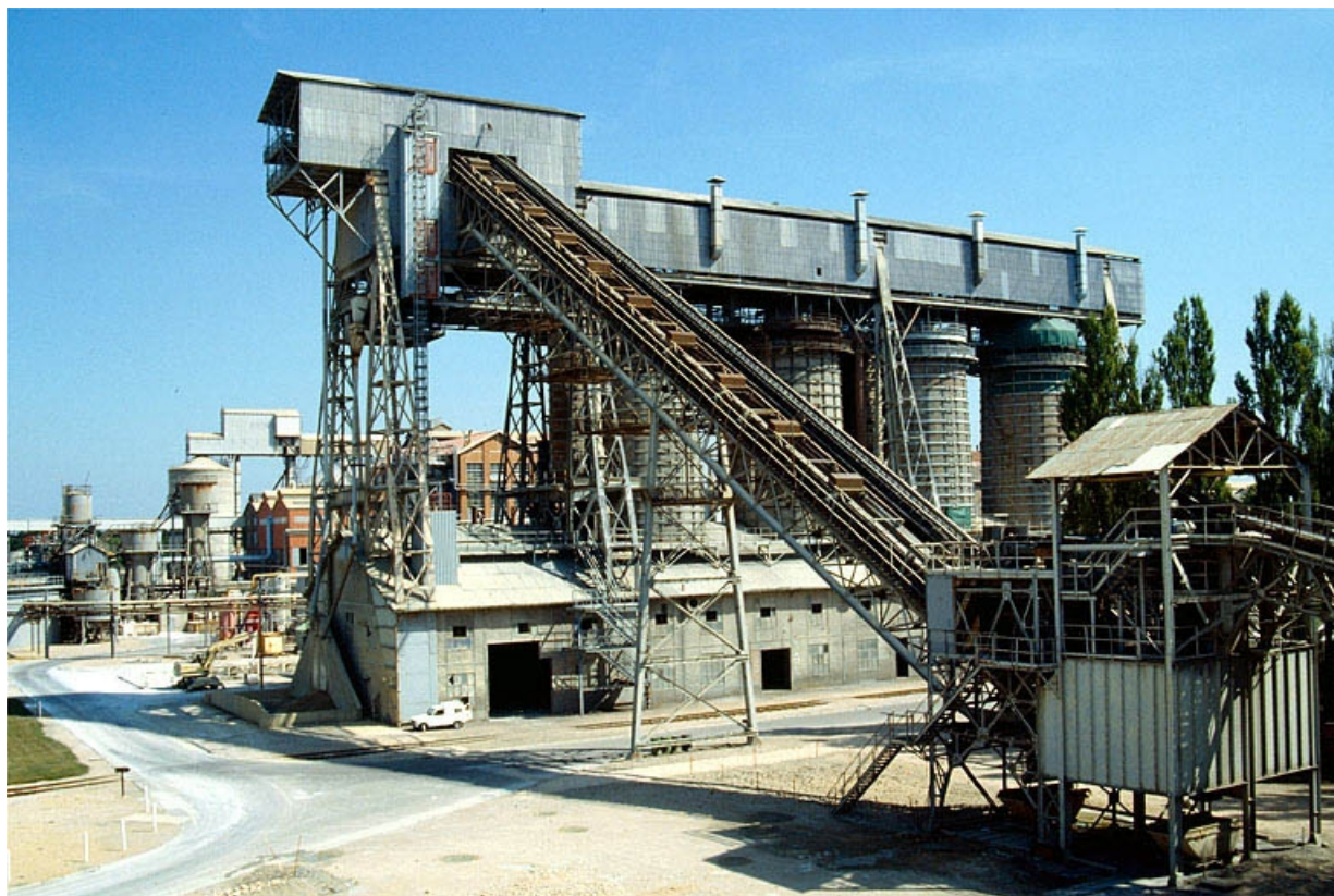
Fours à chaux vus de trois quarts gauche.
