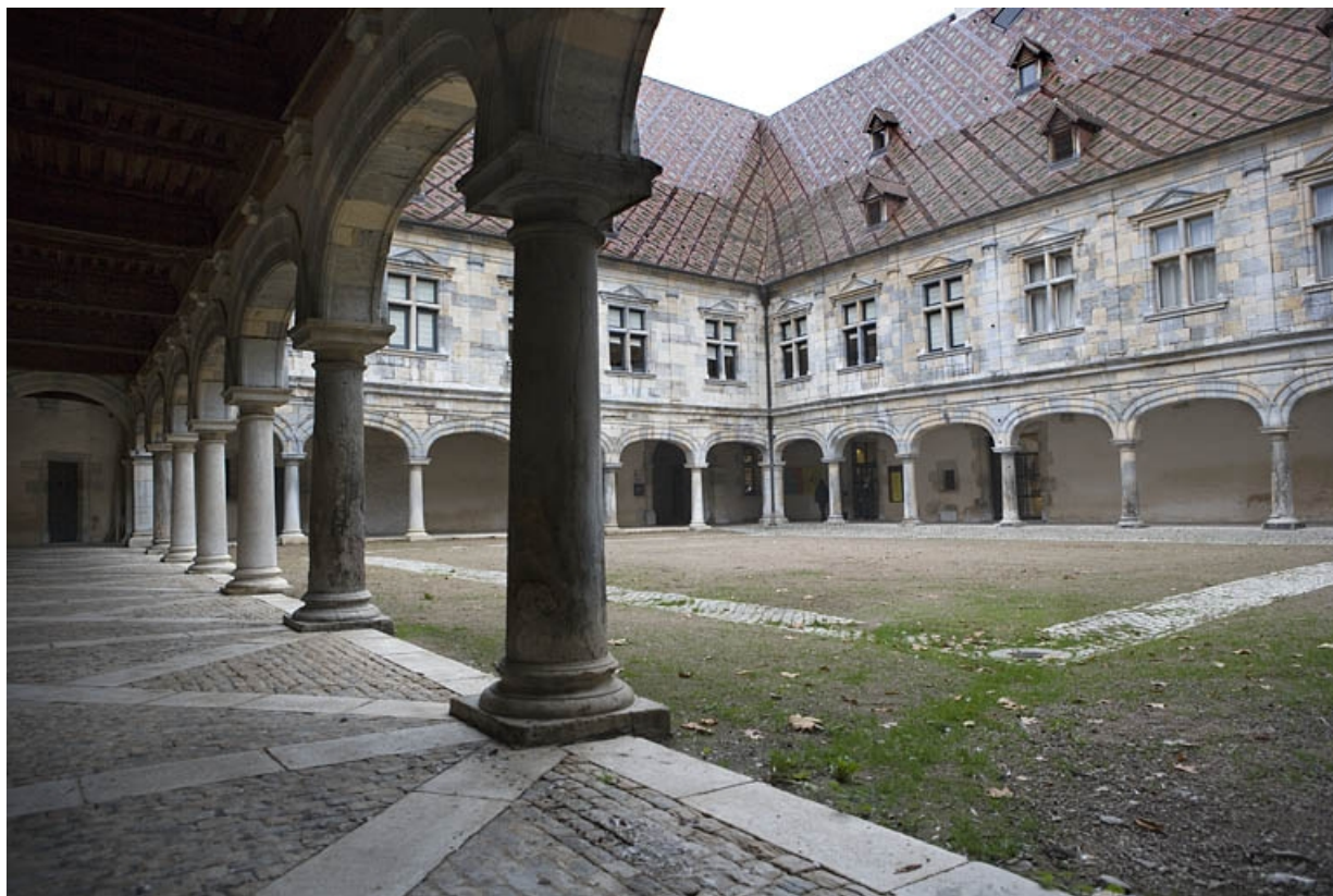
Vue d'ensemble des bâtiments depuis le l'angle ouest de la galerie.
