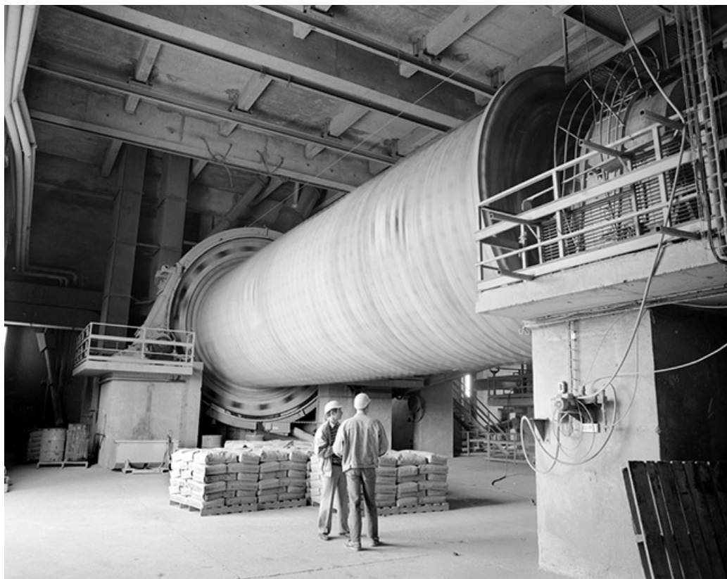
Atelier de fabrication : broyeur de clinkers.
