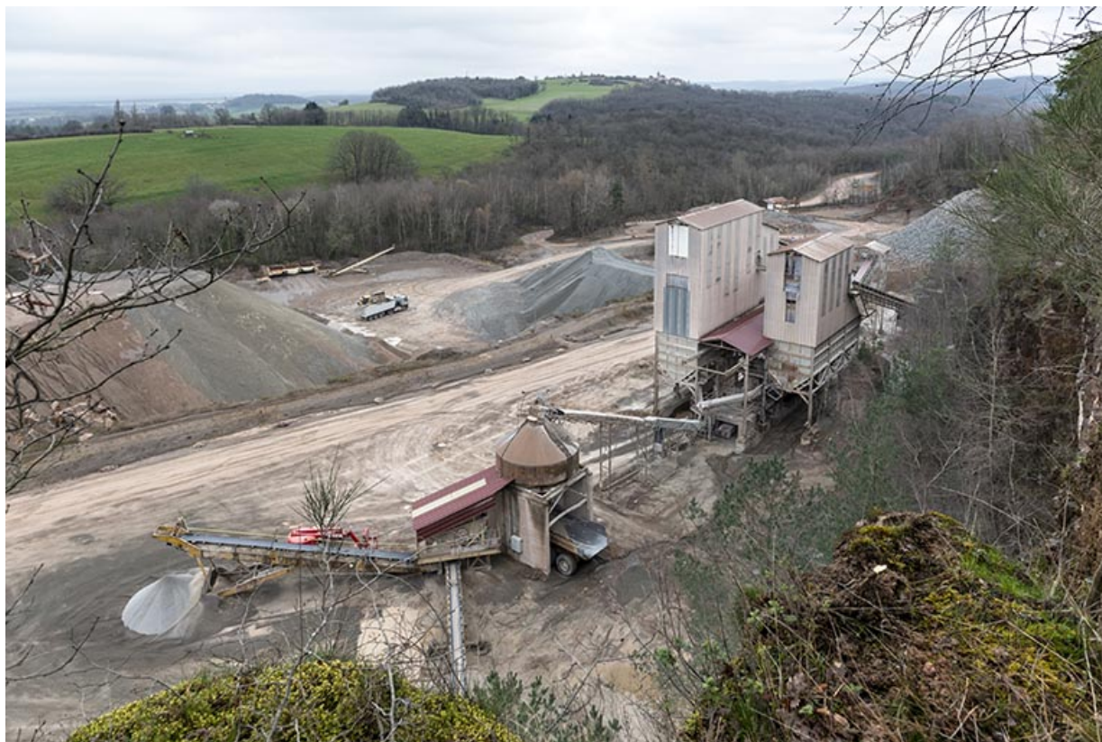
Vue d'ensemble plongeante sur les nouvelles installations de concassage.
