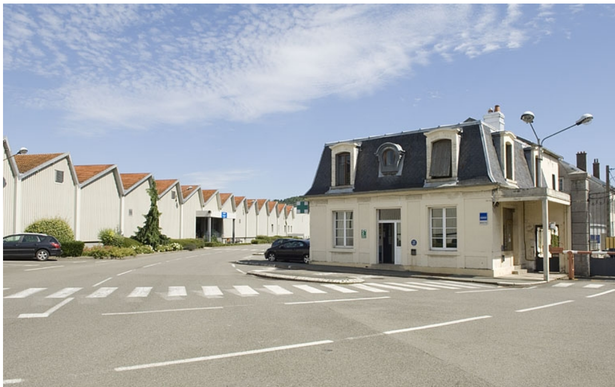
Atelier de fabrication et conciergerie (actuellement infirmerie).
