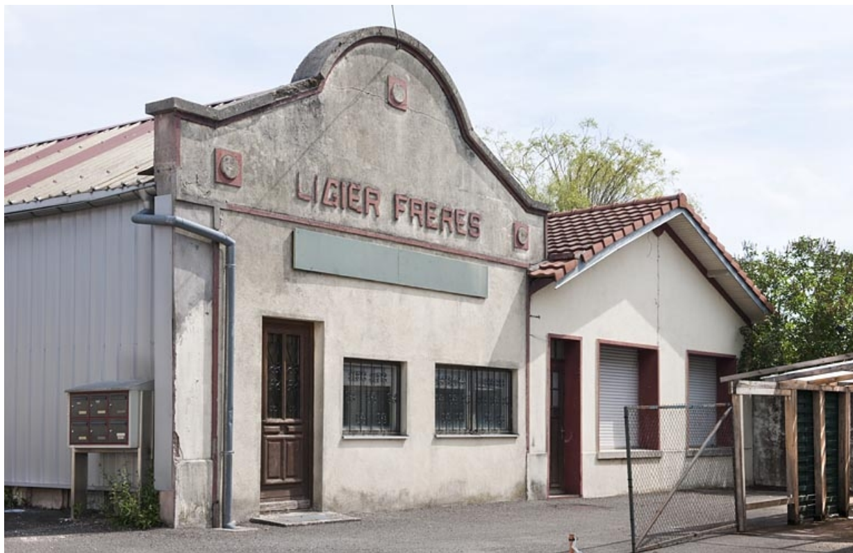
Pignon de l'atelier de fabrication originel.
