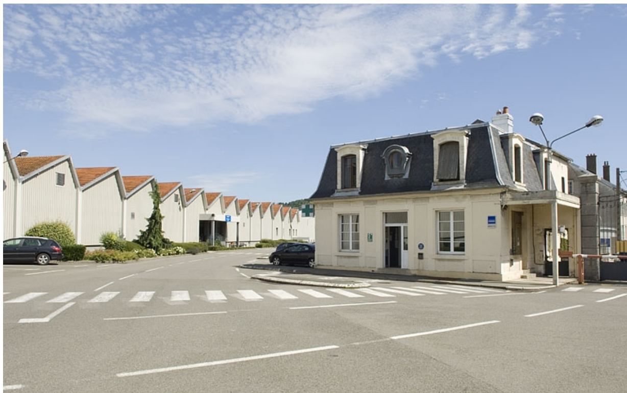
Atelier de fabrication et conciergerie (actuellement infirmerie).
