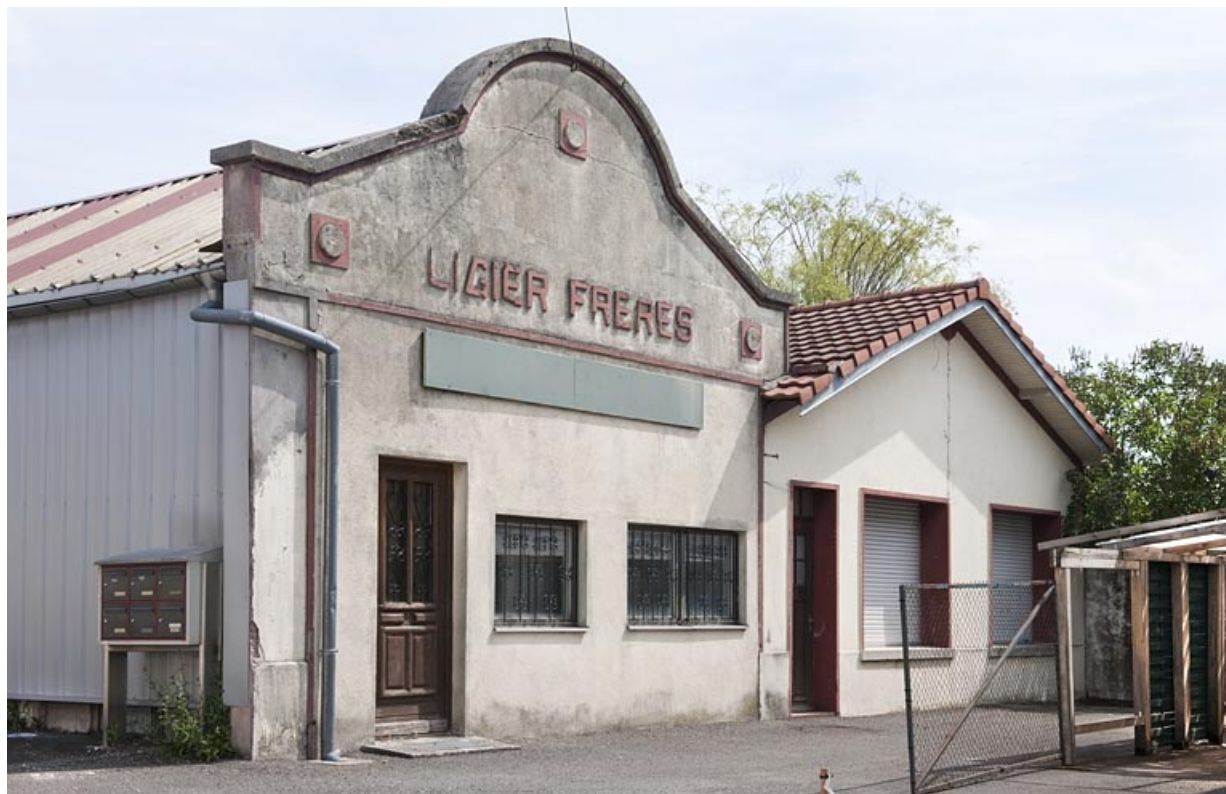
Pignon de l'atelier de fabrication originel.
