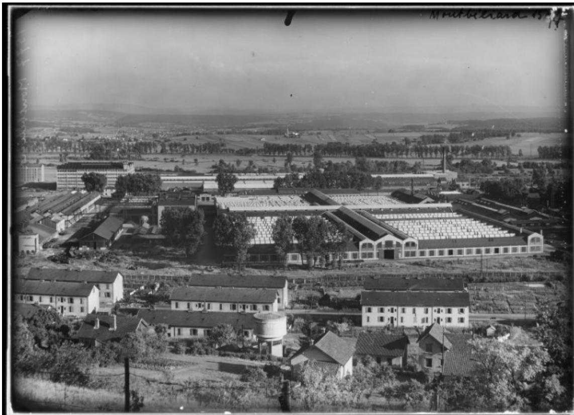
[Cité ouvrière et ateliers d'usinage et de montage], [1er quart 20e siècle ?]. 25, Sochaux, 57 avenue du général Leclerc
