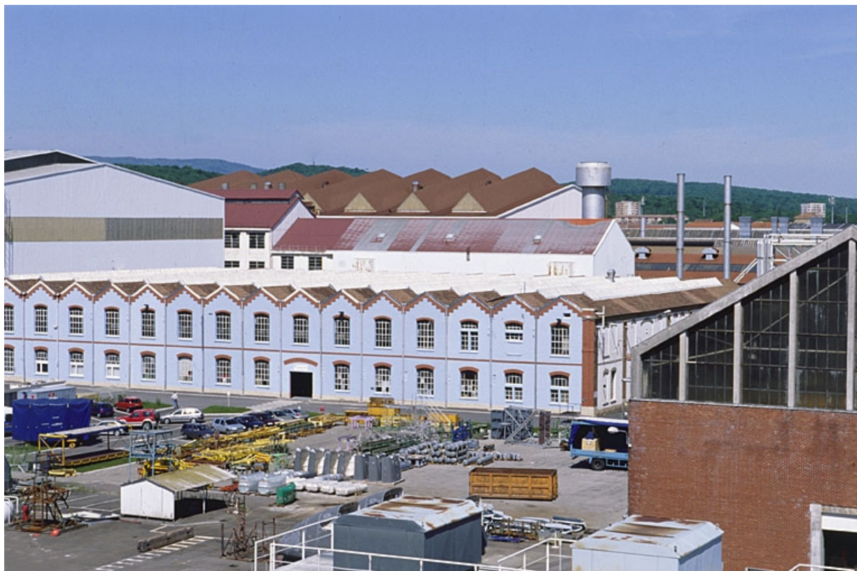
Vue plongeante depuis le sud-ouest.
