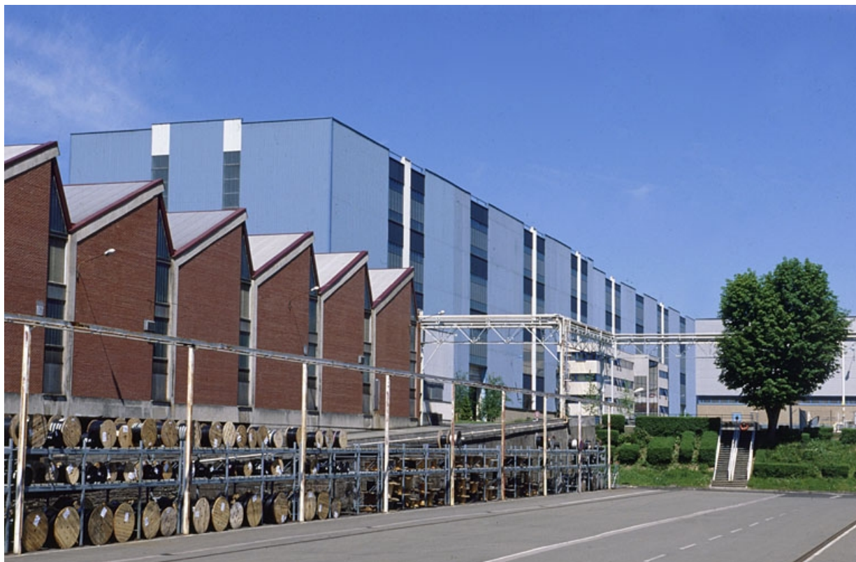
Vue d'ensemble d'un atelier Traction et de la halle 330.
