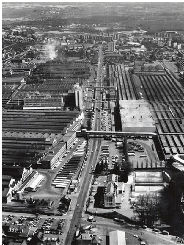
Vue plongeante depuis l'ouest en 1968.
