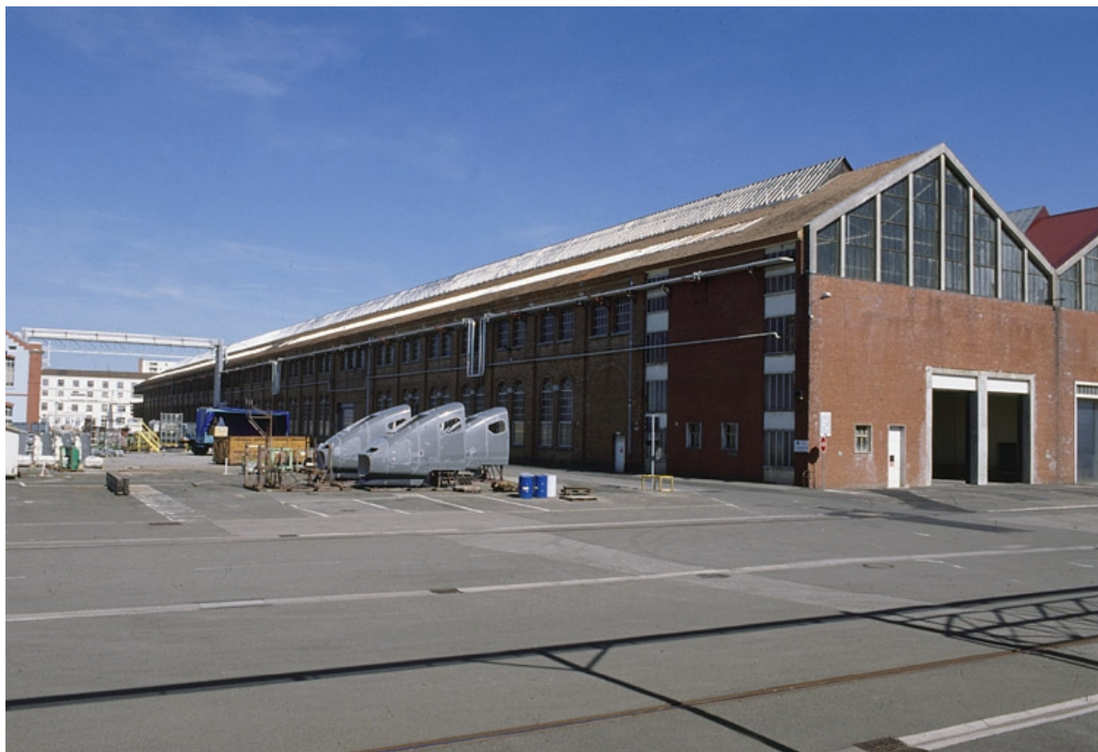
Façade nord de l'atelier Traction.
