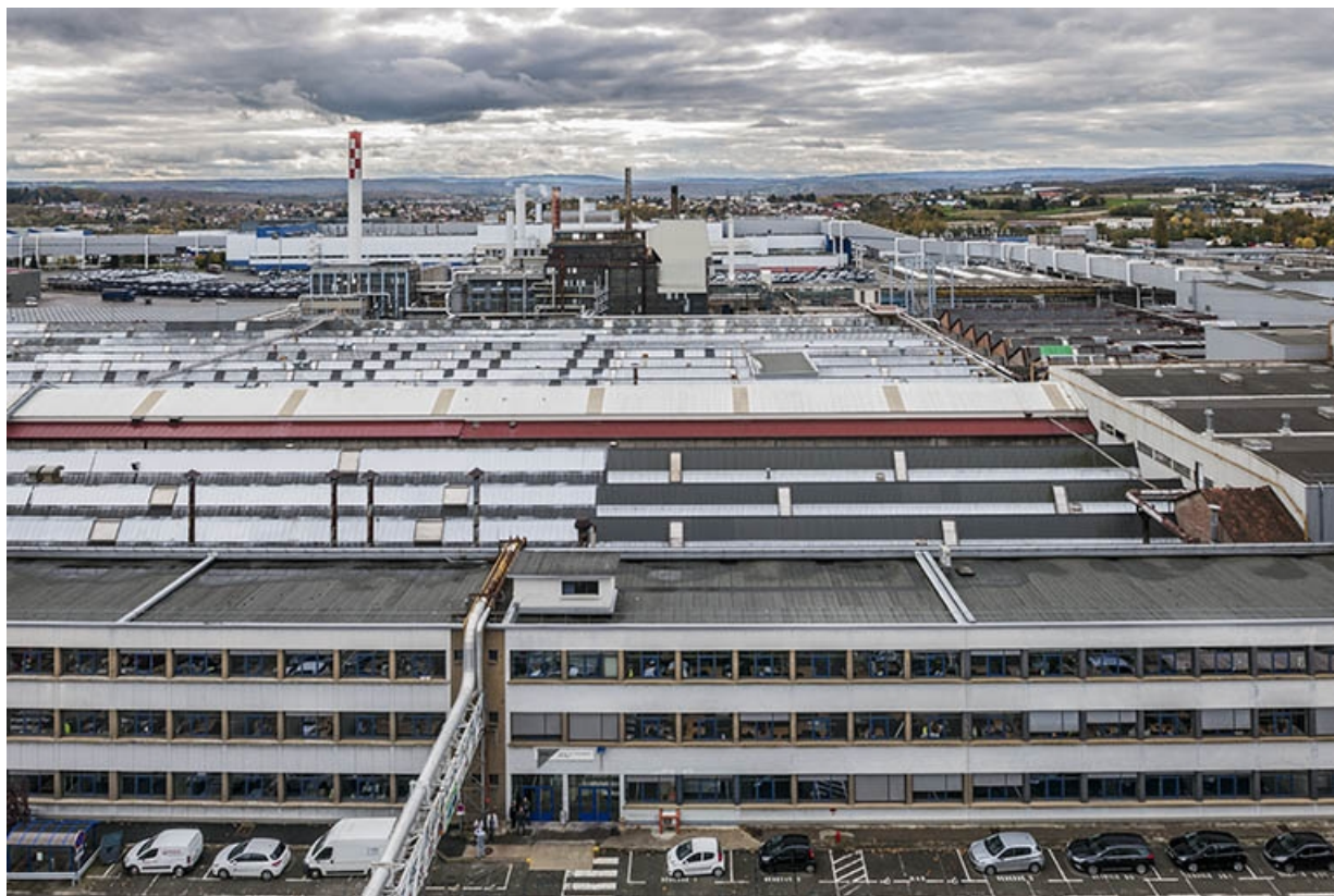
Vue plongeante vers le sud depuis le Building Centre.
