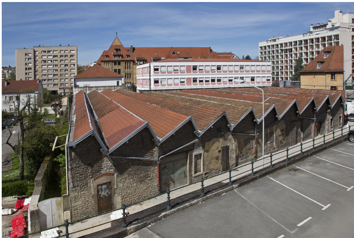
Atelier de fabrication boulevard Diderot : vue d'ensemble plongeante, depuis l'est.
