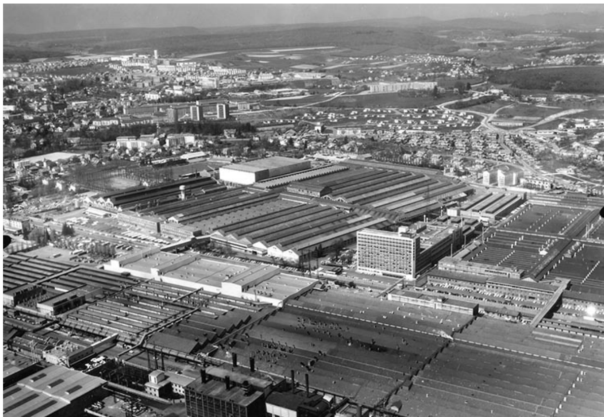
Vue plongeante depuis le sud-est en 1968.
