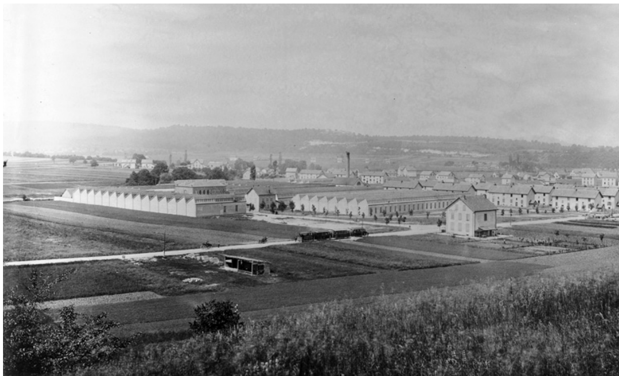
Vue éloignée depuis le nord-est.
