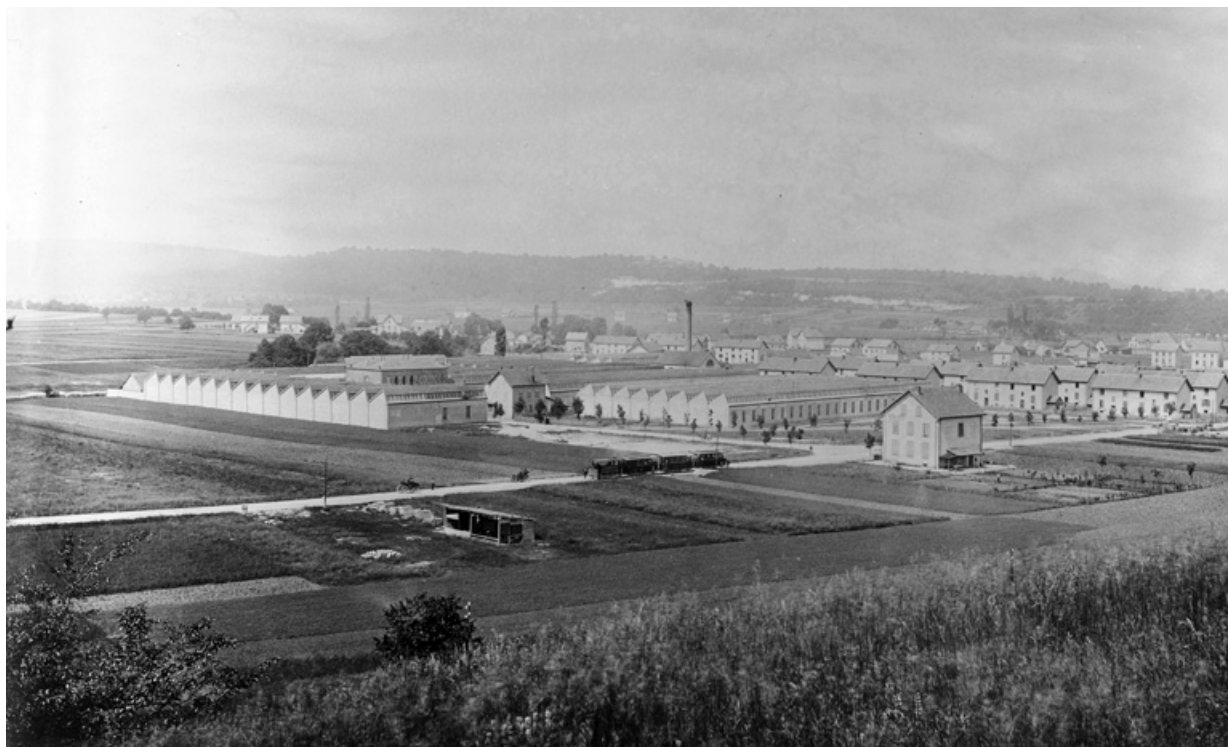
Vue éloignée depuis le nord-est.
