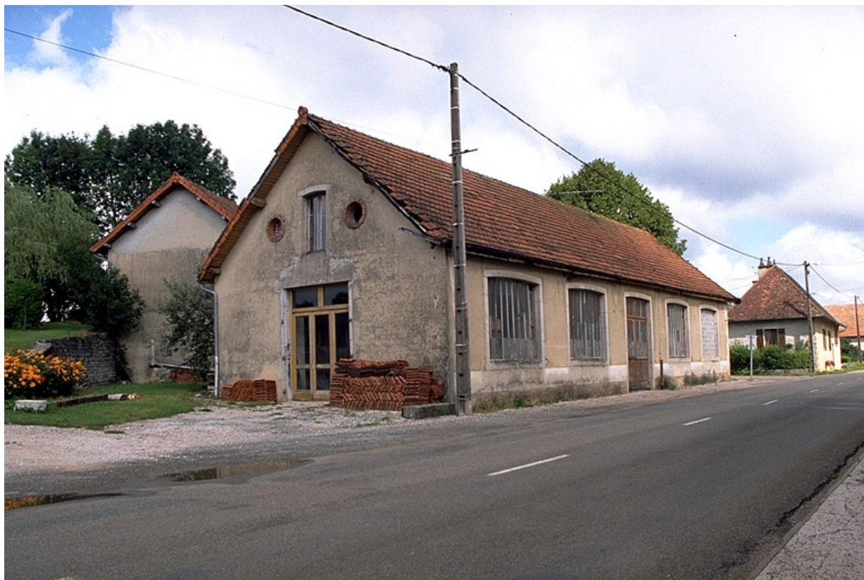
Atelier de fabrication depuis la route.
