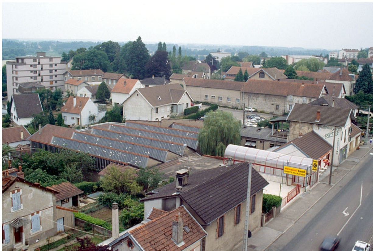
Vue plongeante sur les toitures de la première unité, depuis le nord.
