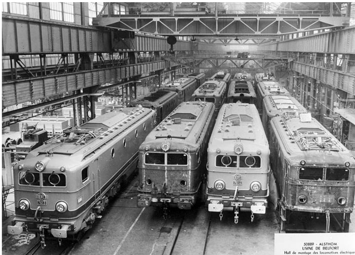
Hall de montage des locomotives électriques.
