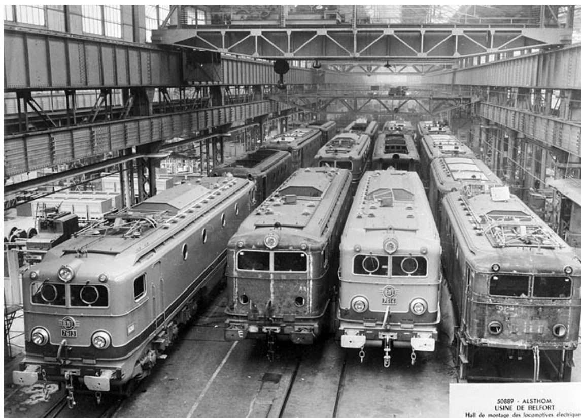
Hall de montage des locomotives électriques.
