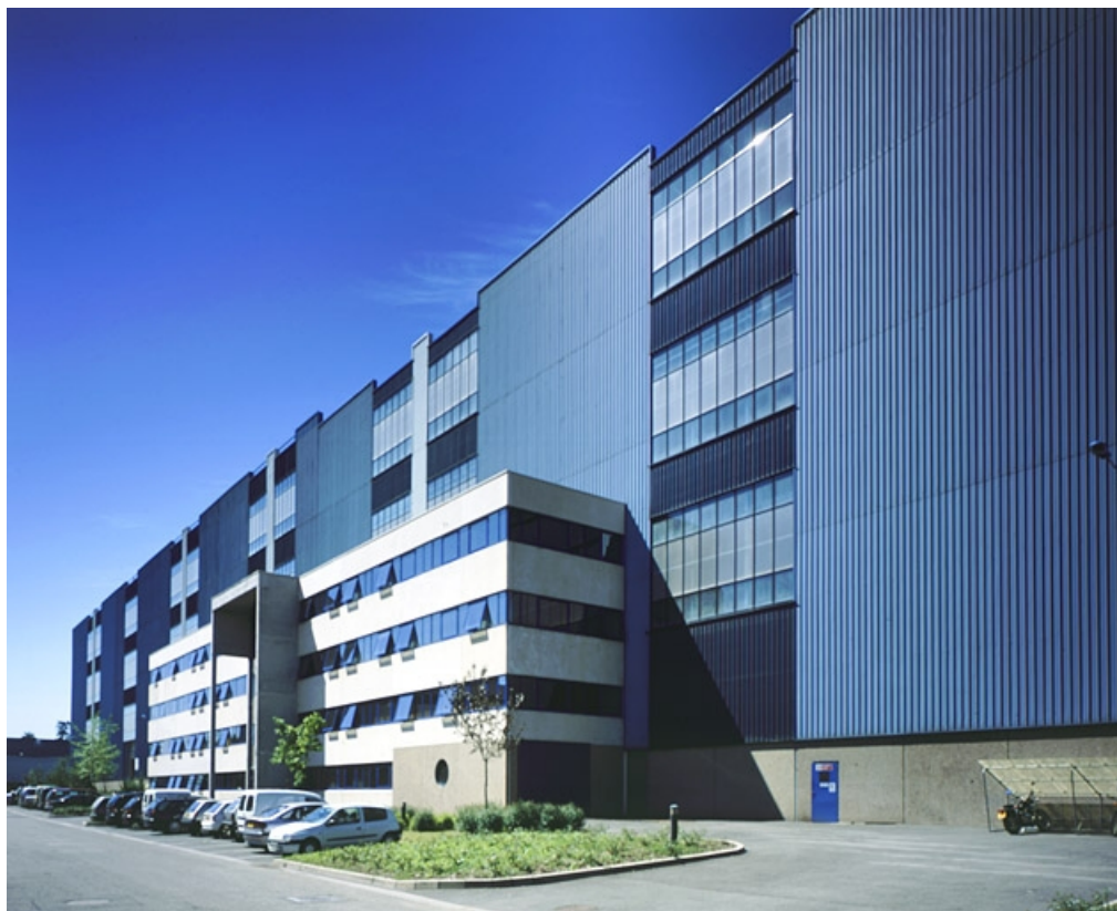
Halle 330 (bureaux et ateliers de montage).
