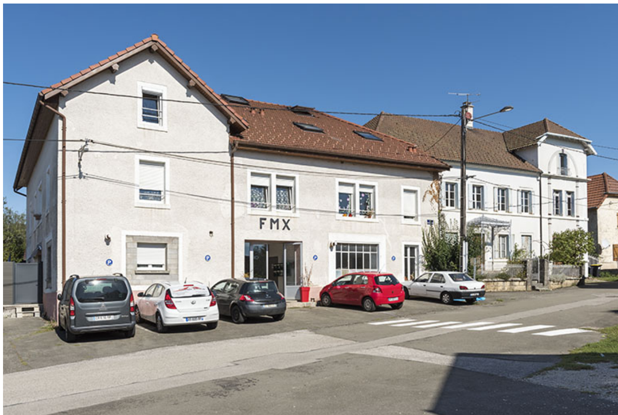
Usine (bâtiments d'origine), de trois quart gauche. Le logement est visible à droite.
