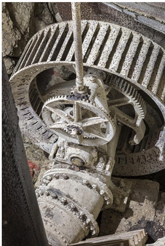
Usine : turbine Laurioz, au 2e étage de soubassement (chambre d'eau). Actionné depuis le rez-de-chaussée, l'arbre vertical commande l'admission d'eau.
