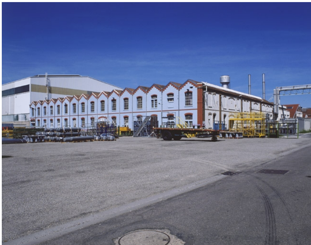
Vue de trois quarts de l'atelier de grosse construction.
