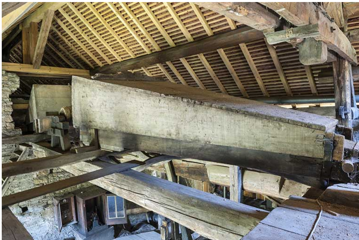
Caissons de la machine soufflante.
