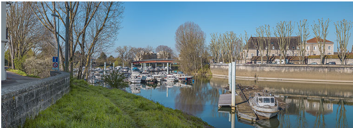
Vue d'ensemble du port de plaisance et de la passerelle.
