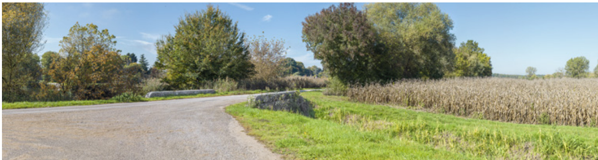
Ponceau (IA21005608) vu depuis le chemin de halage.
