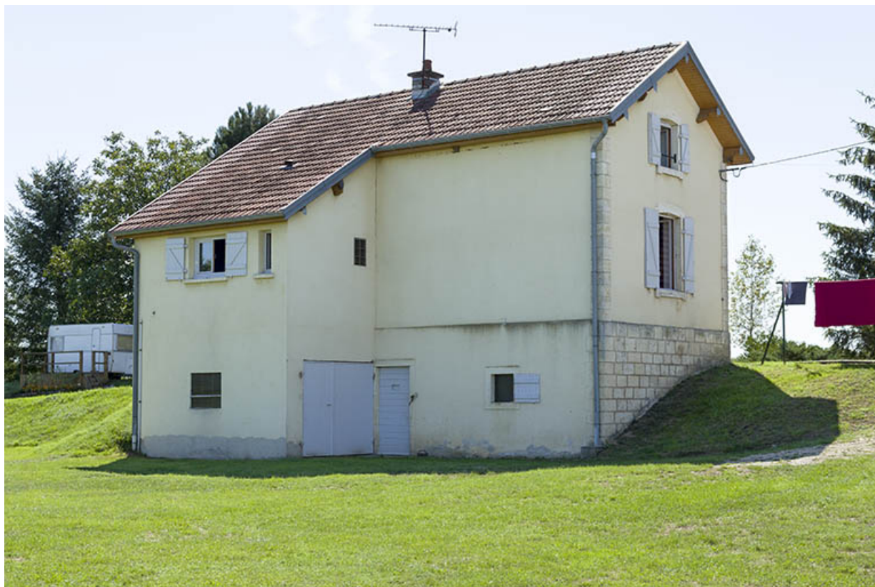
Façade postérieure de la maison.
