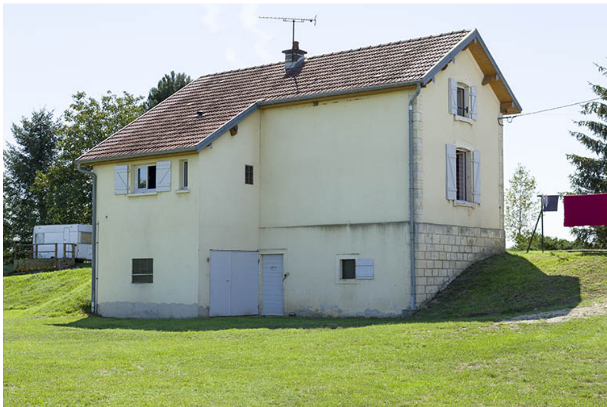
Façade postérieure de la maison.
