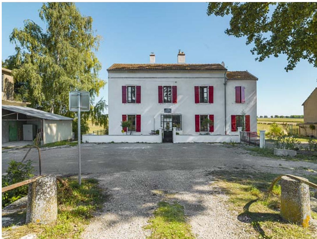
La maison éclusière : façade principale.
