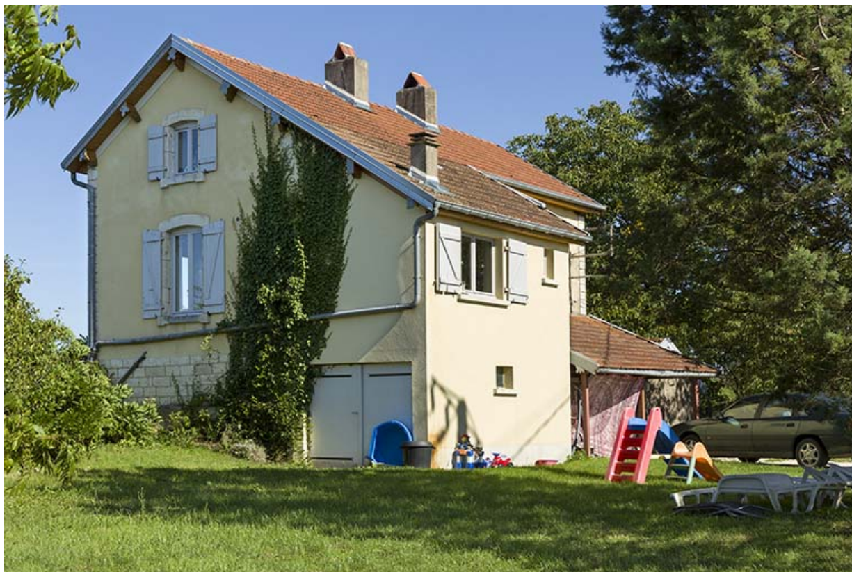
Vue de trois-quart de la maison de la porte de garde depuis le nord-ouest.
