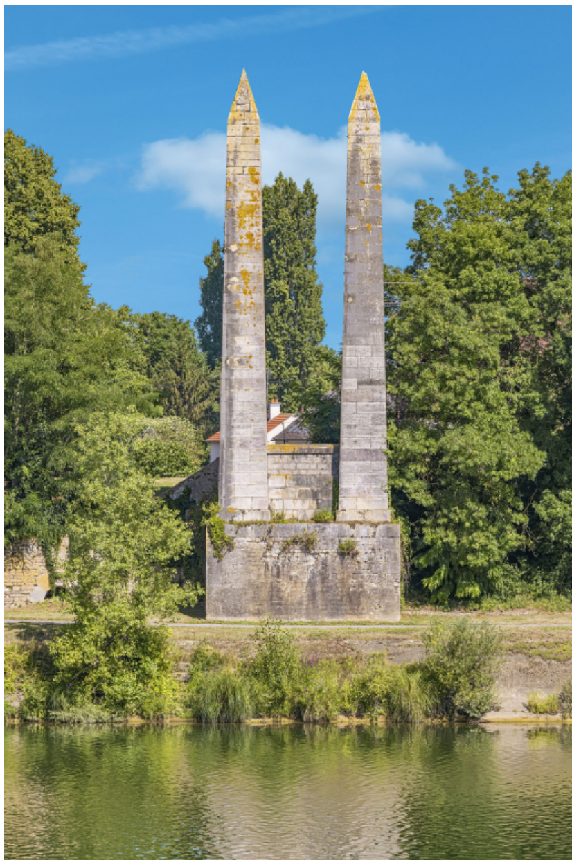
Pylônes de la rive droite.
