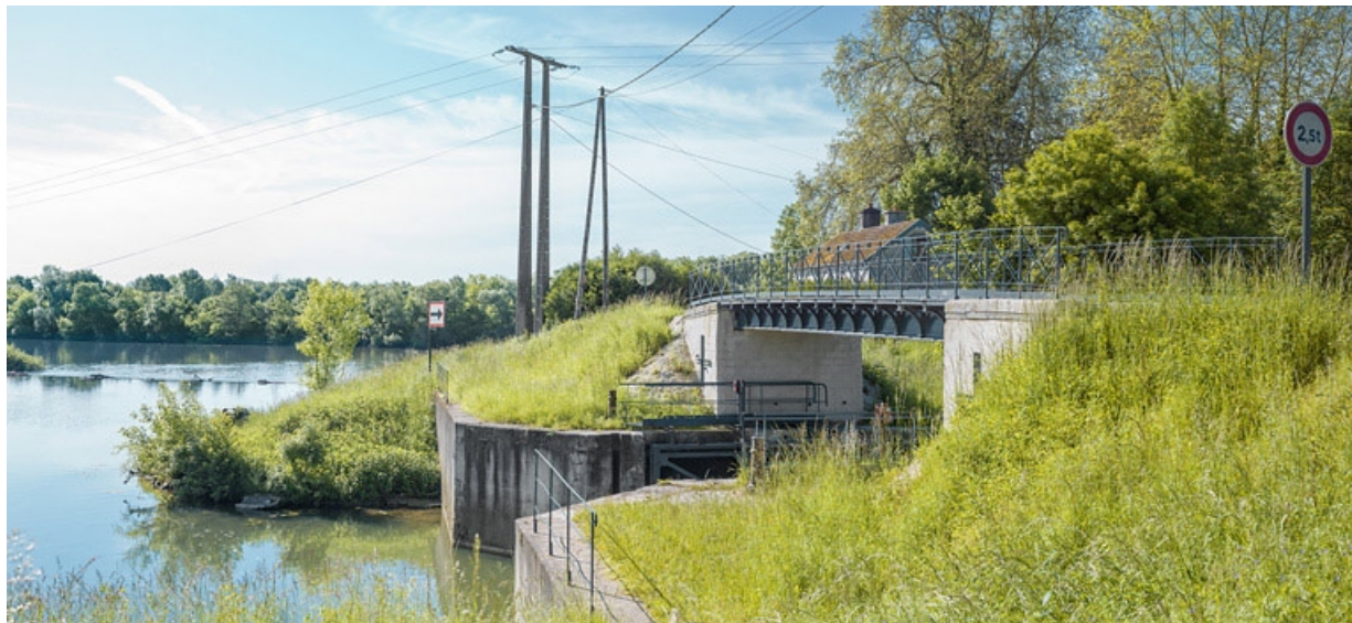
Porte de garde avec son pont. On distingue la maison du barragiste.
