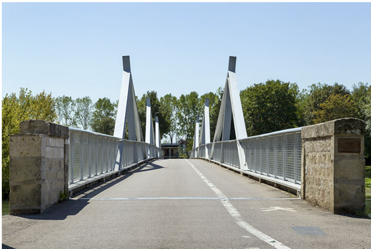
Pont de Rigny.
