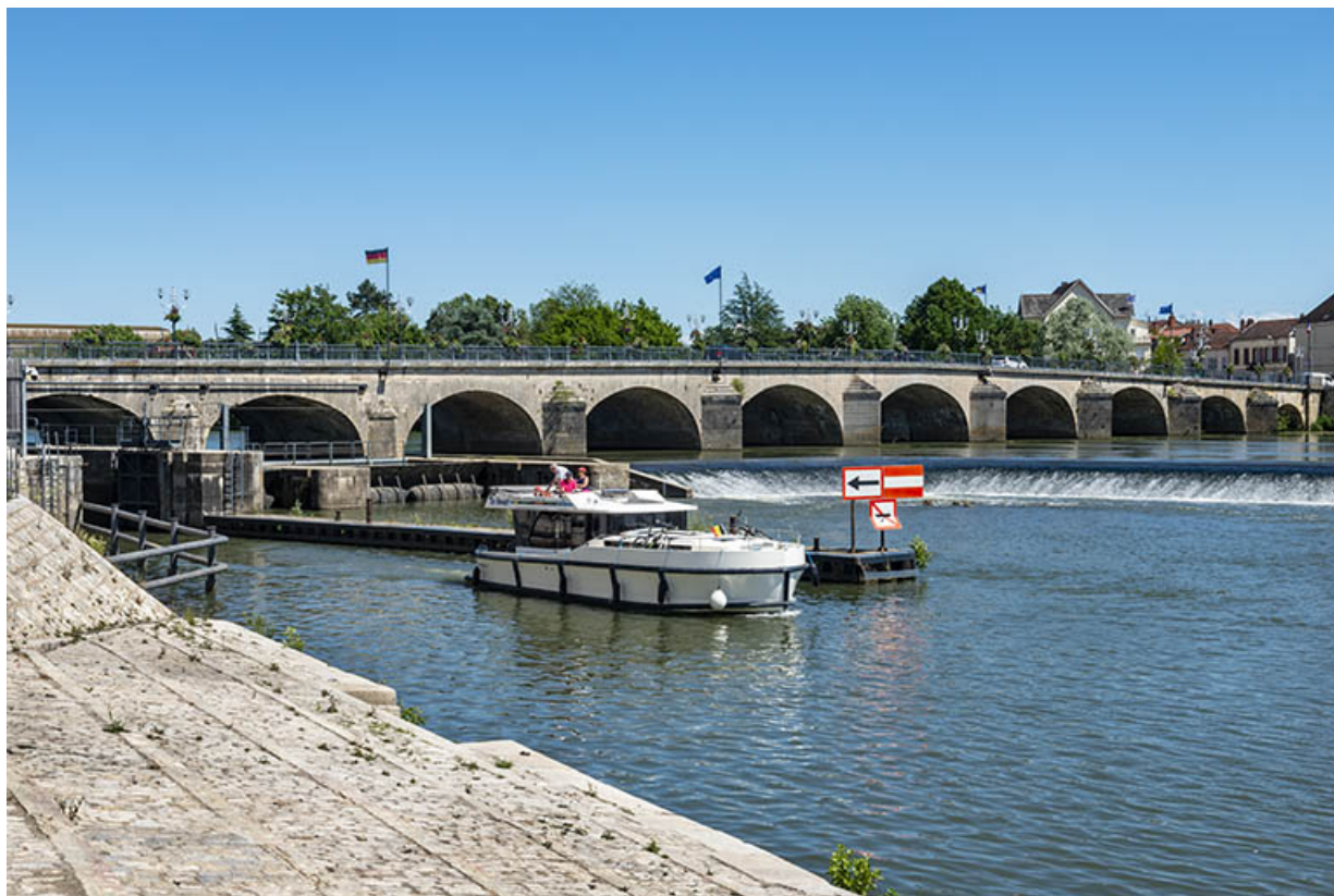
Le pont en pierre avec l'écluse marinière à Gray
