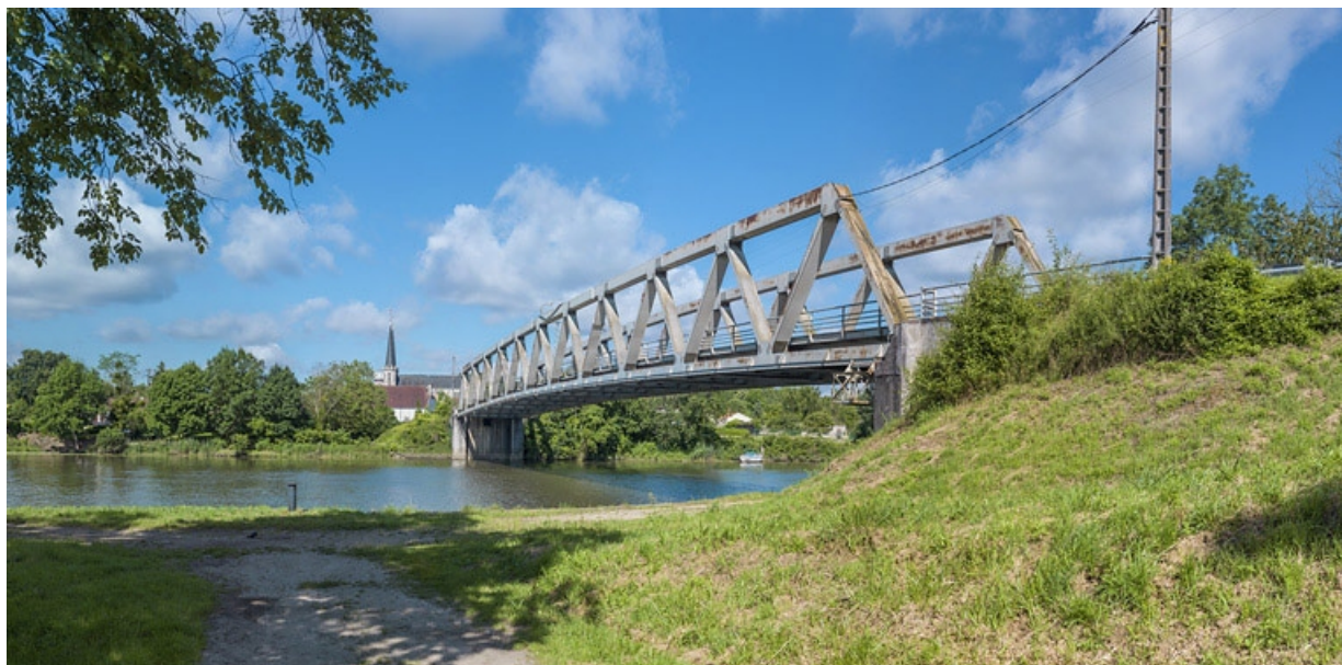
Pont routier de Lamarche-sur-Saône (21).
