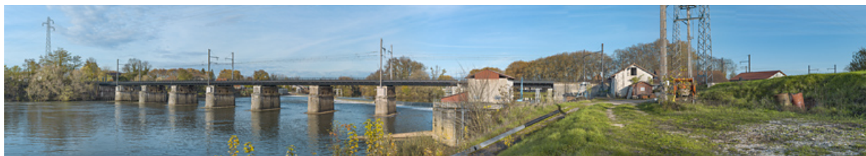
Le pont ferroviaire d'Auxonne (21).
