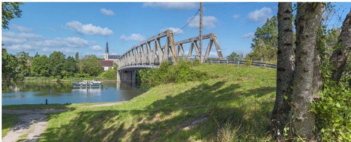
Vue d'ensemble, rive gauche.
