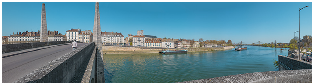
Le pont Saint-Laurent de Chalon-sur-Saône (71).
