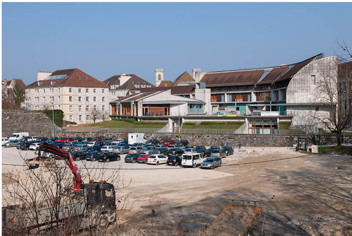
Besançon, lycée Condé : vue depuis le sud-ouest.
