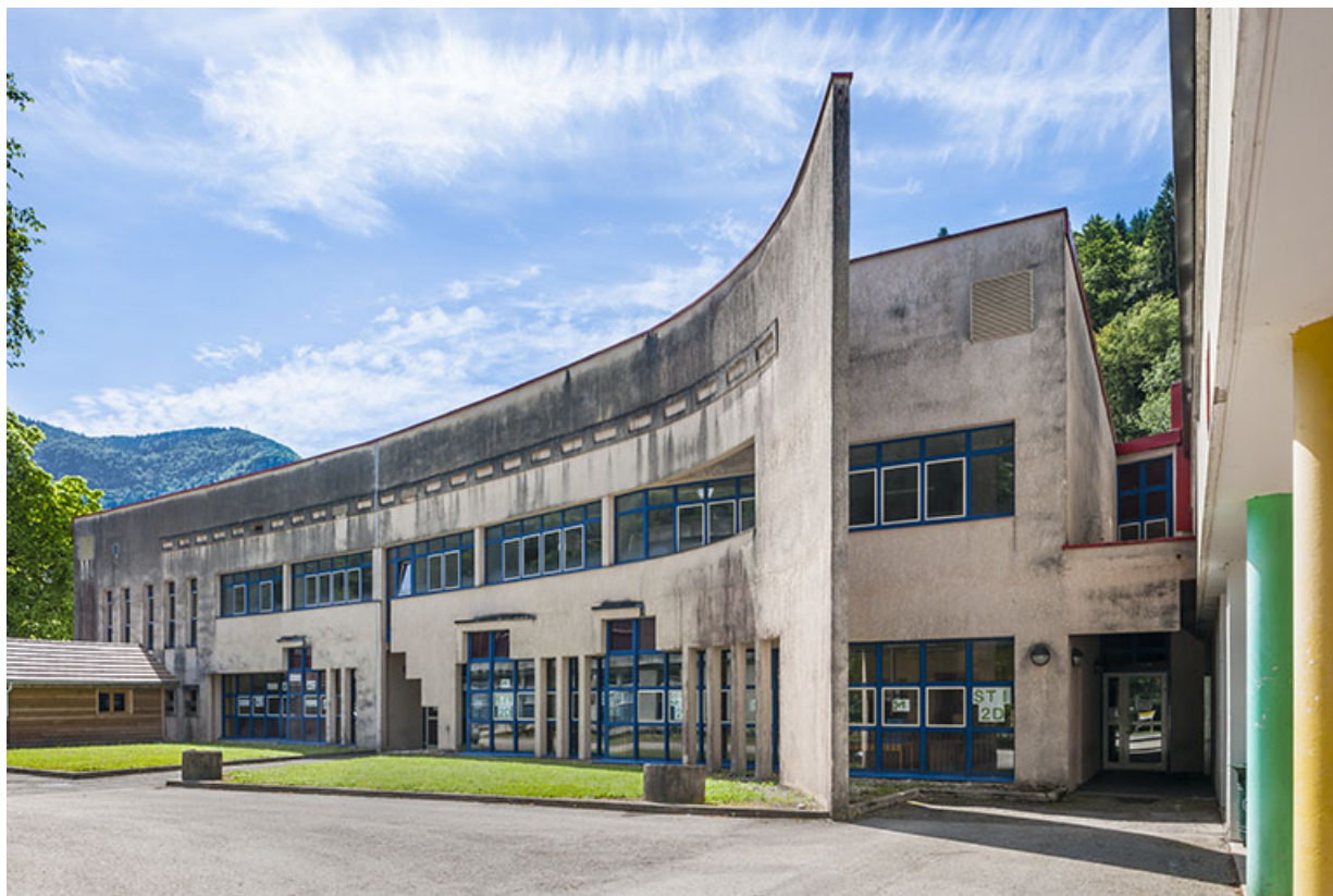
Saint-Claude, lycée de la cité scolaire du Pré Saint-Sauveur : façade de l'ancien atelier mécanique. 39, Saint-Claude rue du Tomachon
