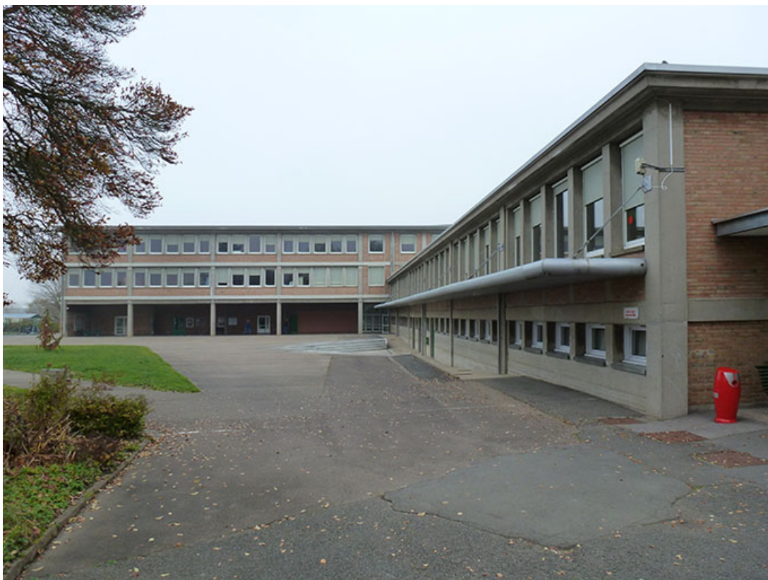
Audincourt, lycée professionnel Nelson Mandela : la cour, les façades antérieures et le préau de l'externat avant les travaux.
