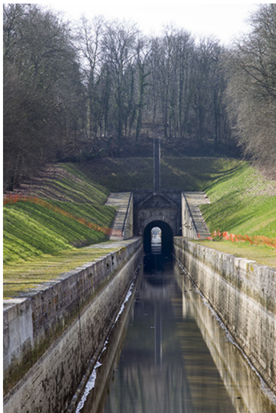
Le tunnel de Savoyeux.
