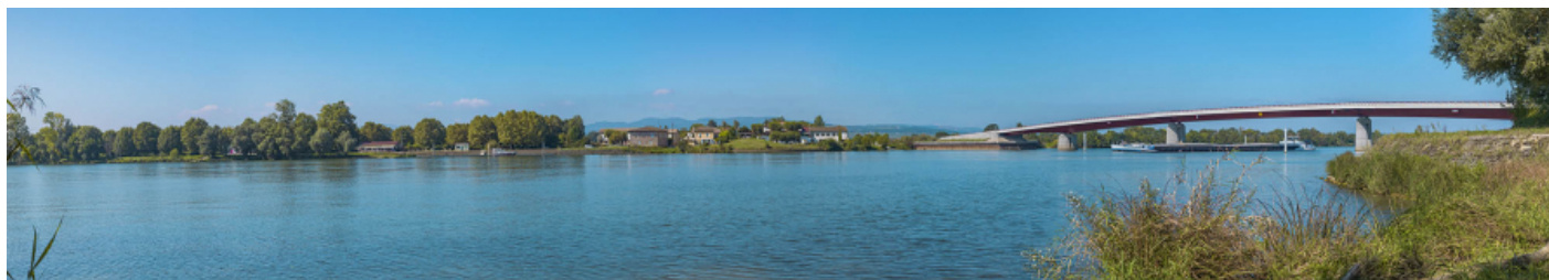
Vue d'ensemble du port et du pont d'Arciat, depuis la rive gauche de la Saône.
