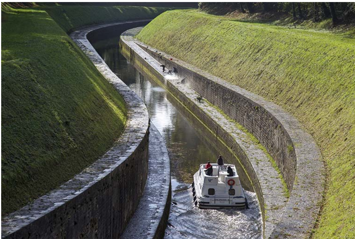
Le canal en aval formant un S.
