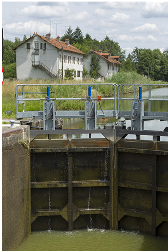
Ecluse n°44 : détail intérieur de la porte amont fermée et vue sur les cités, Demangevelle (70).
