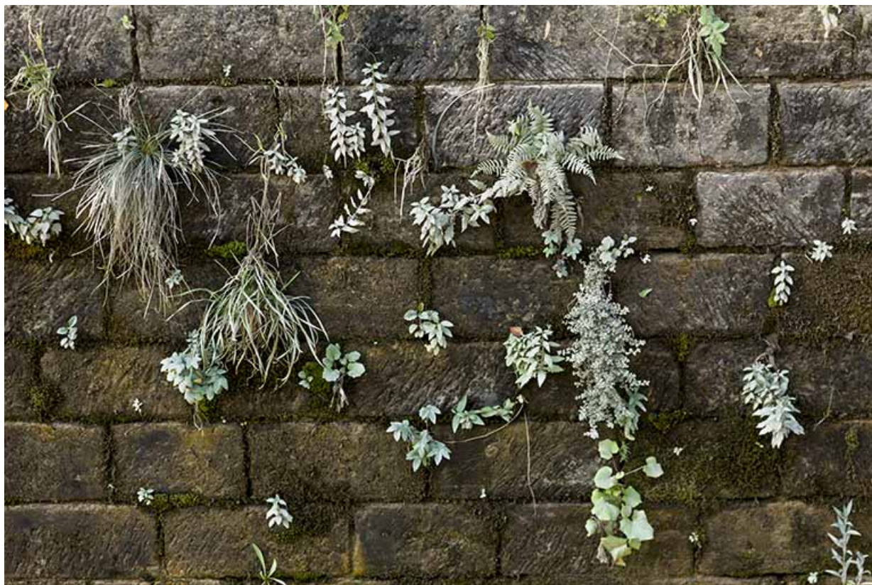
Détail sur la maçonnerie d'une écluse.
