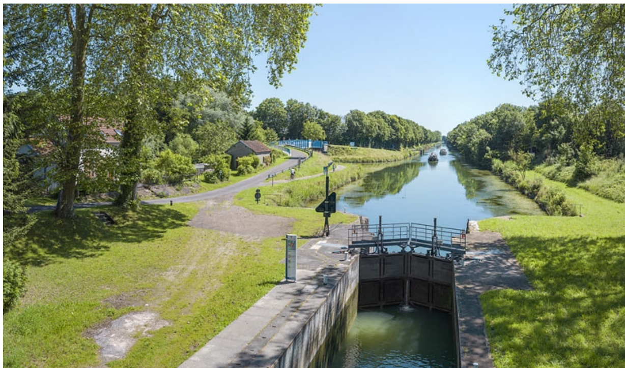
Vue d'ensemble de la dérivation depuis le site d'écluse 18.
