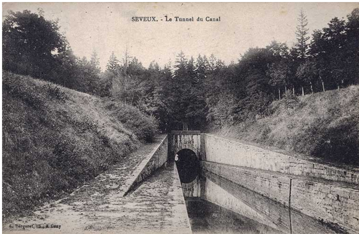
Seveux - Le Tunnel du Canal, carte postale (70).
