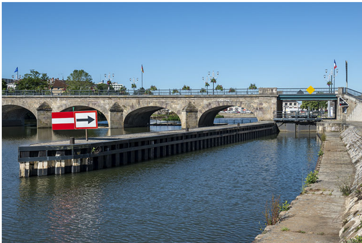
Vue amont de l'arche marinière à Gray.
