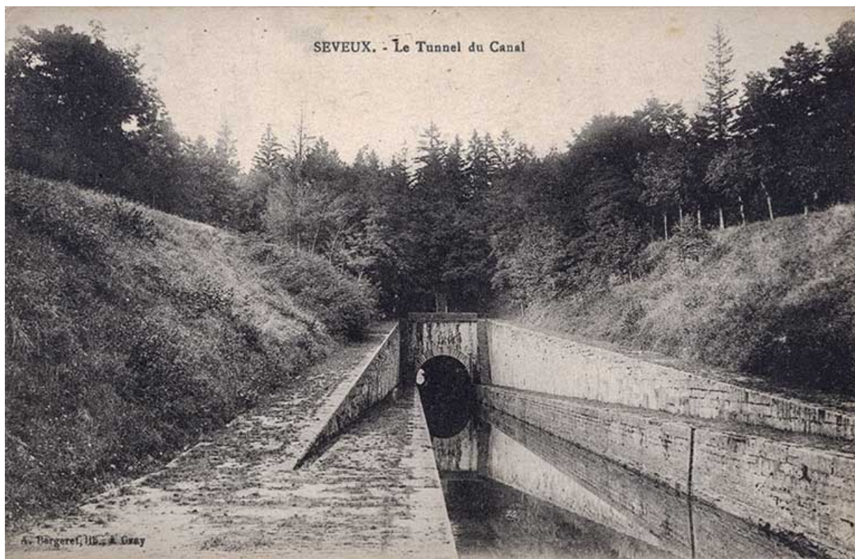
Seveux - Le Tunnel du Canal, carte postale (70).
