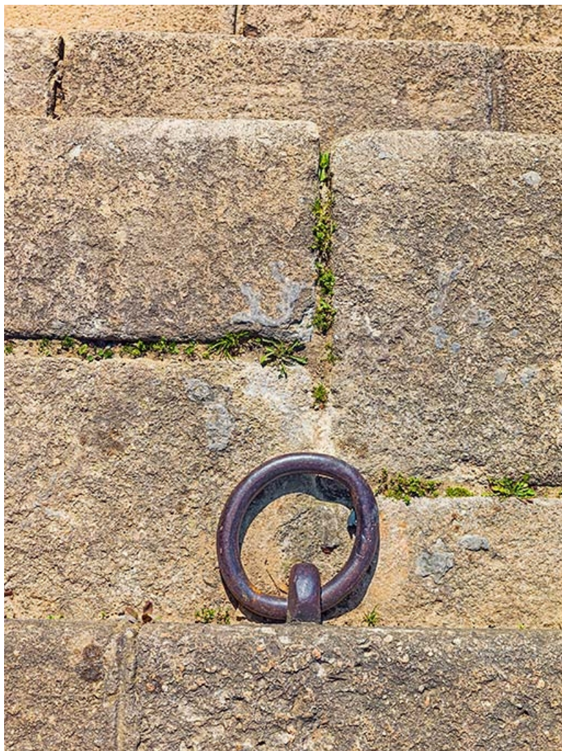
Détail d'un organeau sur le port Villiers à Chalon-sur-Saône (71).
