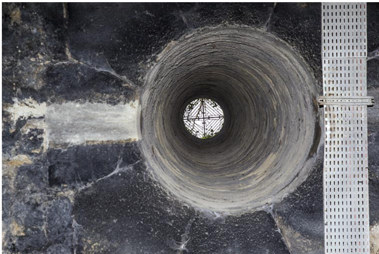
Un des puits du tunnel de Savoyeux.
