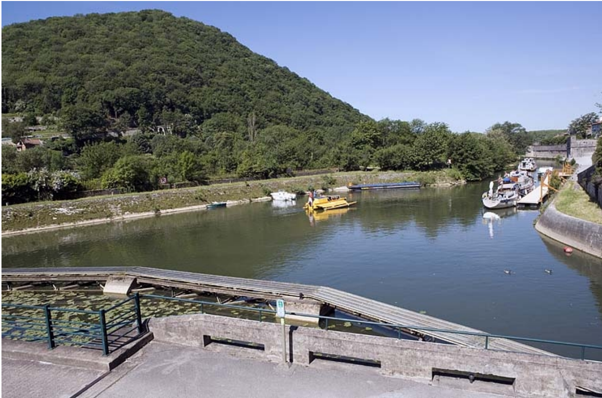
Bassin, depuis la route à l'est.
