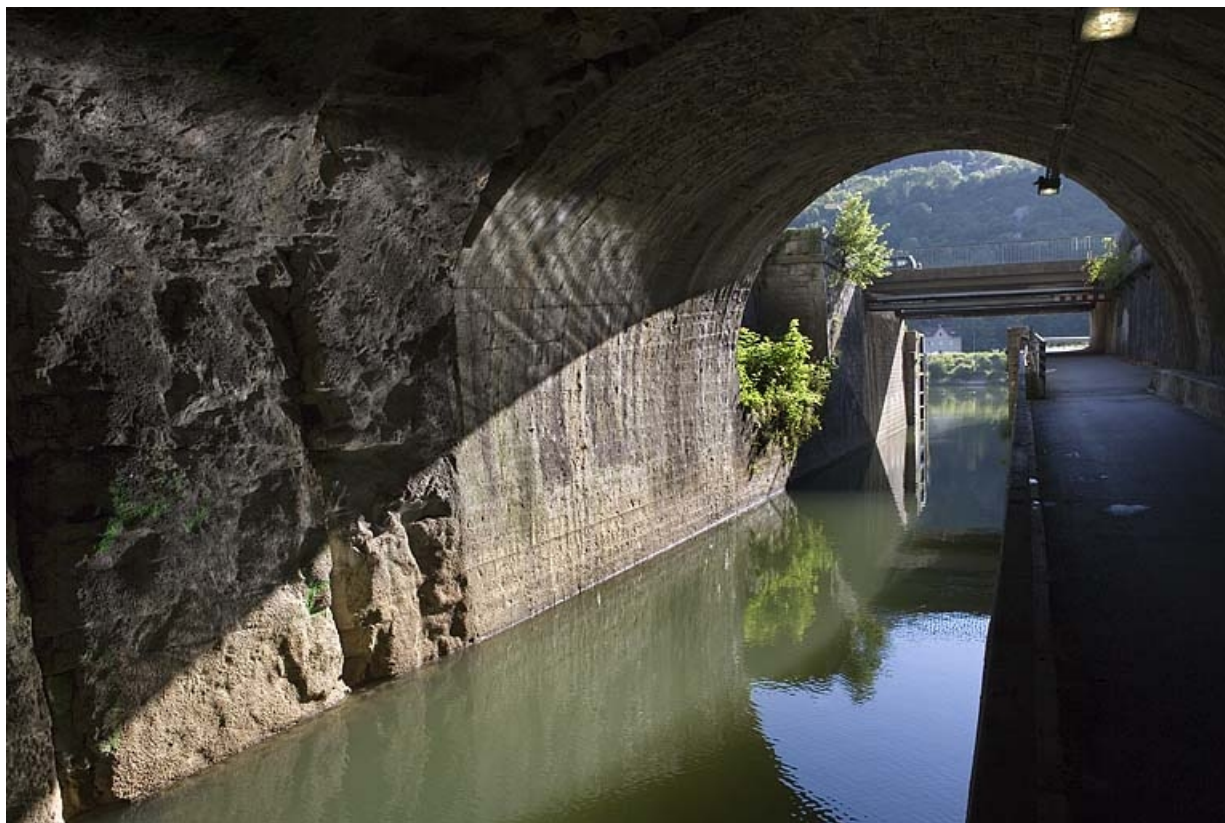
Vue d'ensemble depuis le tunnel.
