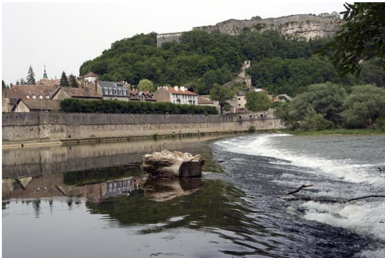
Le Doubs et le barrage de Tarragnoz, depuis la rive droite.
