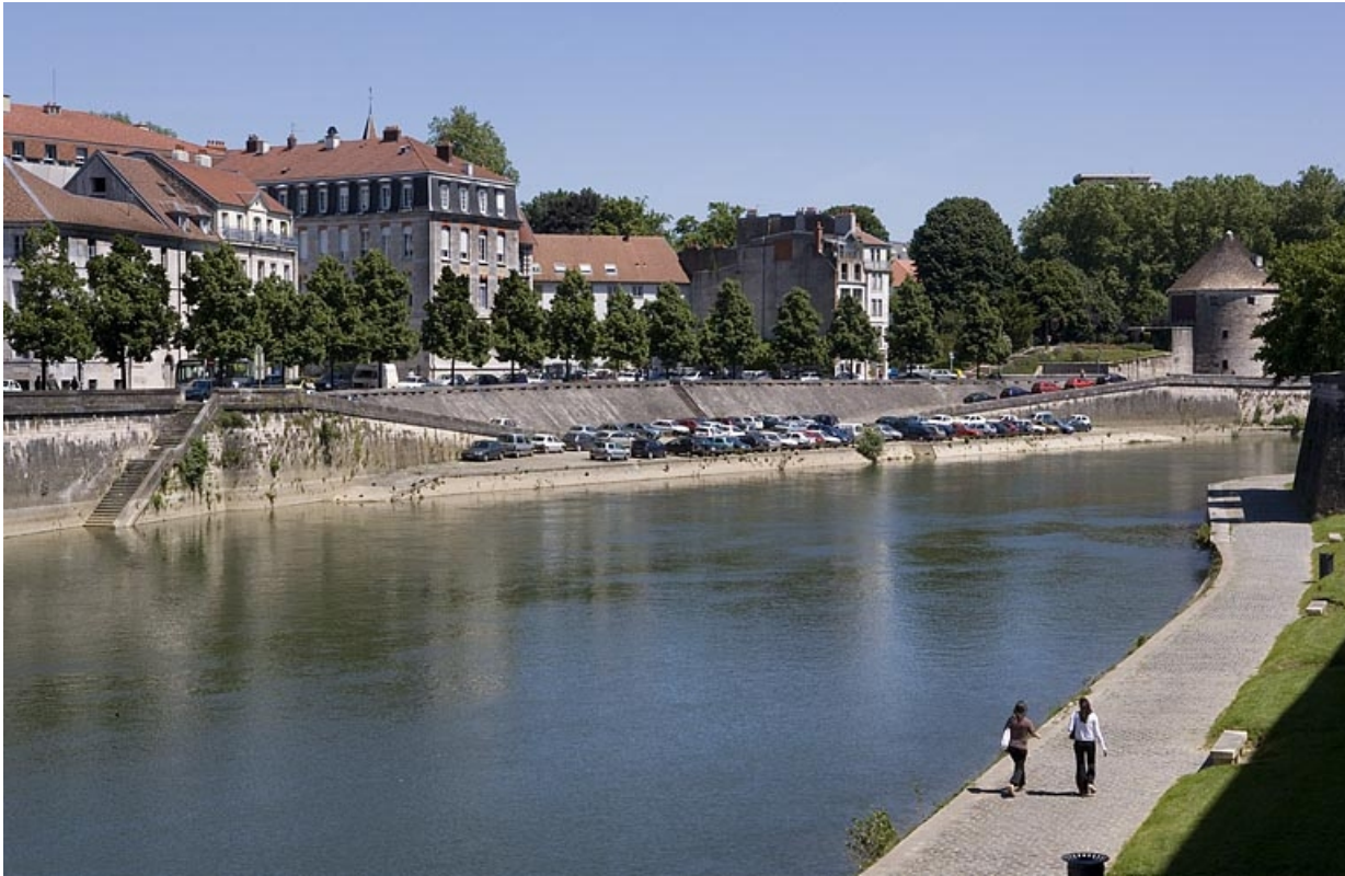
Vue d'ensemble depuis la rive gauche, en aval.
