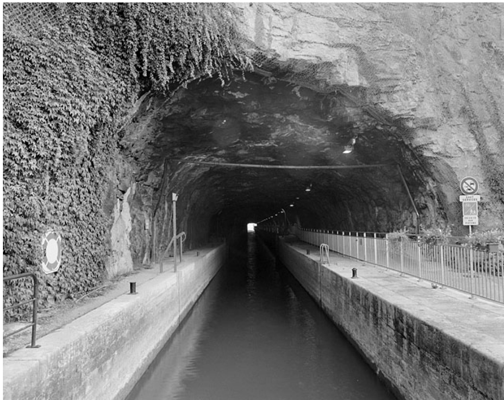
Sas de l'écluse, depuis l'aval.
