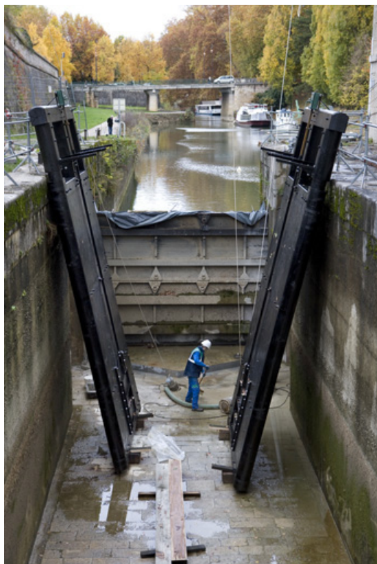
Remise en place des portes, 15 novembre 2009 : nettoyage du radier près de la porte aval.
