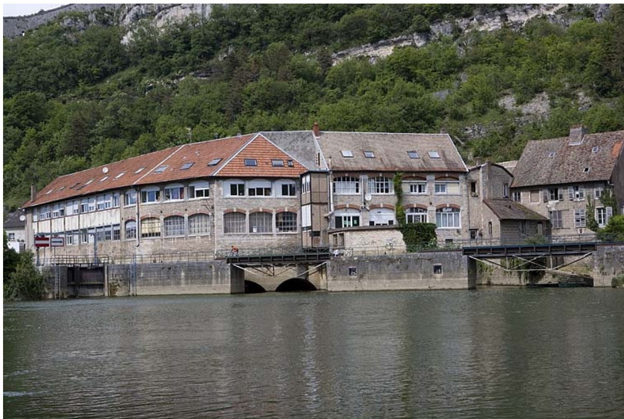
Façade postérieure (côté rivière) des ateliers de fabrication et ponts de halage.
