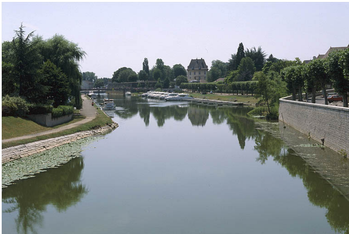
Canal entre écluses 66 et 67.
