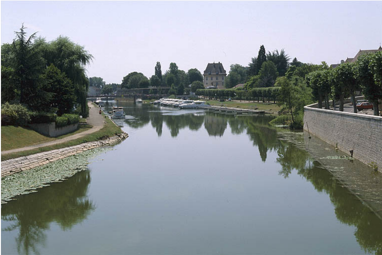
Canal entre écluses 66 et 67.
