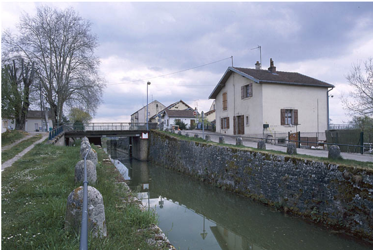
Maison éclusière, canal, chemin de halage et garde corps.
