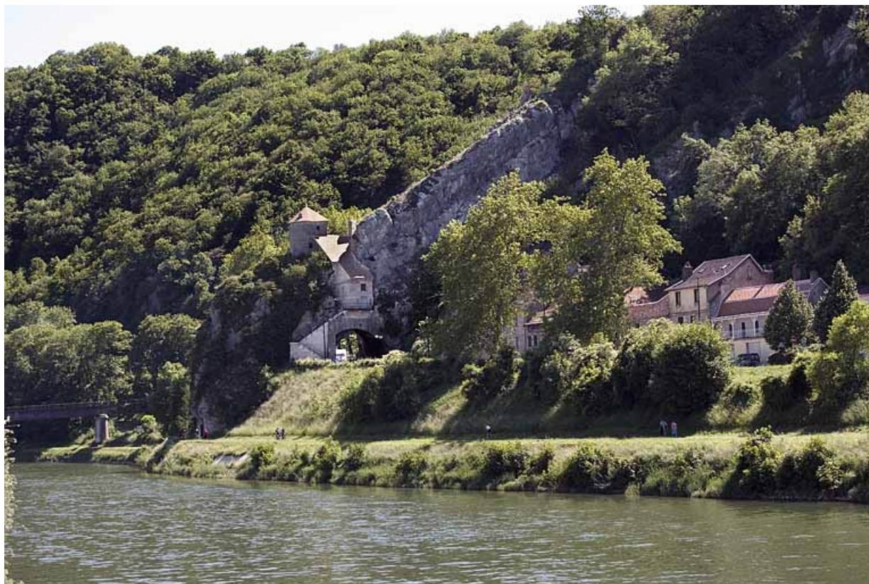
Vue d'ensemble de la partie sud depuis la rive droite : chemin de halage et Porte Taillée.
