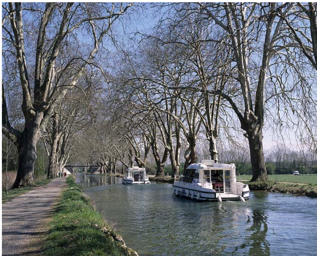
Bâteaux près du site d'écluse.
