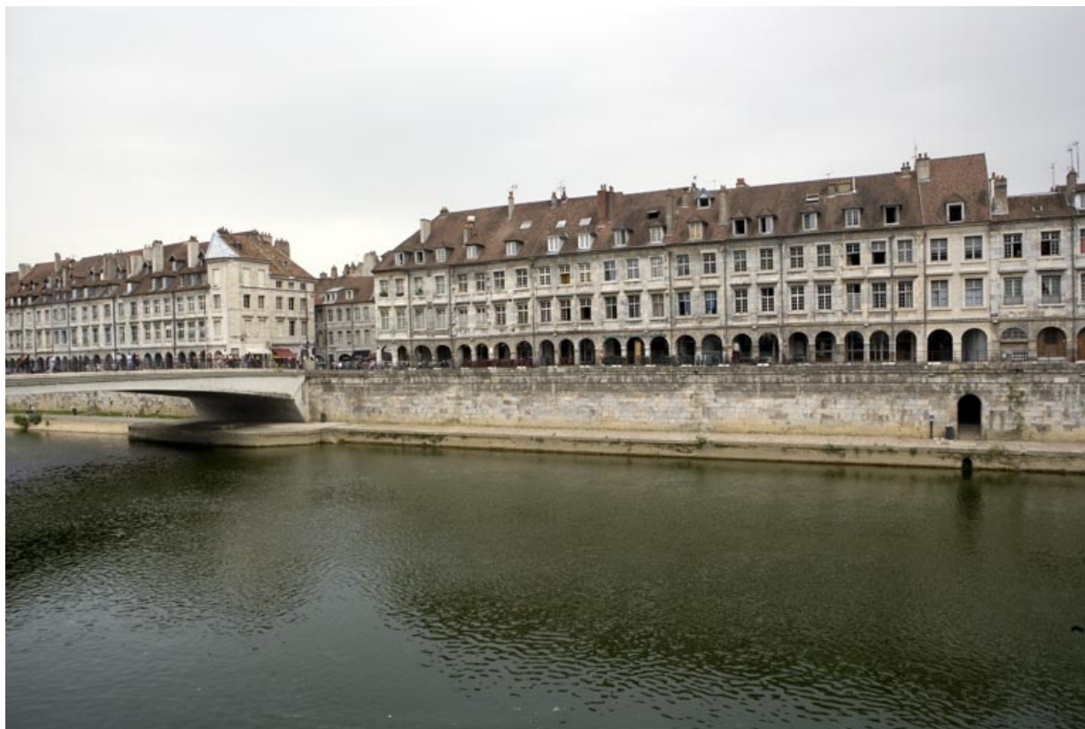
Pont Battant, quai Vauban et chemin de halage, depuis la rive droite en aval.
