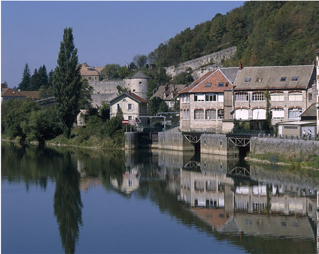
Vue d'ensemble, depuis l'aval.
