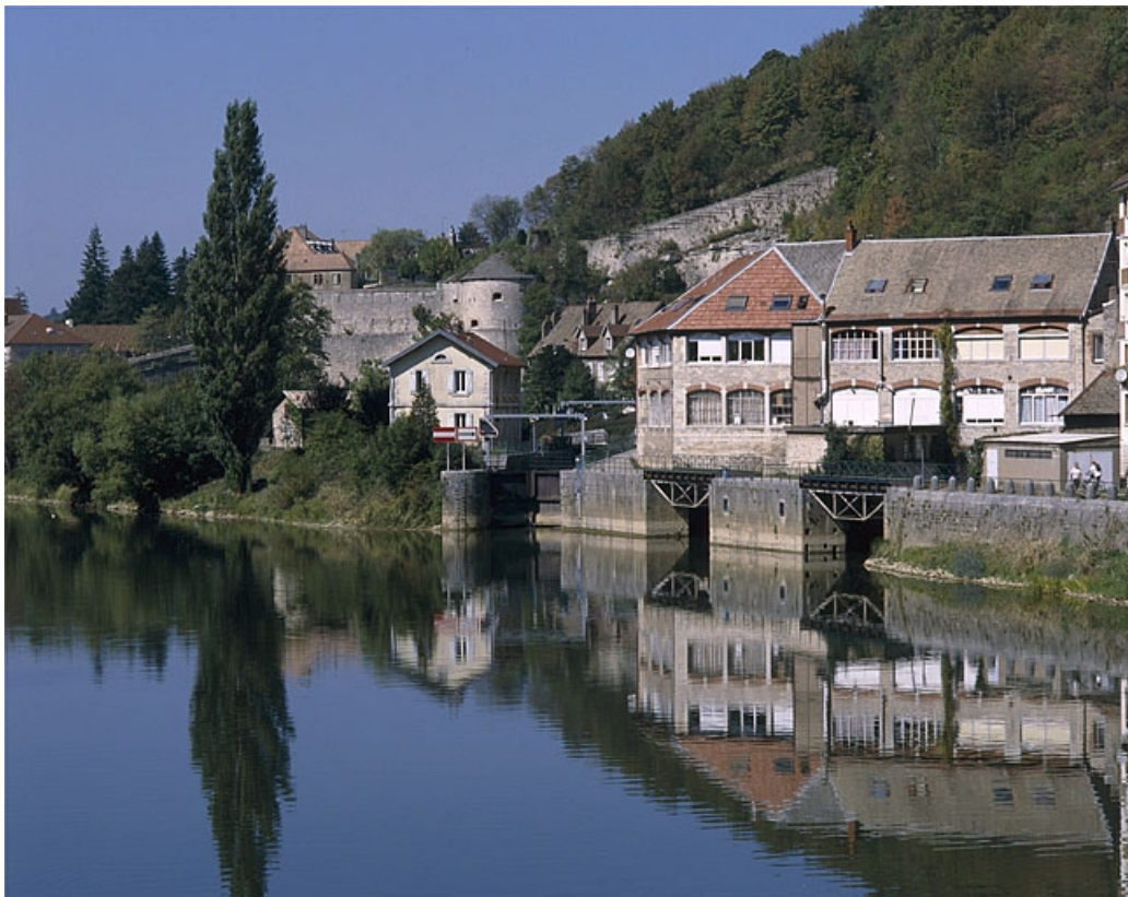
Vue d'ensemble, depuis l'aval.
