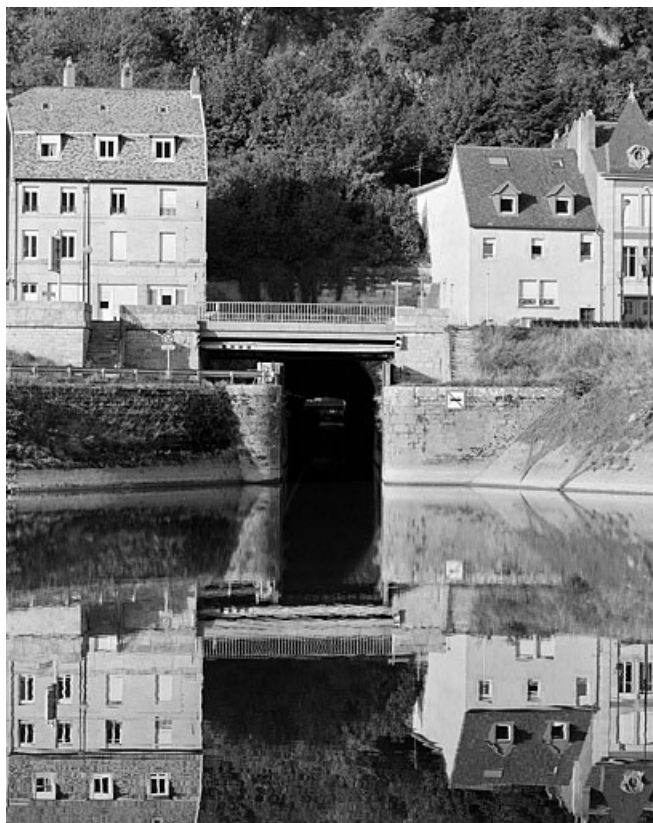
Porte de garde et extrémité amont.
