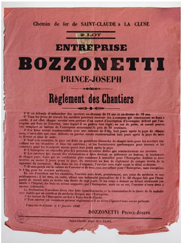
Chemin de fer de Saint-Claude à La Cluse. 2e lot. Entreprise Bozzonetti Prince-Joseph. Règlement des chantiers [affiche], 1886.
