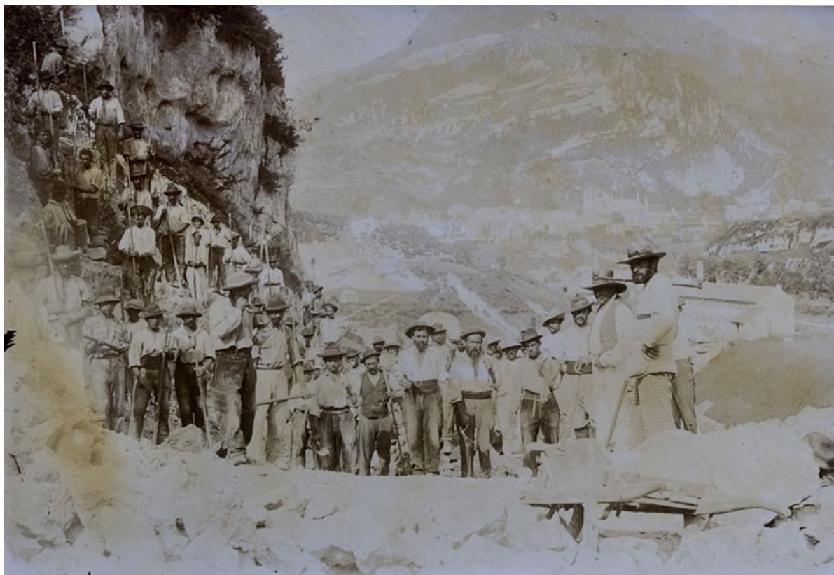
Construction de la ligne de chemin de fer Oyonnax St Claude [ouverture de la tranchée de la Grusse, à Saint-Claude], décennie 1880.
