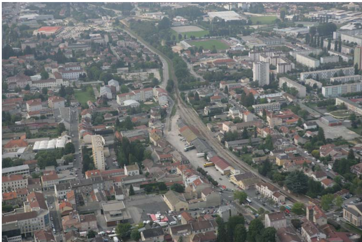
Vue aérienne du site, depuis le nord.
