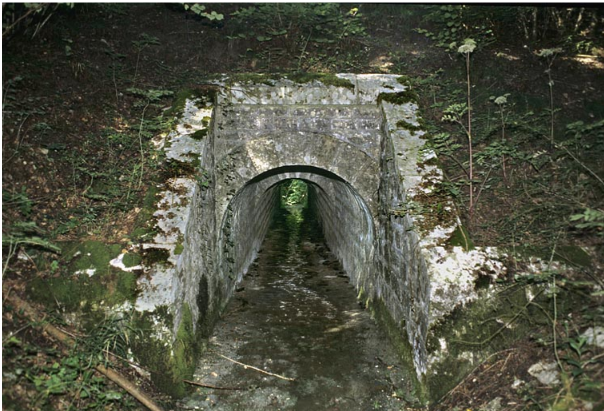
Tête amont (avec éclairage au flash).
