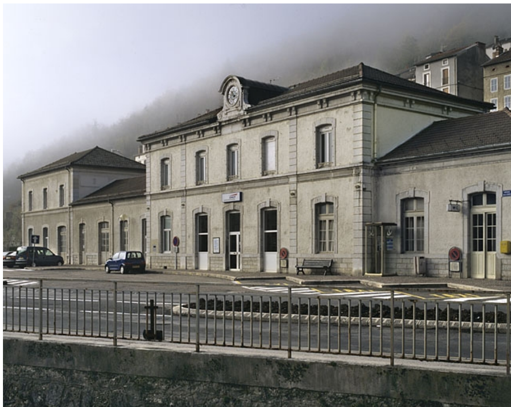
Bâtiment des voyageurs : façade antérieure, de trois quarts droite.
