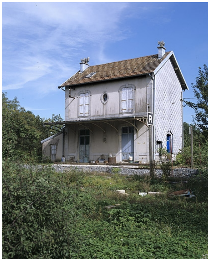
Façade postérieure, de trois quarts droite. 39, Vers-en-Montagne, 79, 80 chemin du Quai
