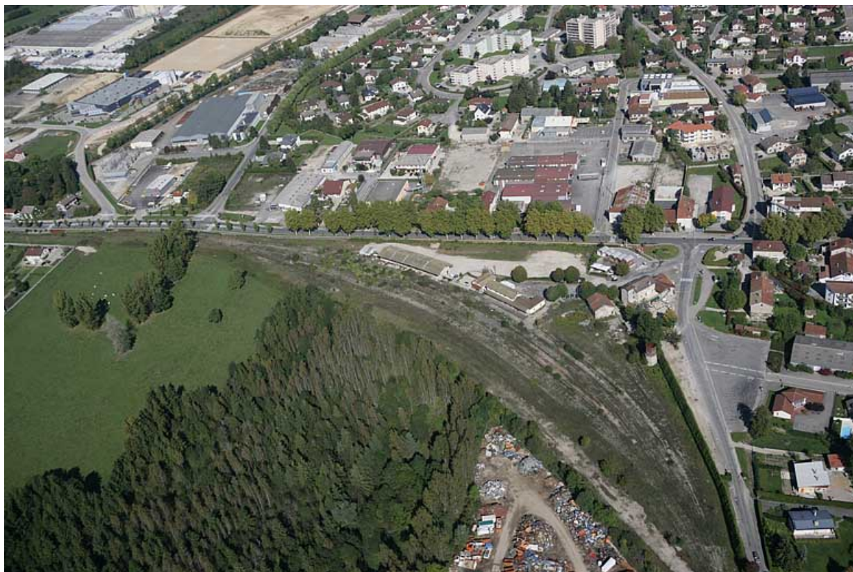
Vue aérienne du site de la gare, depuis le sud.
