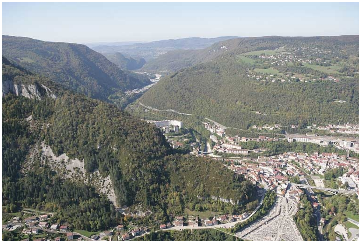
Vue aérienne de la voie et de la vallée de la Bienne à Saint-Claude, depuis l'est. PK 073.000 à 075.000.
