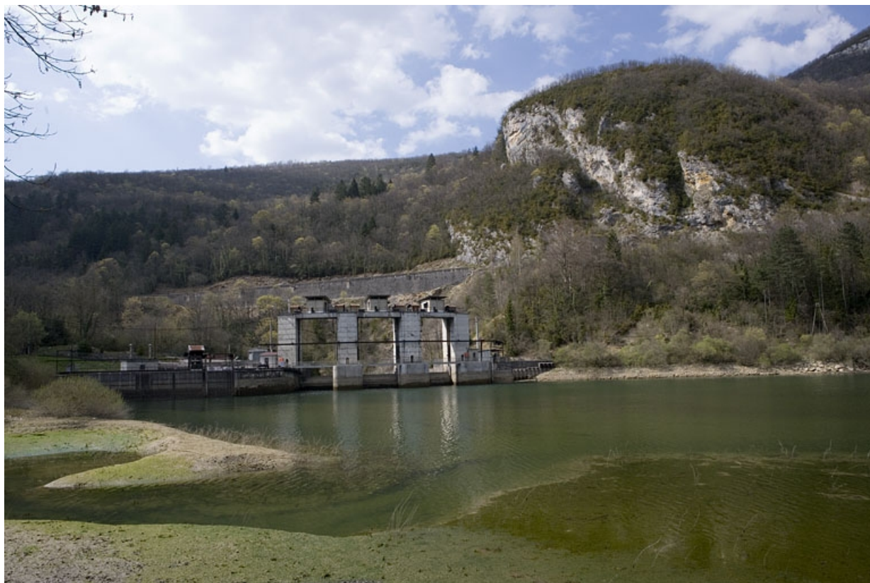
La voie et la vallée de la Bienne au barrage d'Etalles (Saint-Claude). Vers le PK 077.100.
