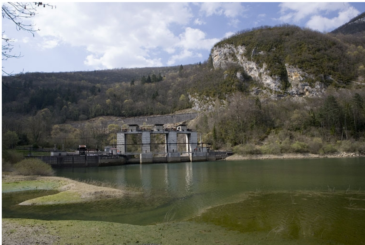
La voie et la vallée de la Bienne au barrage d'Etaves (Saint-Claude). Vers le PK 077.100.
