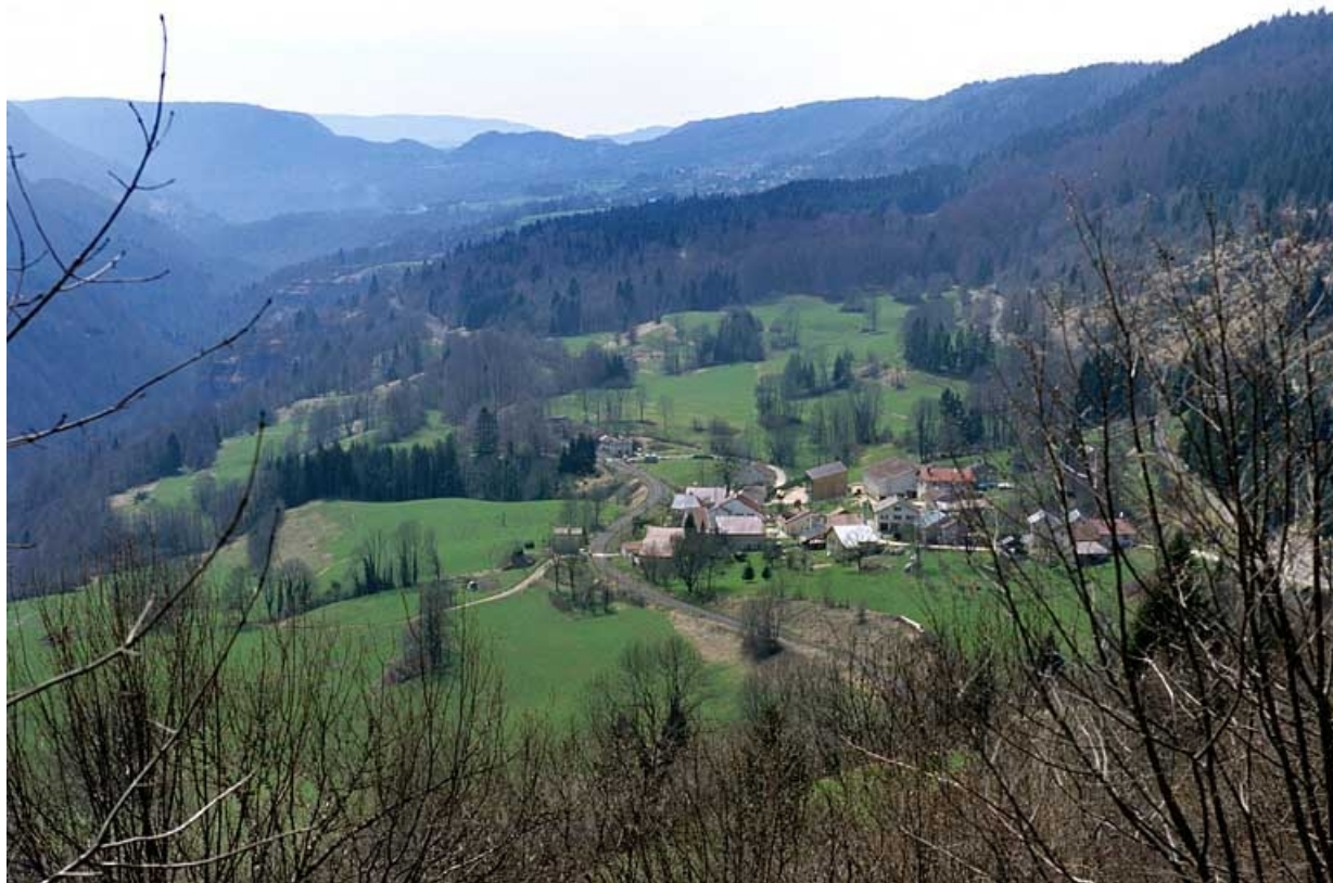
La voie au village de Lézat. PK 058.100 - 058.400.
