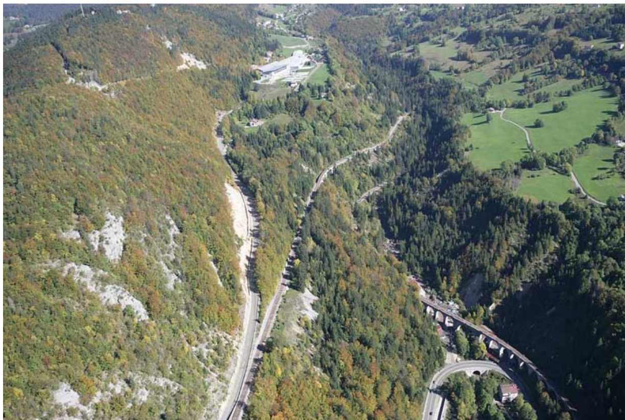
Vue aérienne des ouvrages situés entre les viaducs des Crottes et de la Source (Morbier, Bellefontaine, Morez), depuis le sud-ouest. PK de 045.200 à 048.000.
