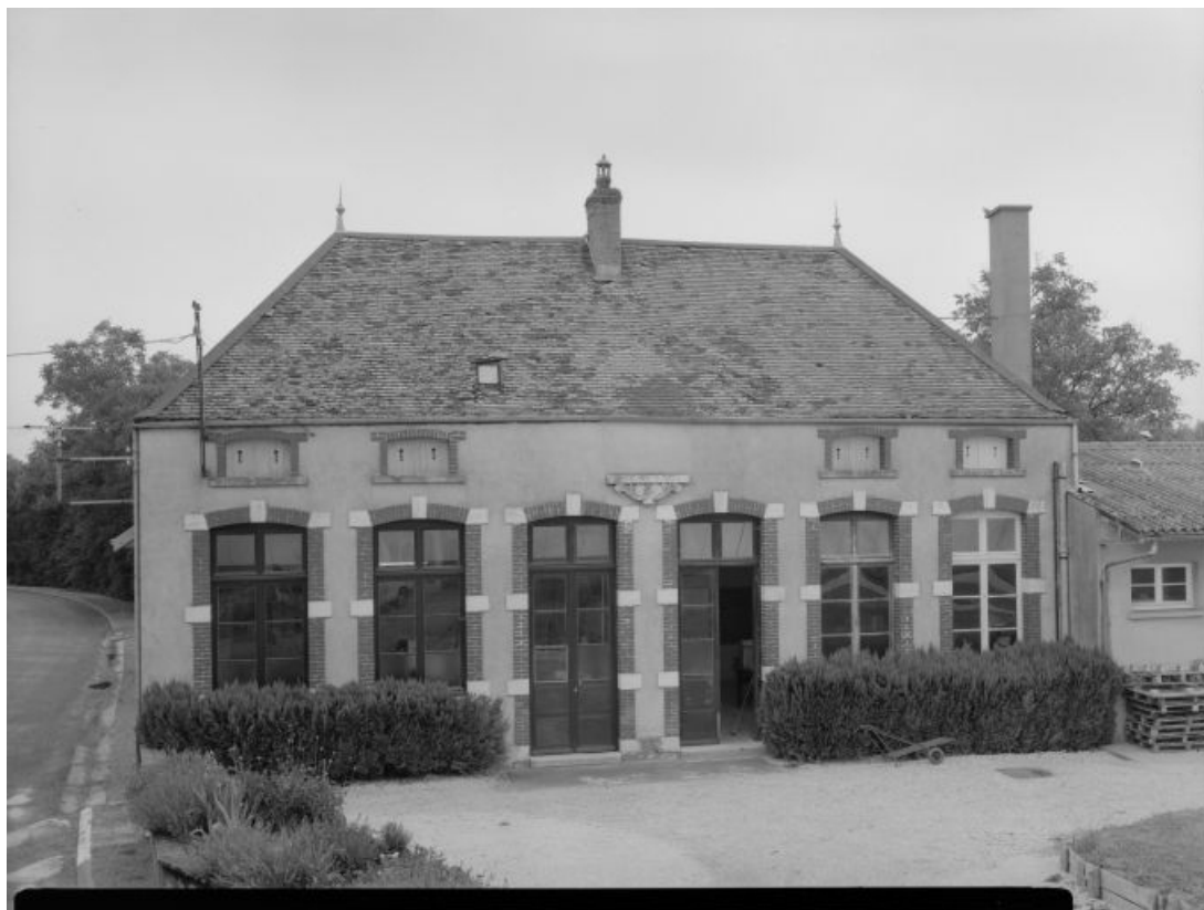
Bâtiment annexe, façade antérieure
