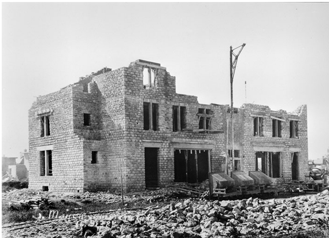
Travaux de construction de l'immeuble avec boutiques, 2, place de la Victoire, façade postérieure et face gauche. 39, Tavaux, lieudit : Tavaux Cité
