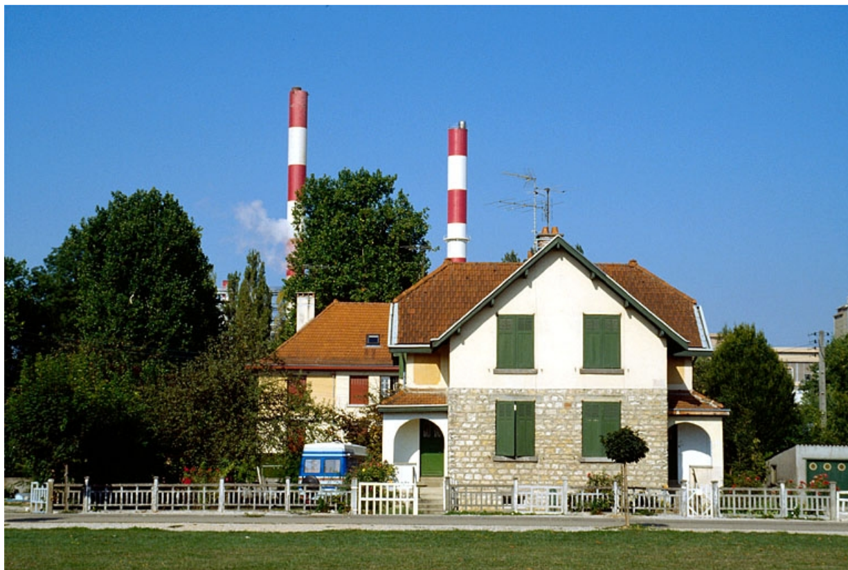
Maison d'ouvriers de type 10, 2, 4 rue Voltaire.
