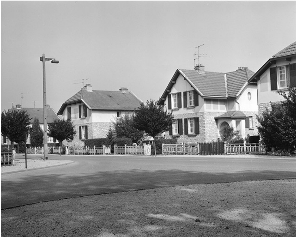
Maisons d'ouvriers de types 10 et 10A, 49, 51, 53, 55 et 57, 59 avenue de la Paix. 39, Tavaux, lieudit : Tavaux Cité
