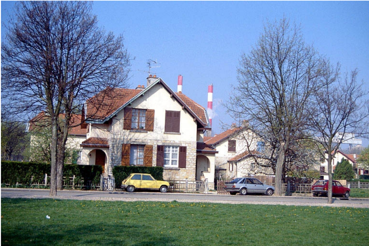
Maison d'ouvriers de type 10, 2, 4 avenue Albert 1er.
