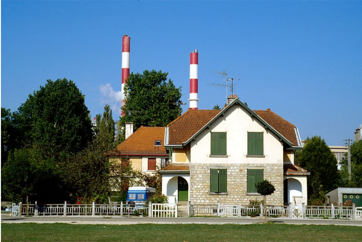
Maison d'ouvriers de type 10, 2, 4 rue Voltaire.
