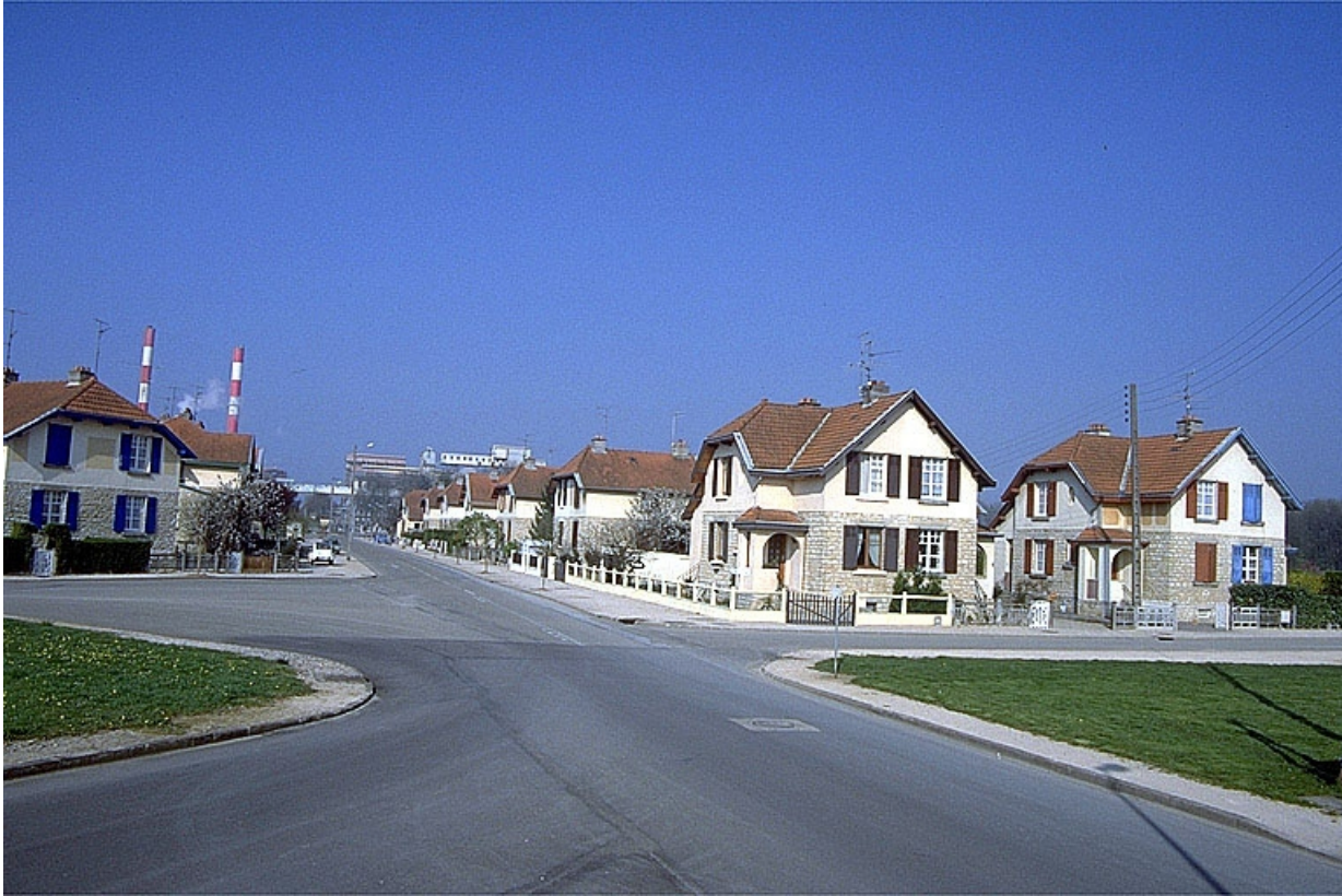
Avenue Victor Hugo, vue depuis l'angle de l'avenue Cardinal Mercier. 39, Tavaux, lieudit : Tavaux Cité
