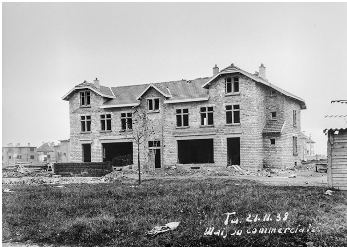
Travaux de construction de l'immeuble avec boutiques, 2 place de la Victoire, façade antérieure.
