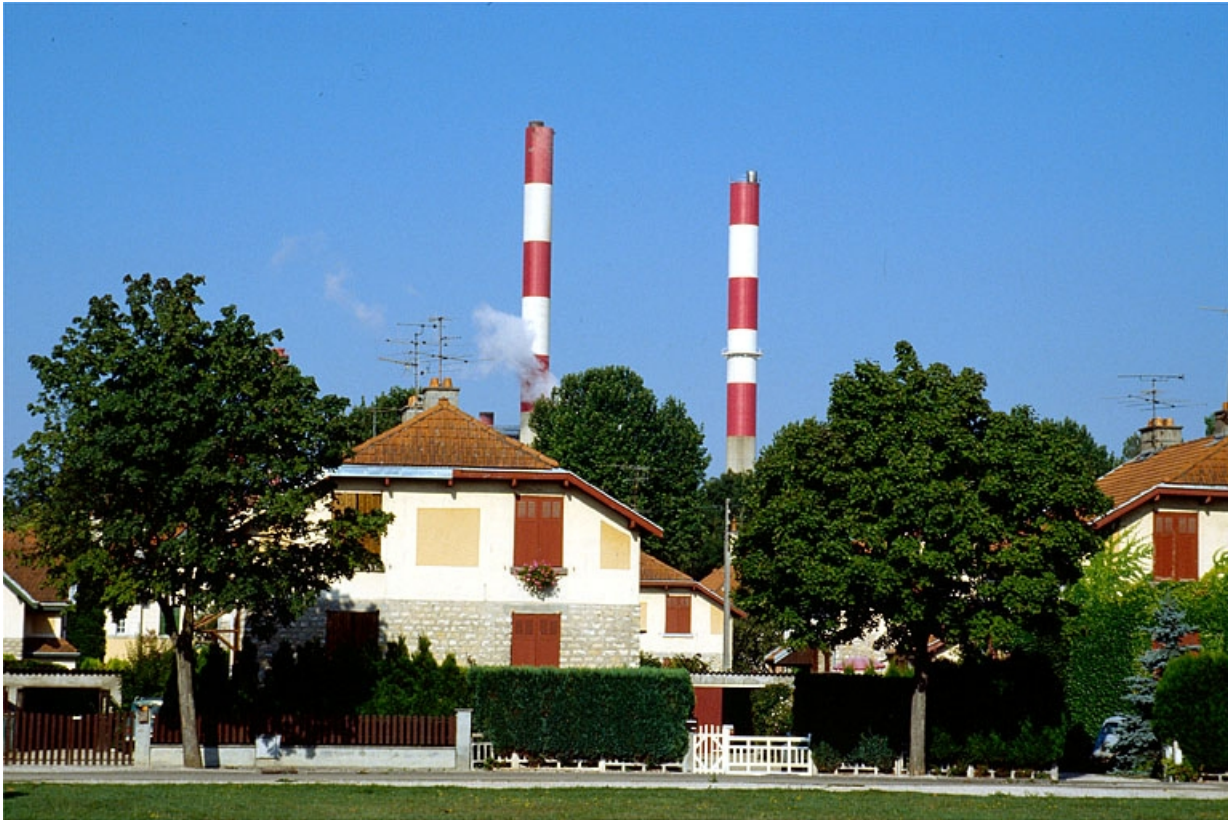
Maison d'ouvriers de type 10A, 10, 12 rue Carnot.
