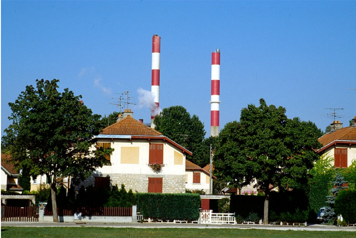
Maison d'ouvriers de type 10A, 10, 12 rue Carnot.
