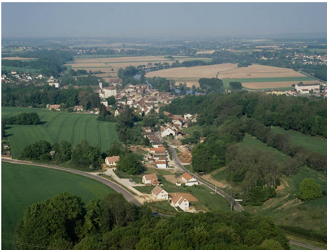
Cité ouvrière des Madiottes et village vus depuis l'est, photographie aérienne. 39, Fraisans rue de la Gare
