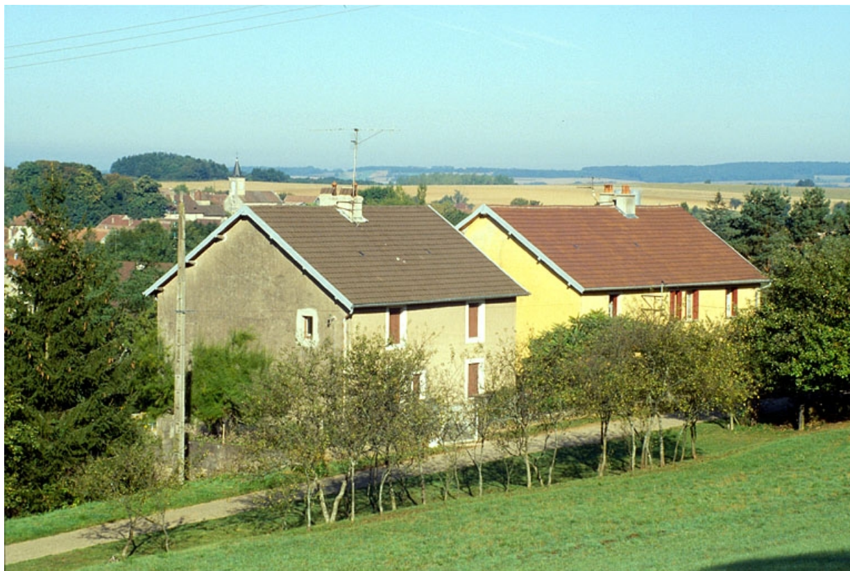
La "Caserne" (logement d'ouvriers A, B) vue de trois quarts gauche.
