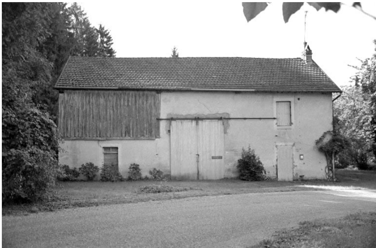
Façade antérieure du logement de contremaître (D).
