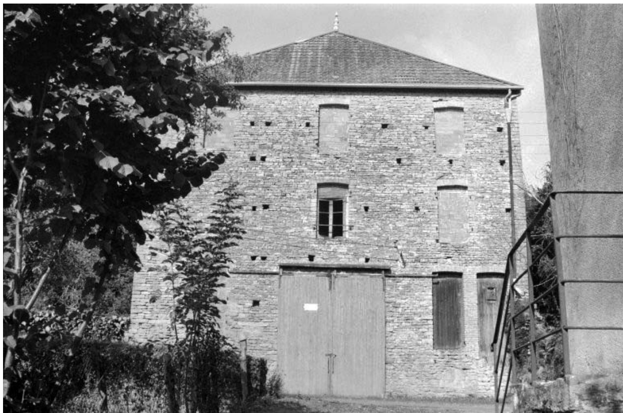
Façade antérieure du logement d'ouvriers inachevé, commune de Taxenne.
