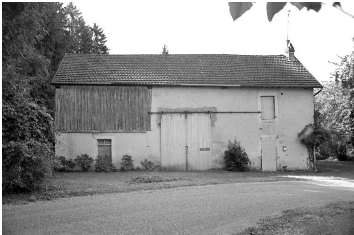
Façade antérieure du logement de contremaître (D).
