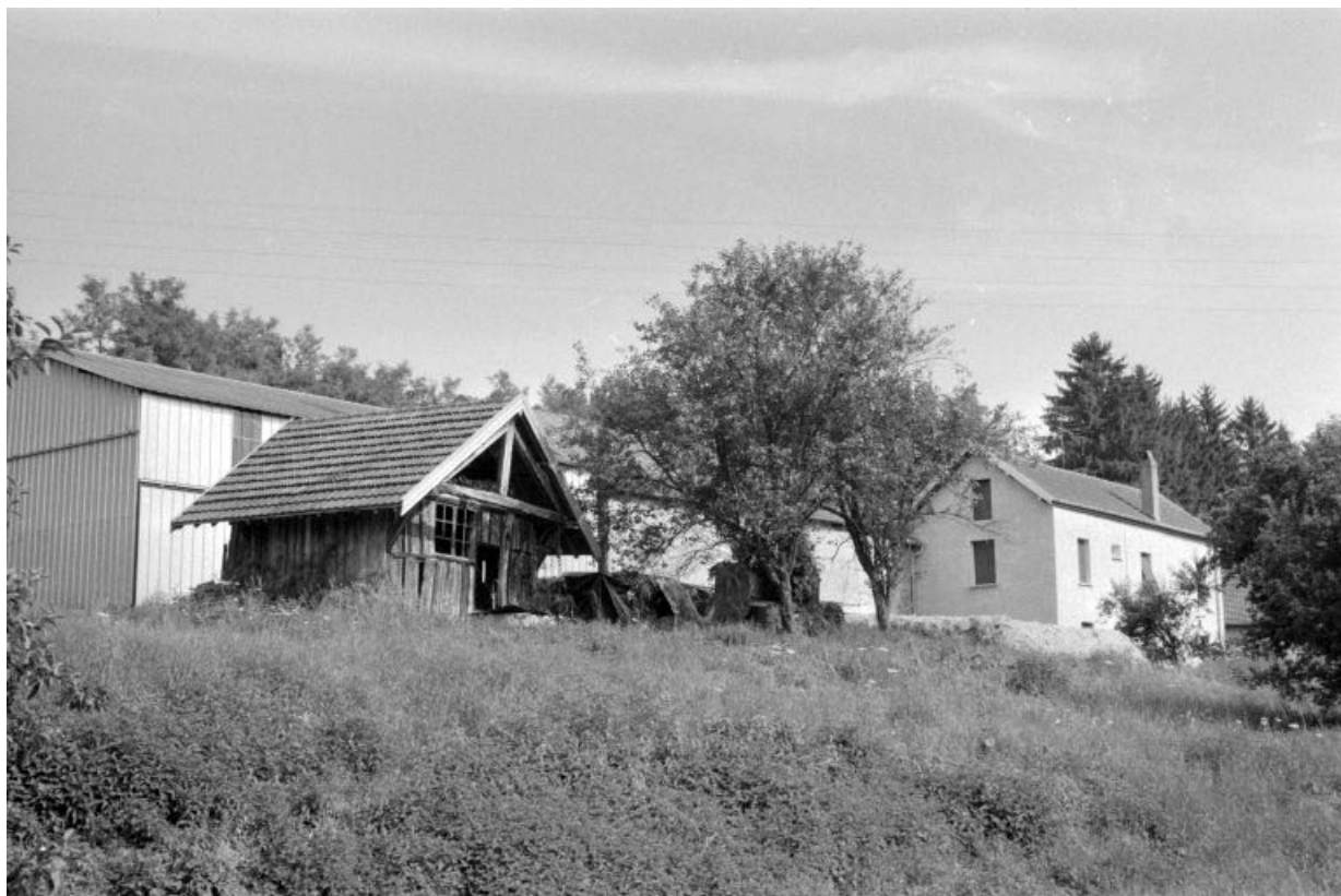
Logement patronal et bureau (C) vus du nord-ouest.
