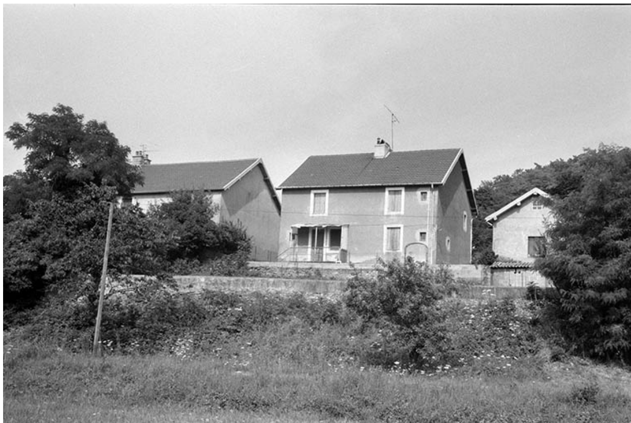
Façade postérieure de la "Caserne" (A, B).
