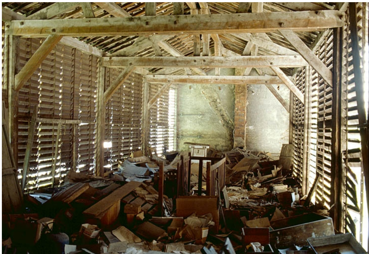
Pièce de séchage : intérieur de l'étage de comble.
