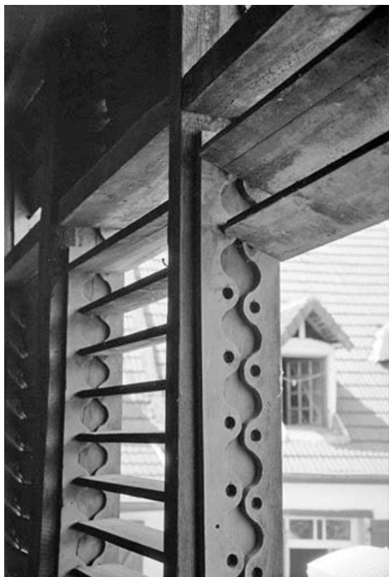
Pièce de séchage, étage de comble : détail du système de fermeture à lamelles mobiles.
