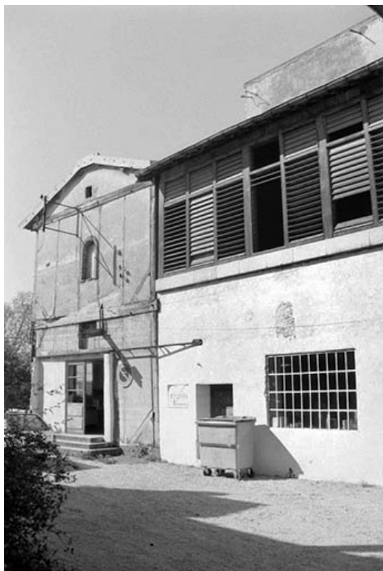
Pièce de séchage (F, G), depuis la cour.
