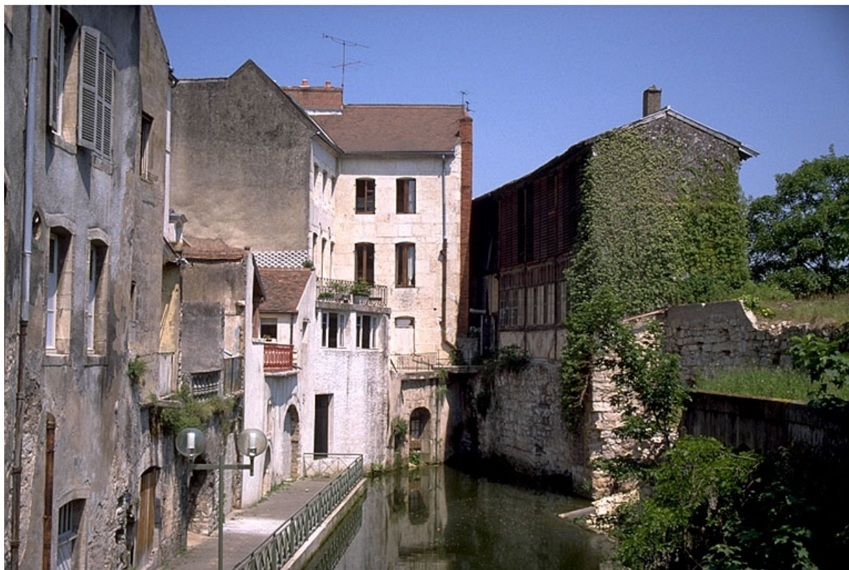
Logement (E) et pièce de séchage, depuis le canal des Tanneurs.
