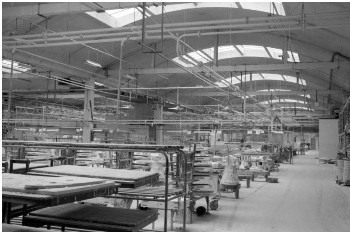
Atelier de coulage C (9), intérieur.
