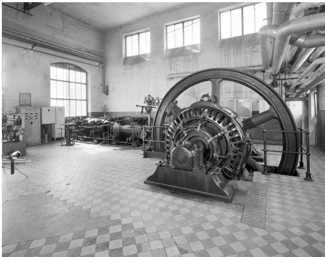
Salle des machines (10) : machine à vapeur Crepelle et Cie. 39, Dole, 65 rue de Crissey
