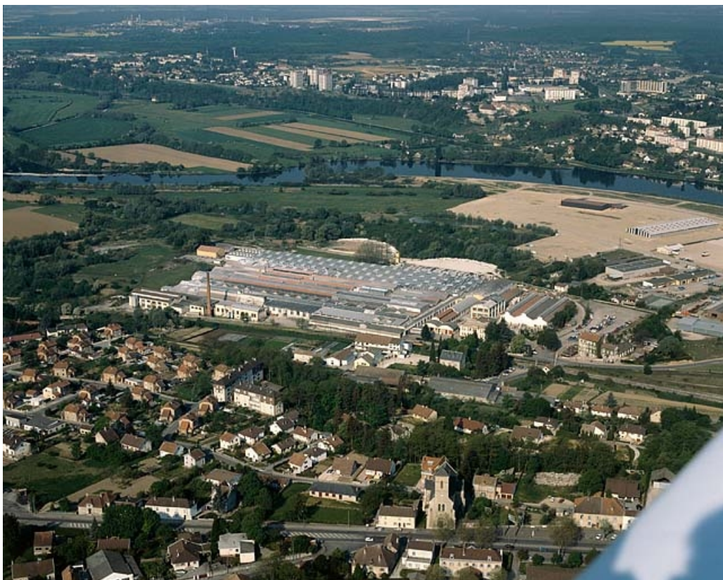
Vue aérienne depuis le nord-est.
