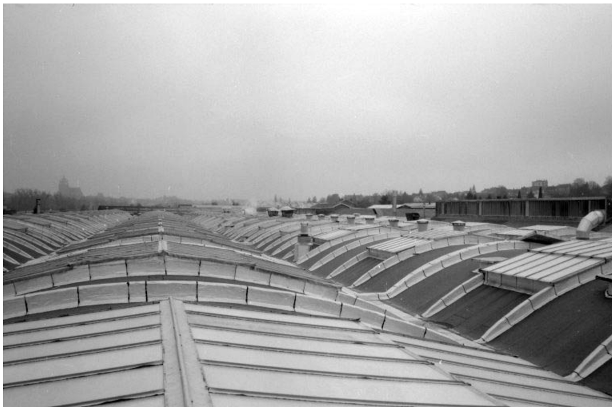
Toiture de l'atelier de coulage C (9), depuis le sud.
