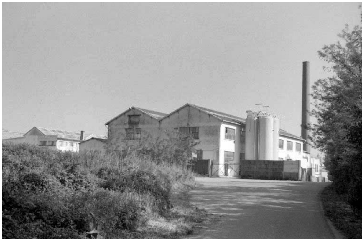
Atelier de coulage des moules (12), depuis le sud.
