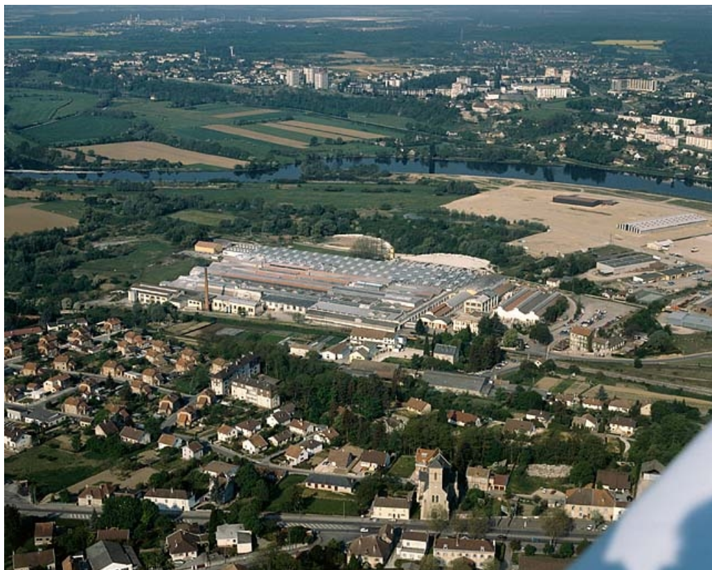
Vue aérienne depuis le nord-est.
