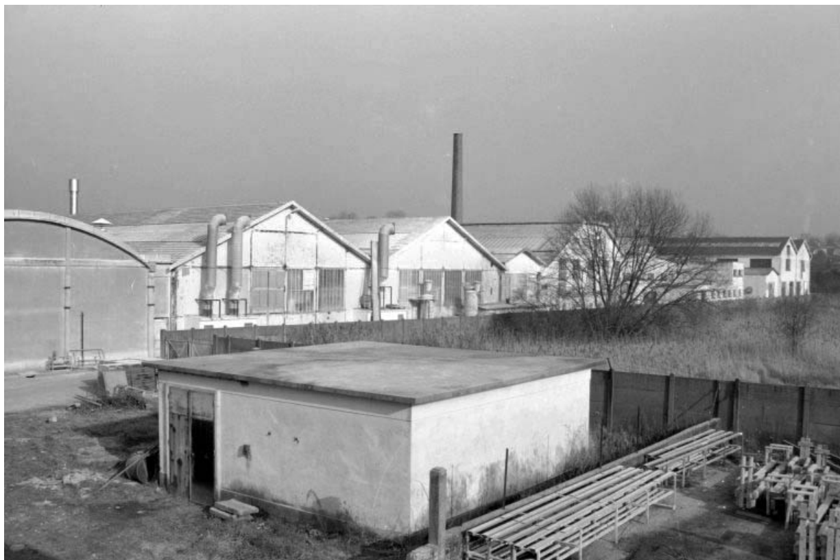
Murs pignons sud de l'atelier de fabrication (9), depuis l'ouest.
