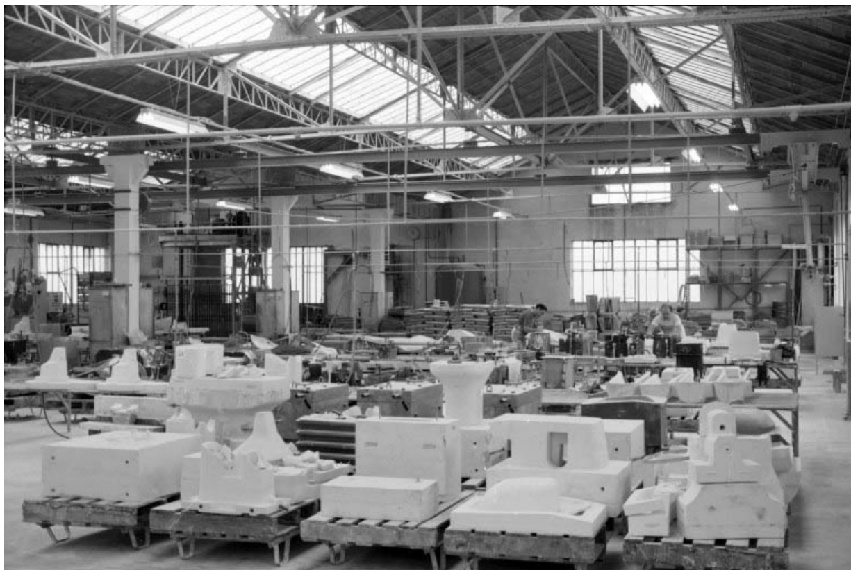
Atelier de coulage des moules (12), intérieur. 39, Dole, 65 rue de Crissey
