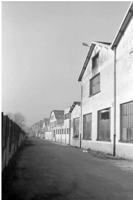
Murs pignons sud de l'atelier de fabrication (9), depuis l'est. 39, Dole, 65 rue de Crissey
