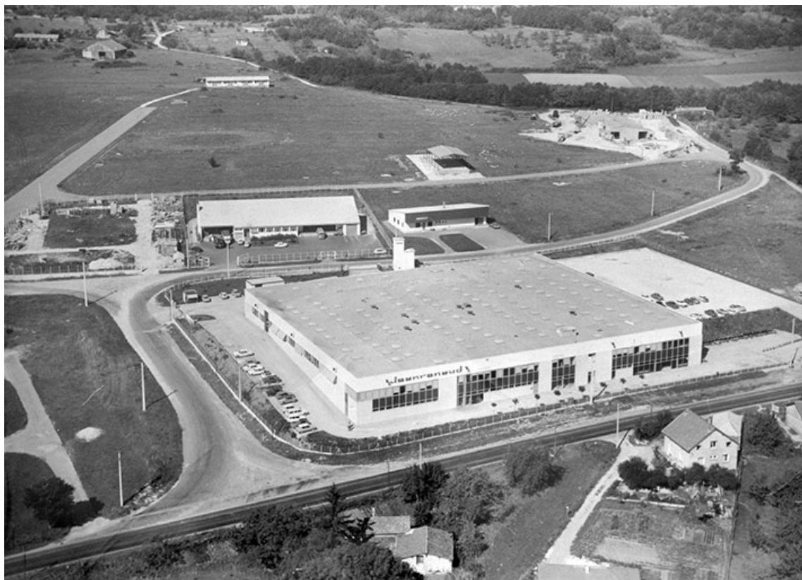
L'usine 3 vue de l'est [détail d'une vue aérienne].
