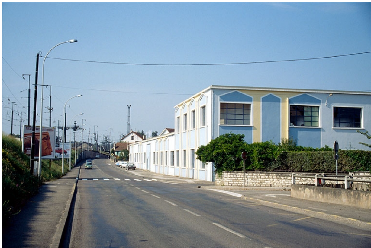
Usine 2, vue de trois quarts droit.
