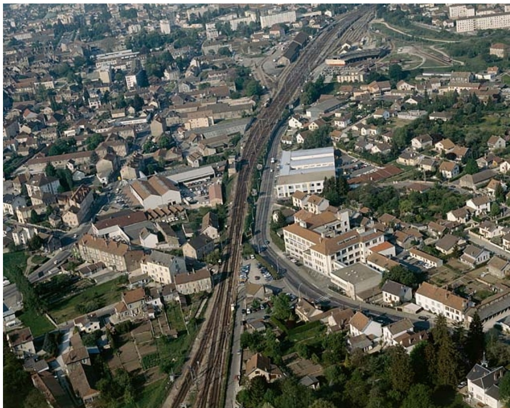
Vue aérienne des usines 1 et 2, depuis le sud.
