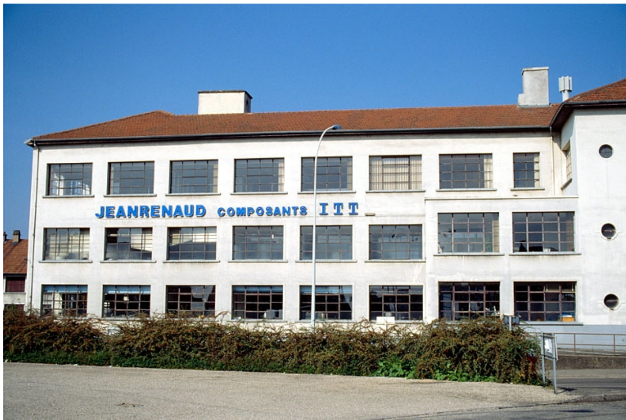
Usine 1 : façade antérieure de l'aile (B). 39, Dole, 1, 2 rue Louis de la Verne
