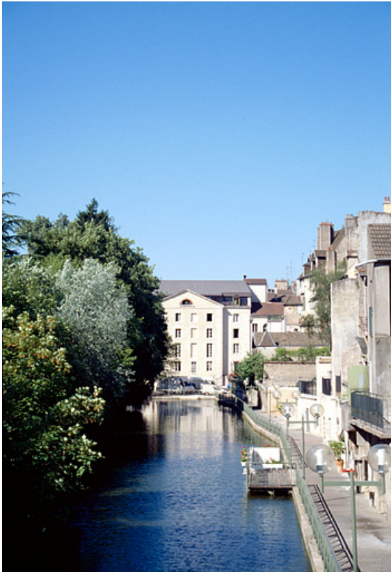
Façade postérieure. 39, Dole rue du Prélot
