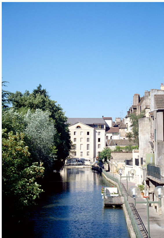
Façade postérieure. 39, Dole rue du Prélot
