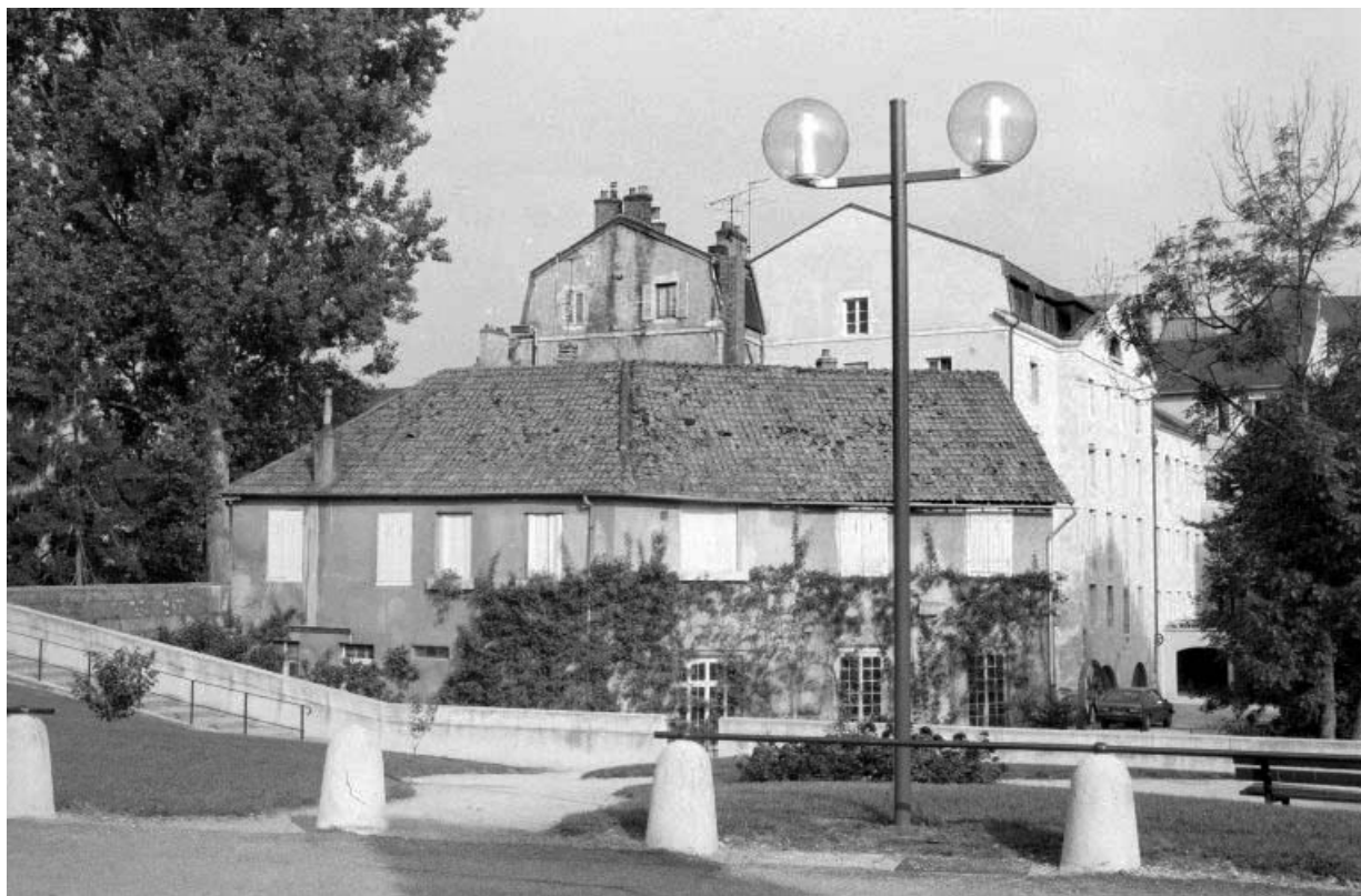
Atelier de réparation et bureau, depuis l'est.
