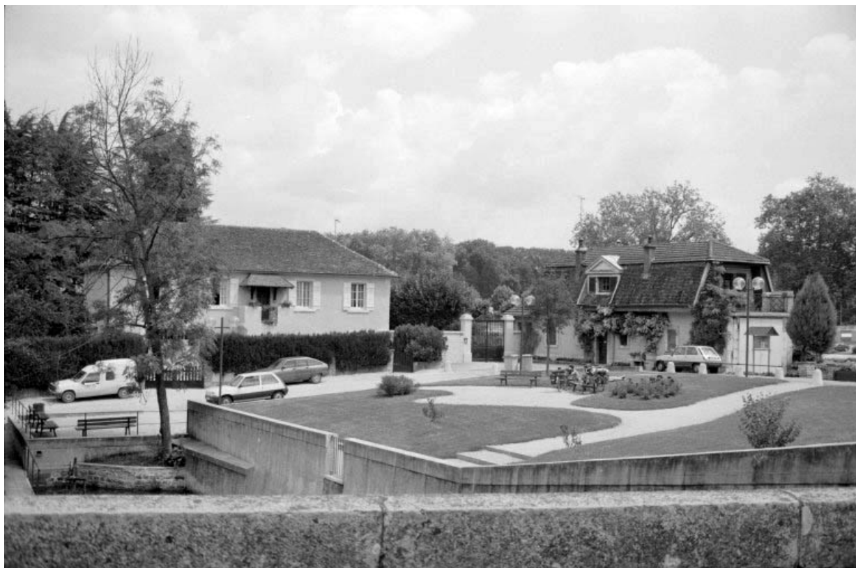
Logement d'ouvriers, vus depuis l'ouest.
