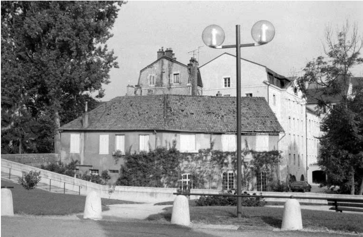
Atelier de réparation et bureau, depuis l'est.
