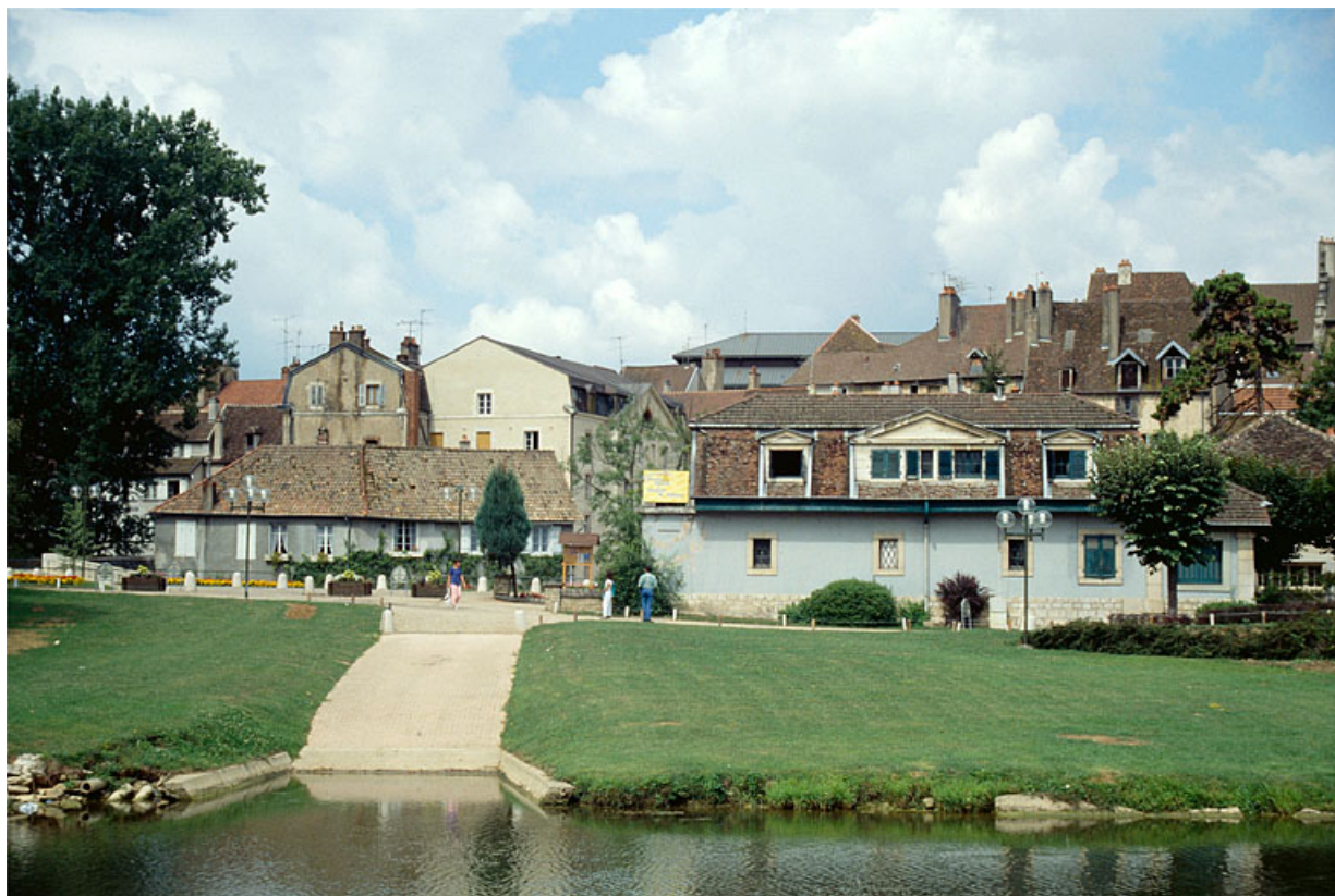
Bureau et logement d'ouvriers (H), depuis l'est. 39, Dole rue du Prélot
