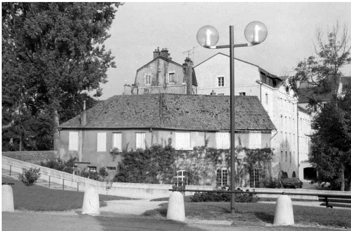
Atelier de réparation et bureau, depuis l'est.
