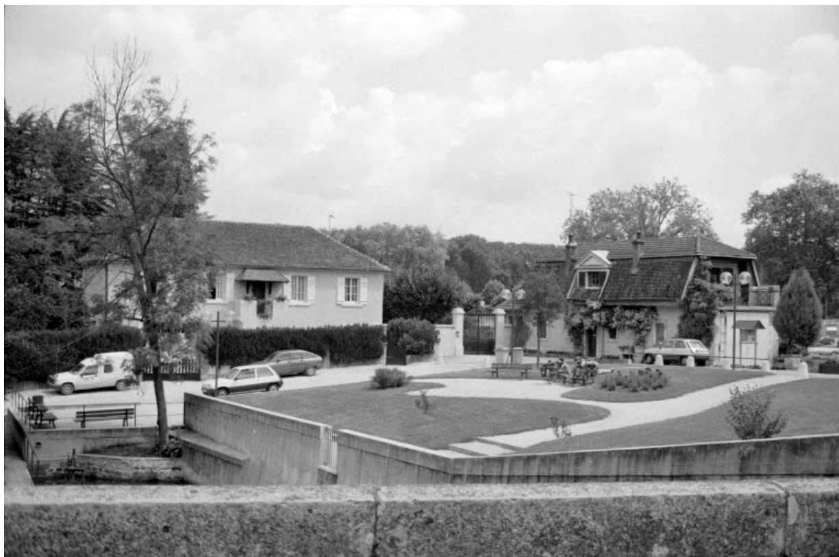
Logement d'ouvriers, vus depuis l'ouest.
