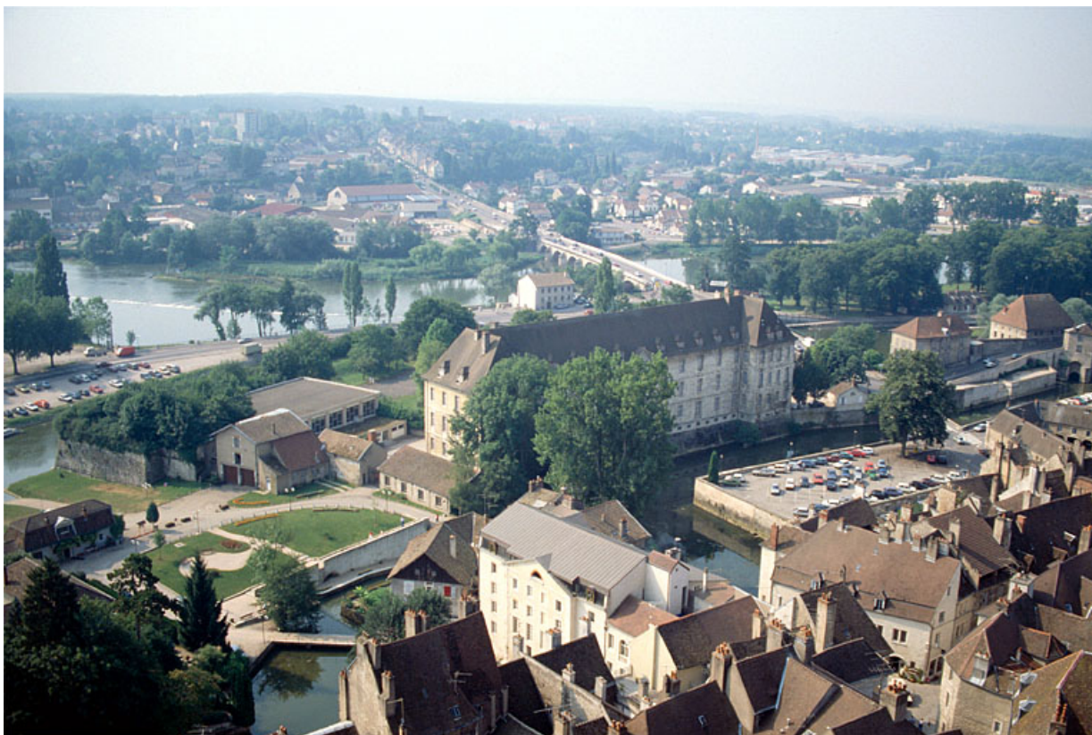
Vue d'ensemble, depuis le haut de la collégiale. 39, Dole rue du Prélot
