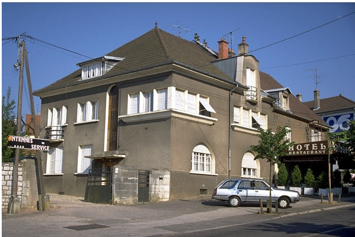
Logement patronal, vu depuis l'avenue. 39, Dole, 26 à 36 avenue du Maréchal Juin
