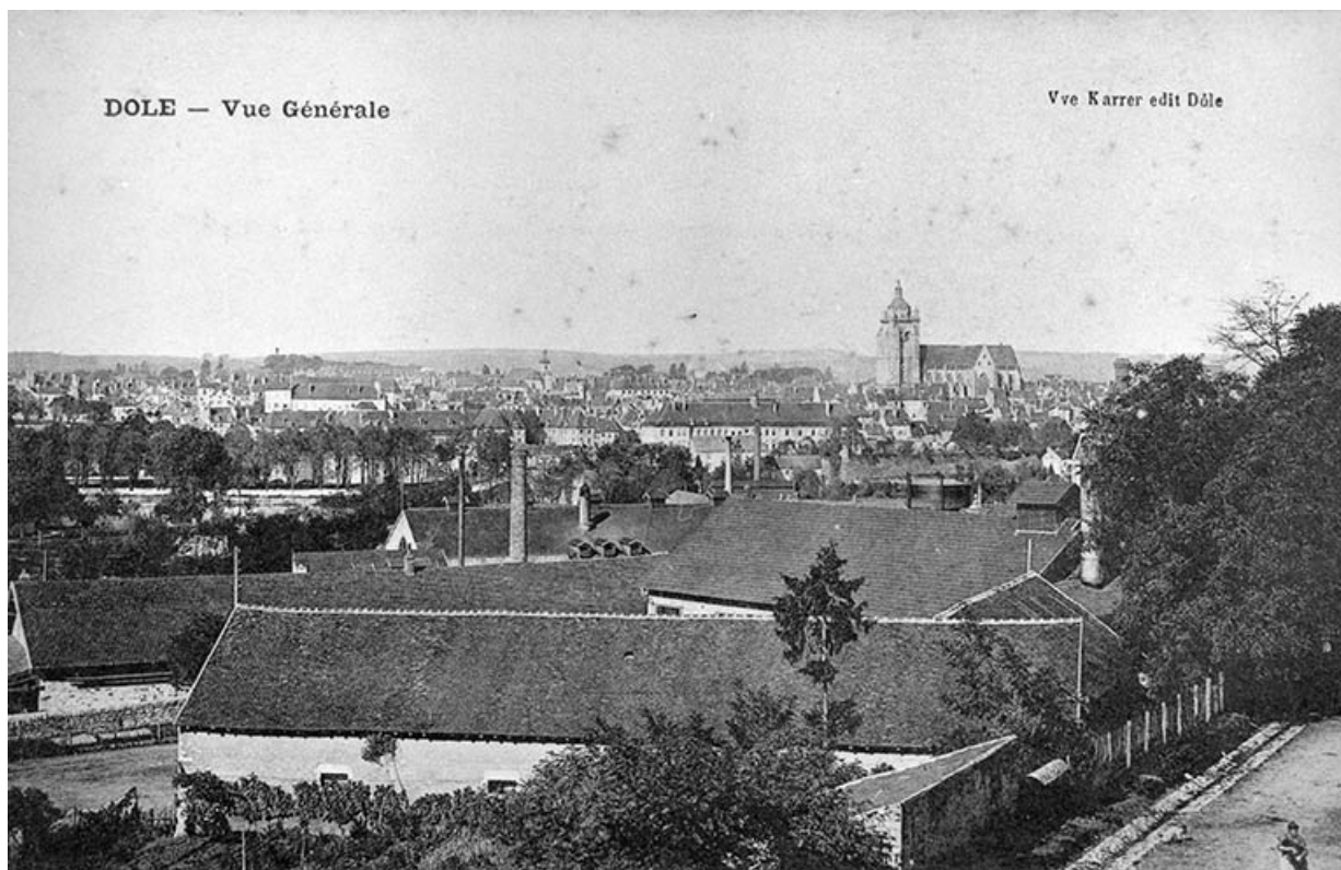
Dole - Vue Générale [l'usine vue de la rue Julien Feuvrier, à l'est]. 39, Dole, 26 à 36 avenue du Maréchal Juin
