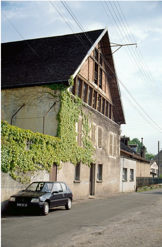
Façade antérieure de l'atelier de fabrication (J).
