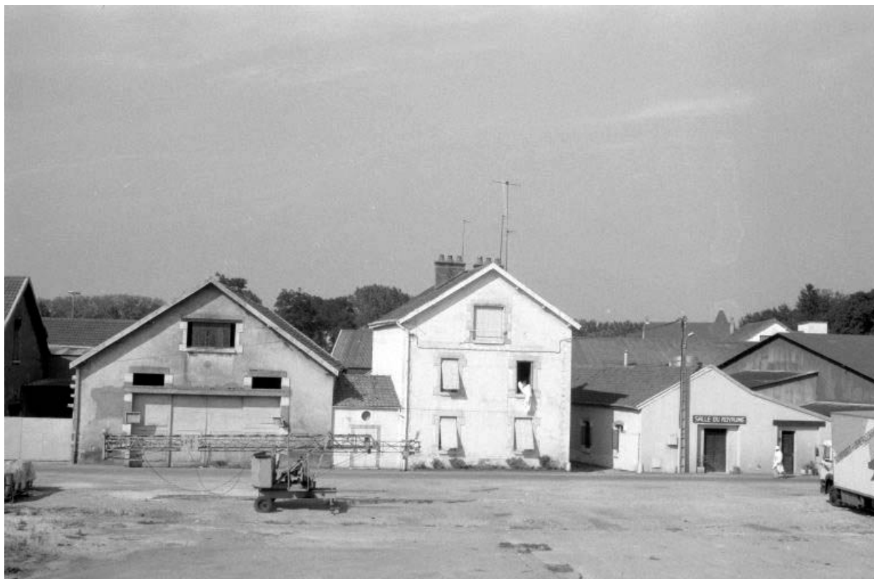
Façade antérieure des écuries et magasins industriels.
