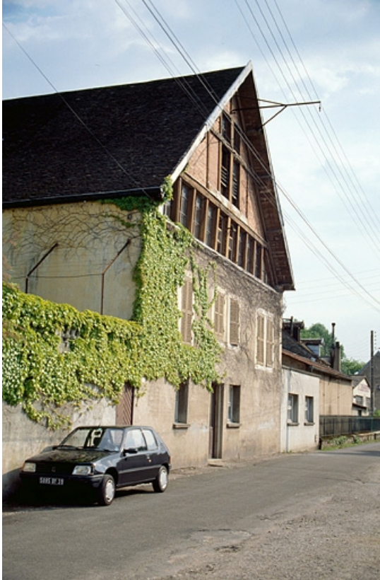
Façade antérieure de l'atelier de fabrication (J).
