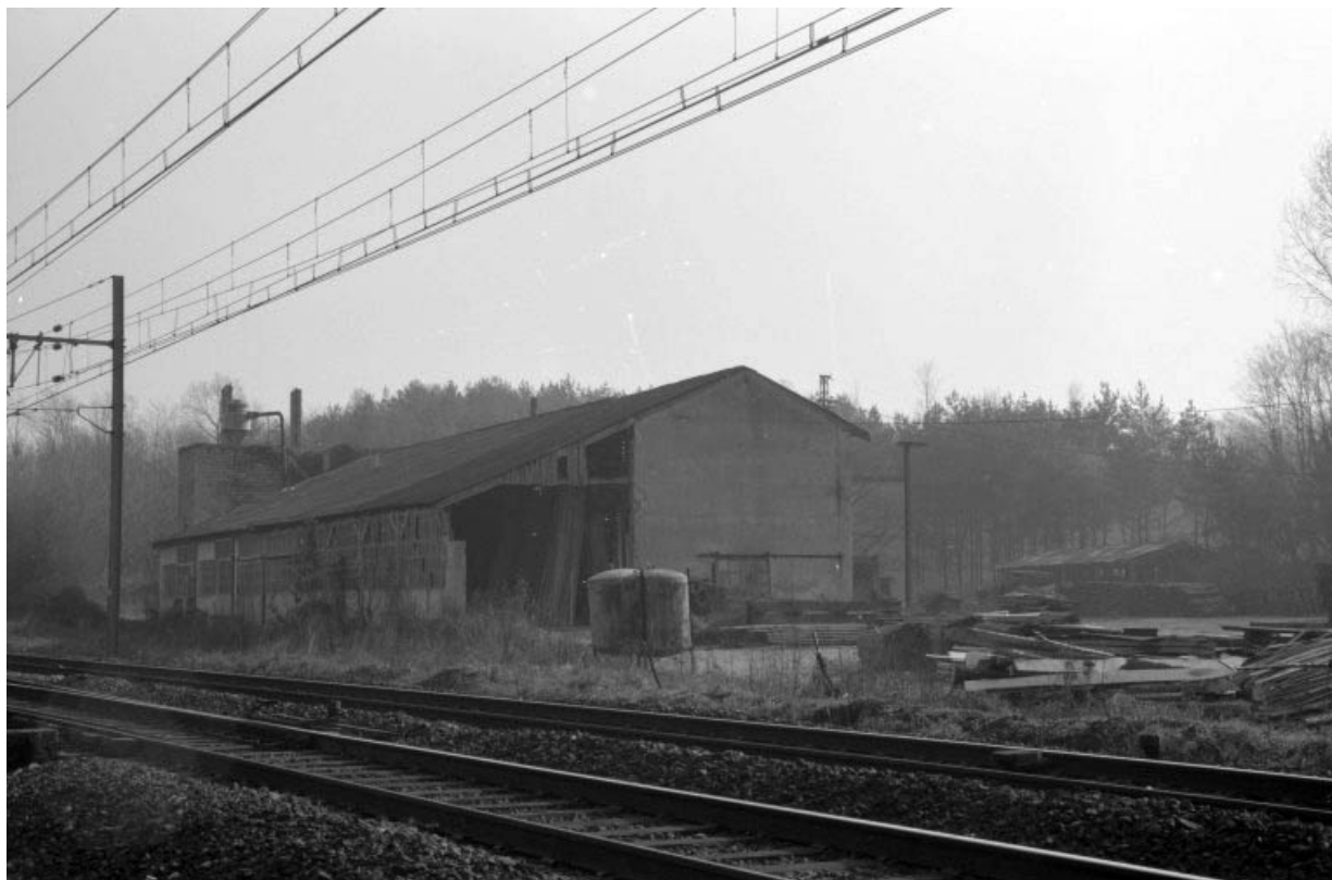
Menuiserie (M), depuis le nord-est. 39, Champvans, 36 avenue de la Gare
