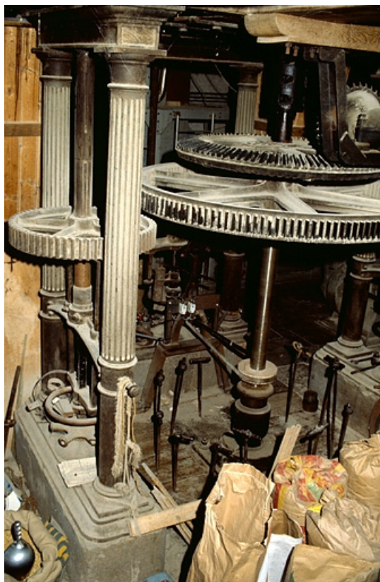
Beffroi : transmission et commandes d'admission d'eau de la turbine.
