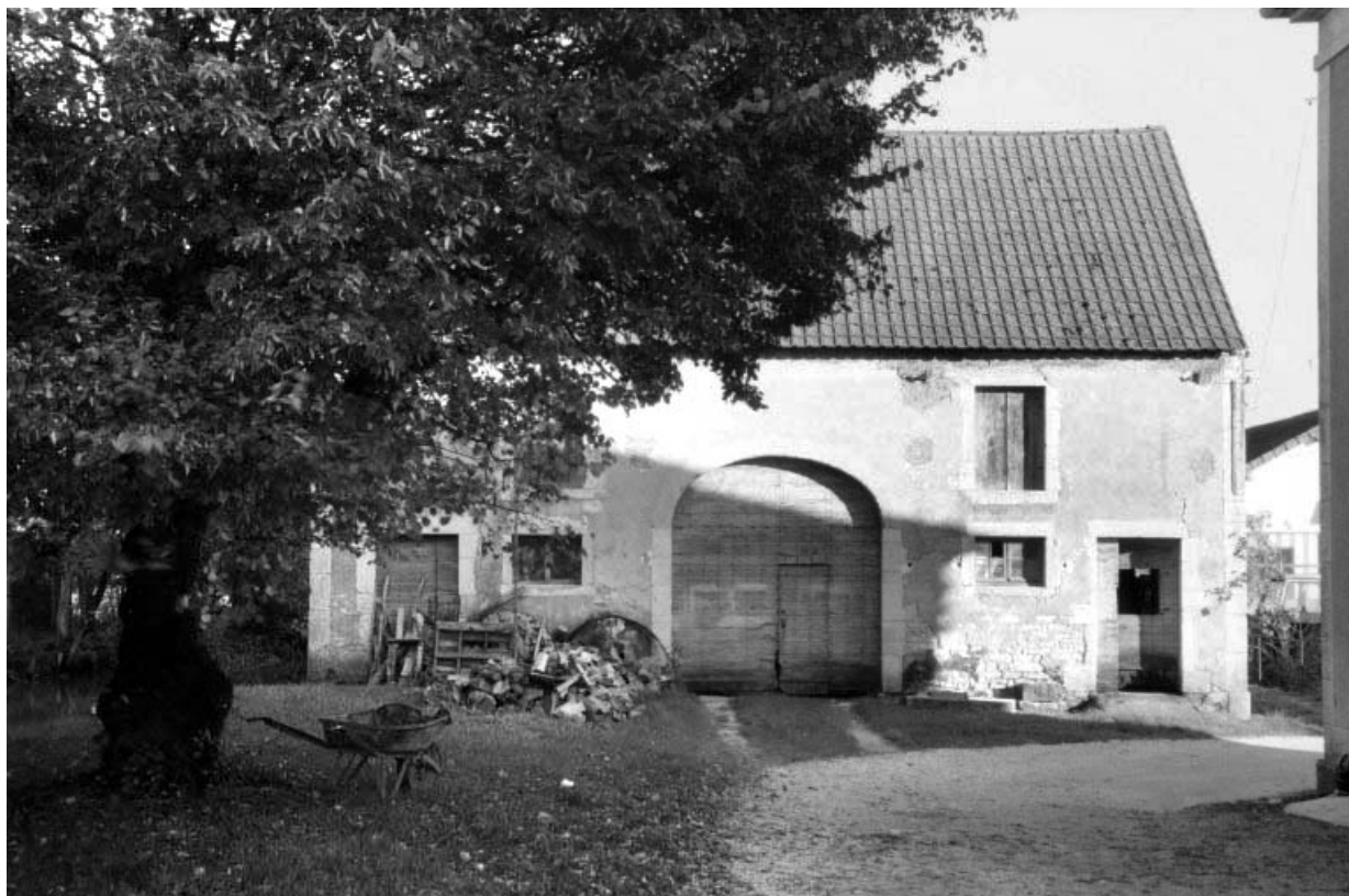
Façade antérieure de l'ancien battoir (D).
