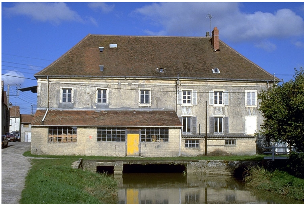
Façade postérieure de la minoterie.
