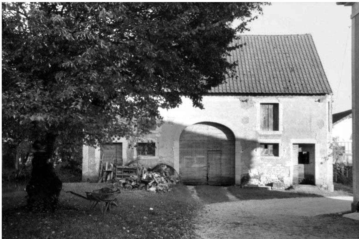
Façade antérieure de l'ancien battoir (D).
