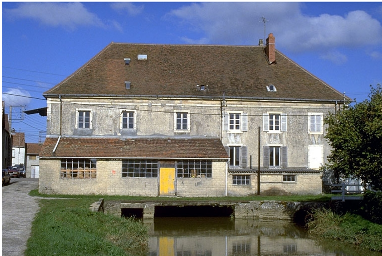
Façade postérieure de la minoterie.
