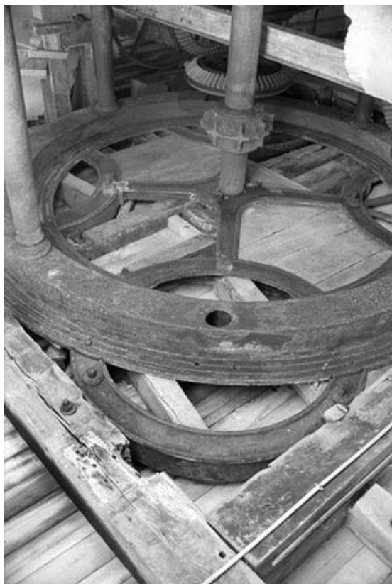
Minoterie, rez-de-chaussée : support des meules et transmission (beffroi).
