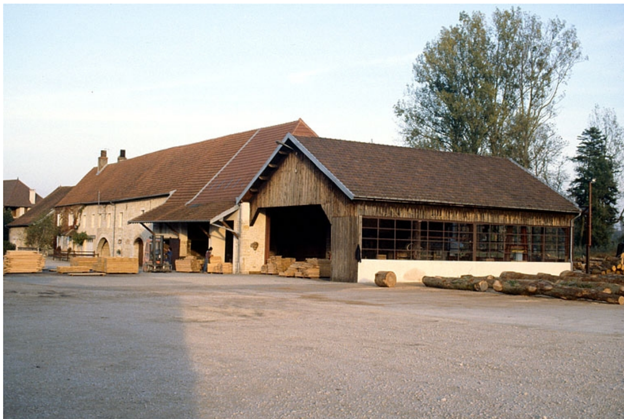
Vue d'ensemble des bâtiments anciens, depuis le sud-ouest.
