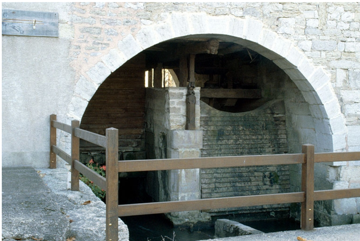
Chambre d'eau de la turbine, depuis l'aval.
