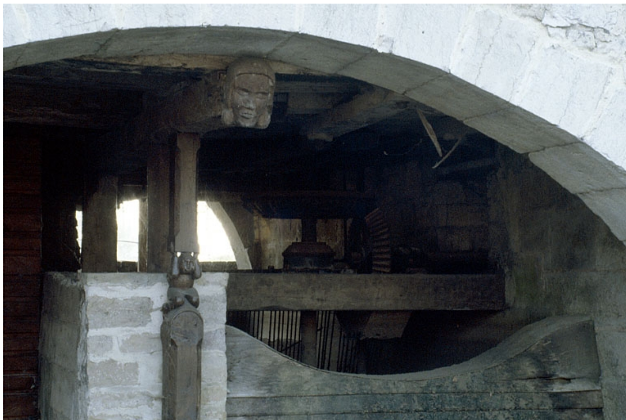
Pilier de soutènement sculpté et transmission de la turbine.
