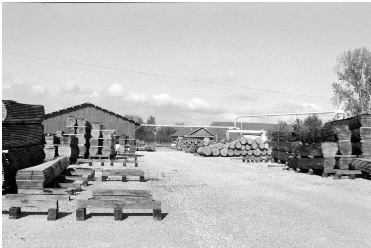
Vue d'ensemble de la scierie, depuis le sud-est.
