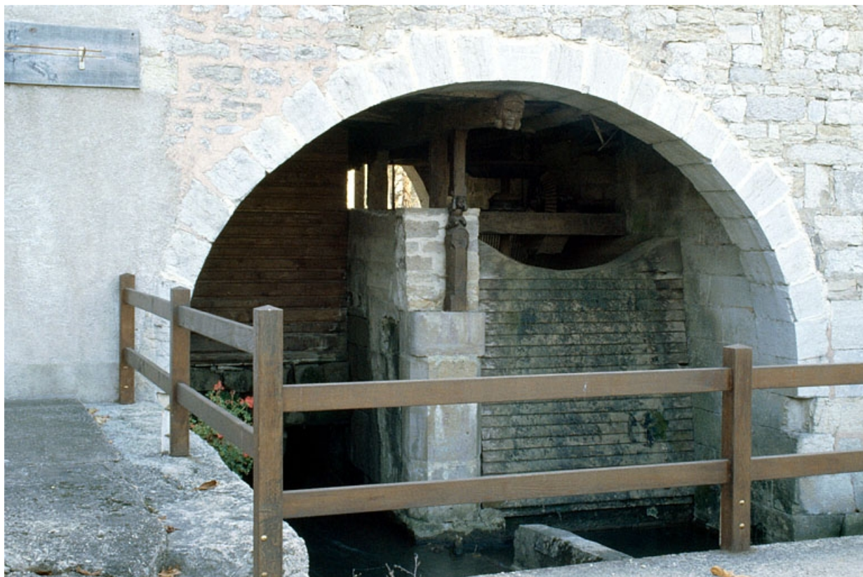
Chambre d'eau de la turbine, depuis l'aval.
