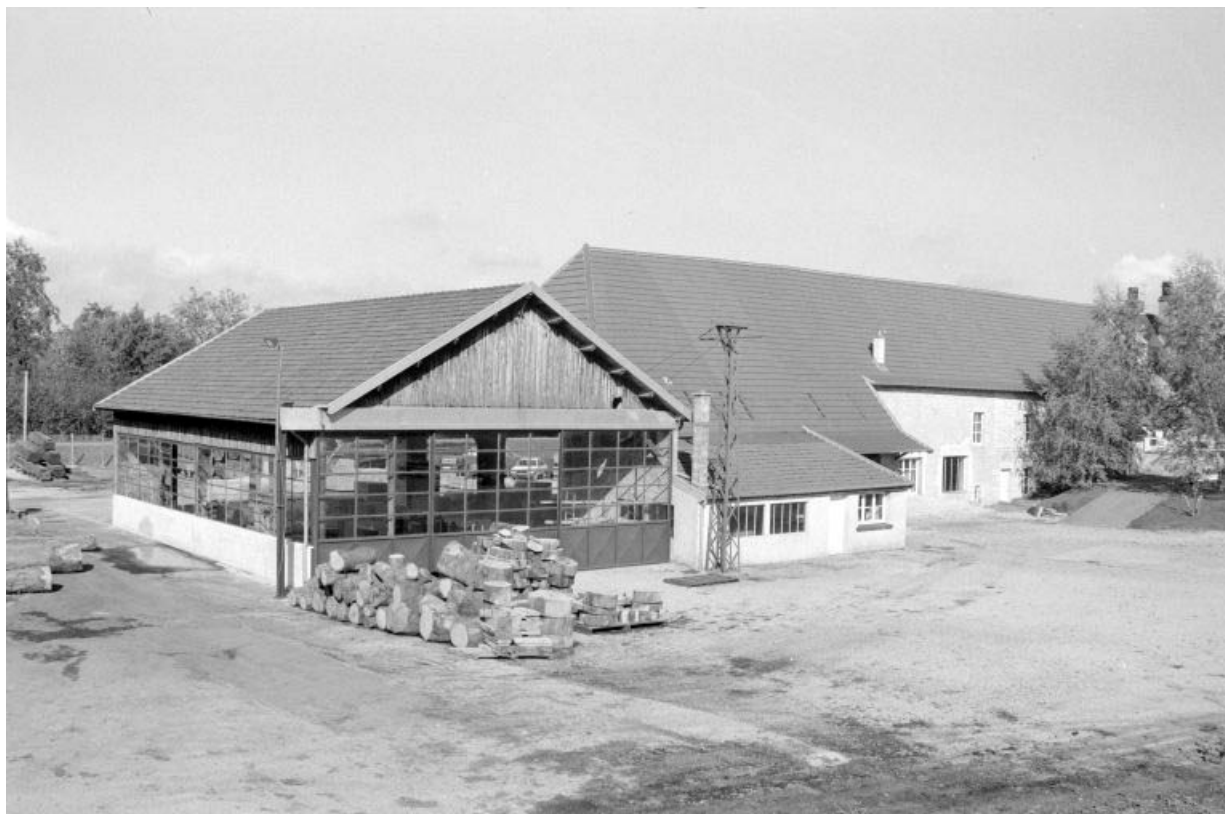
Ancienne scierie (G) et remise (F), depuis le sud-est.
