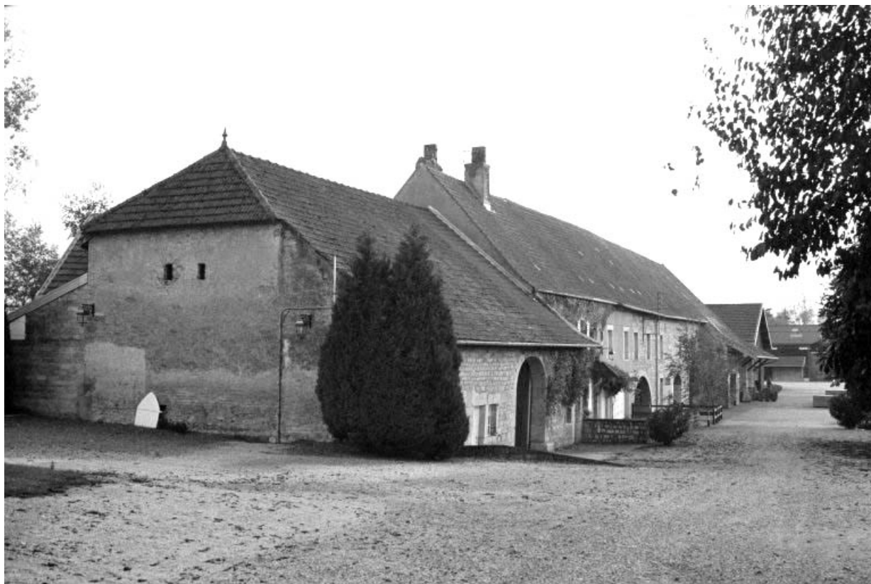
Vue d'ensemble des bâtiments anciens, depuis le nord.
