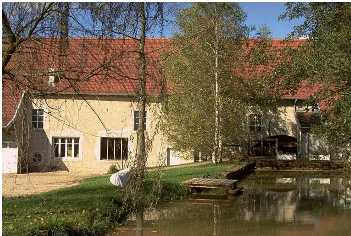
Minoterie et cantine : façade postérieure depuis le canal d'amenée.
