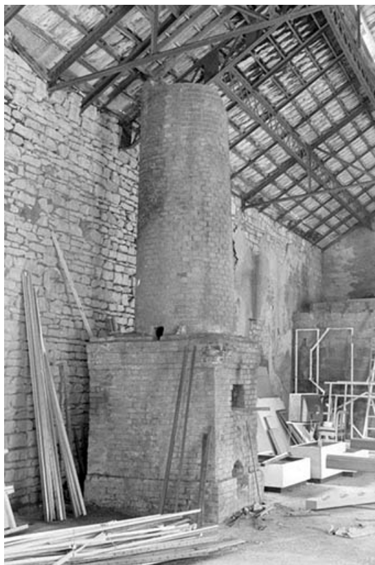
Atelier de réparation, intérieur : base de cheminée.
