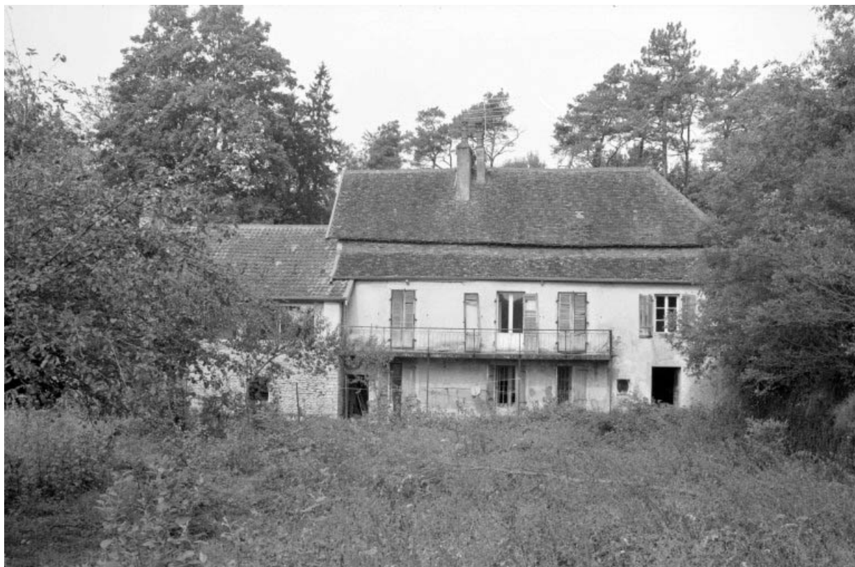
Façade latérale droite du logement patronal.
