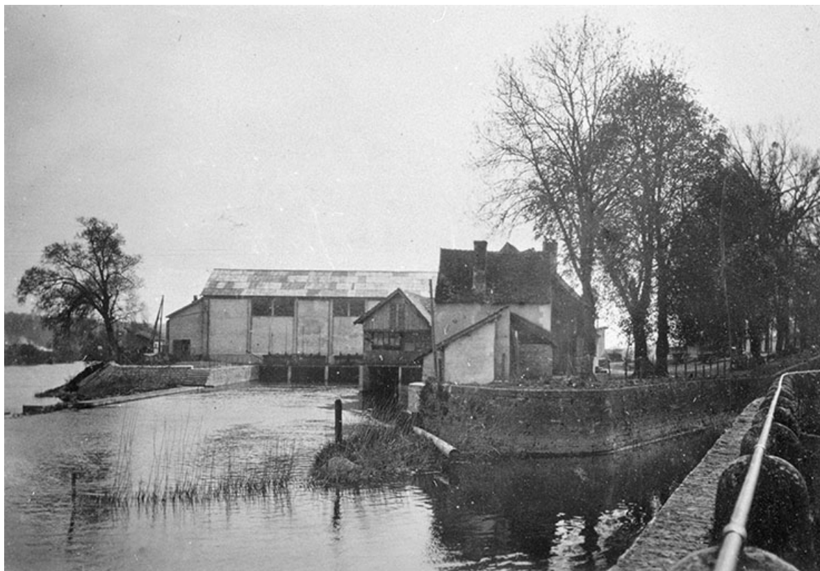
Station et moulin. Côté canal d'amenée.
