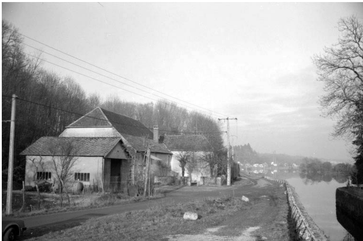
Remise (B), magasin industriel et logement patronal (A), depuis le sud.
