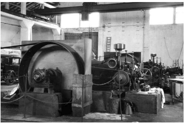
Centrale hydroélectrique, intérieur : transmission de la turbine.
