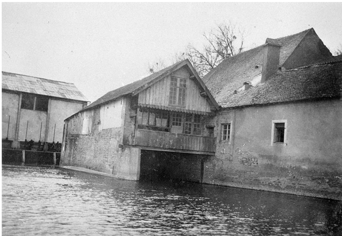
Moulin. Côté canal d'amenée.
