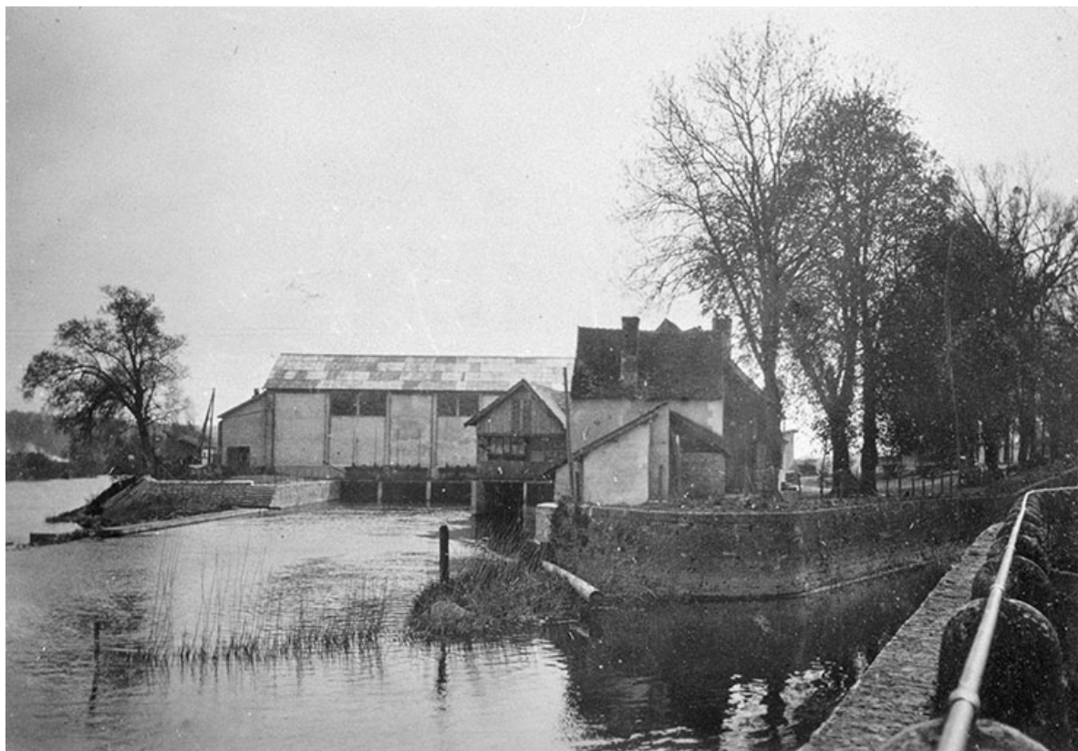
Station et moulin. Côté canal d'aménée.
