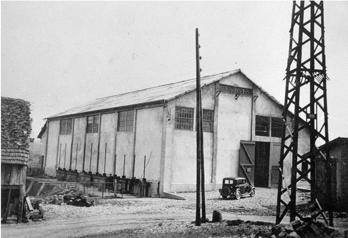
Station. Façade côté canal du Rhône au Rhin & côté canal d'aménée.
