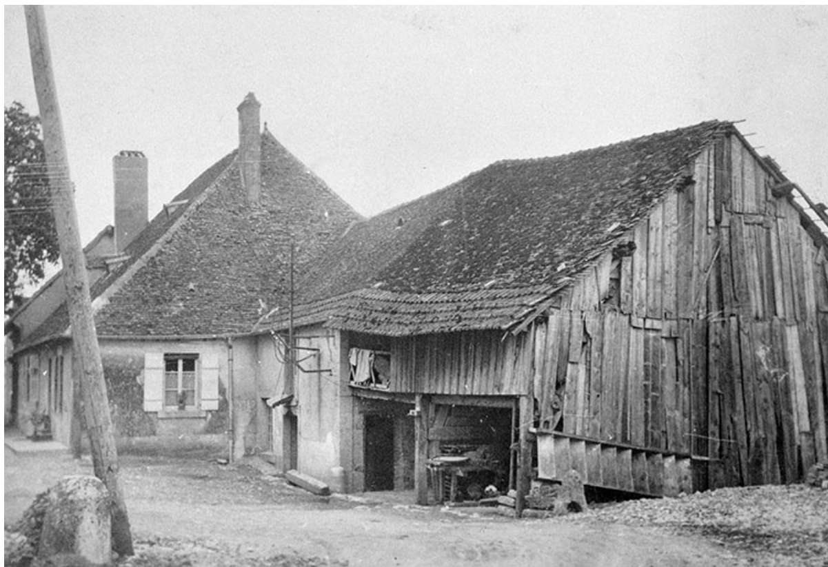
Moulin. Façade côté canal du Rhône au Rhin depuis l'ouest.
