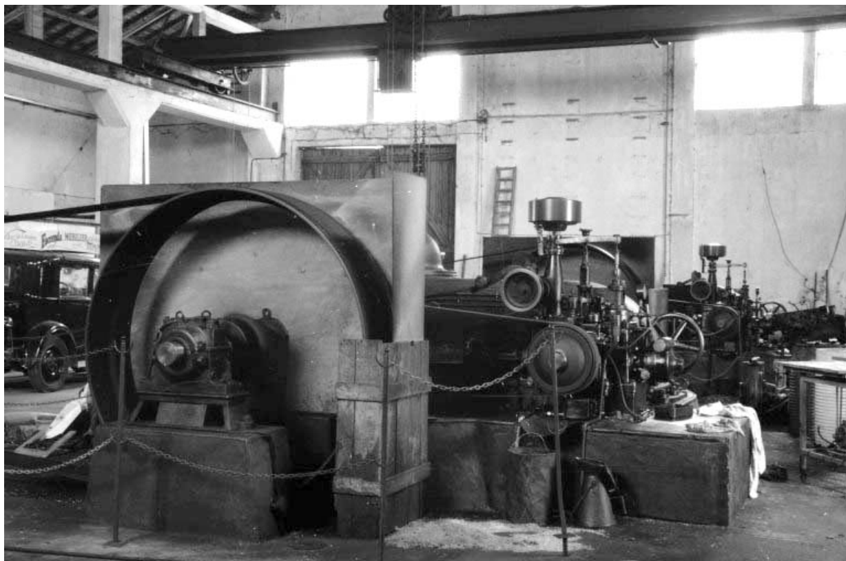
Centrale hydroélectrique, intérieur : transmission de la turbine.
