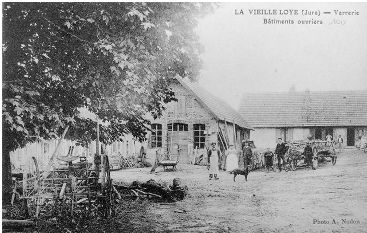
La Vieille-Loye (Jura) - Verrerie. Bâtiments ouvriers.
