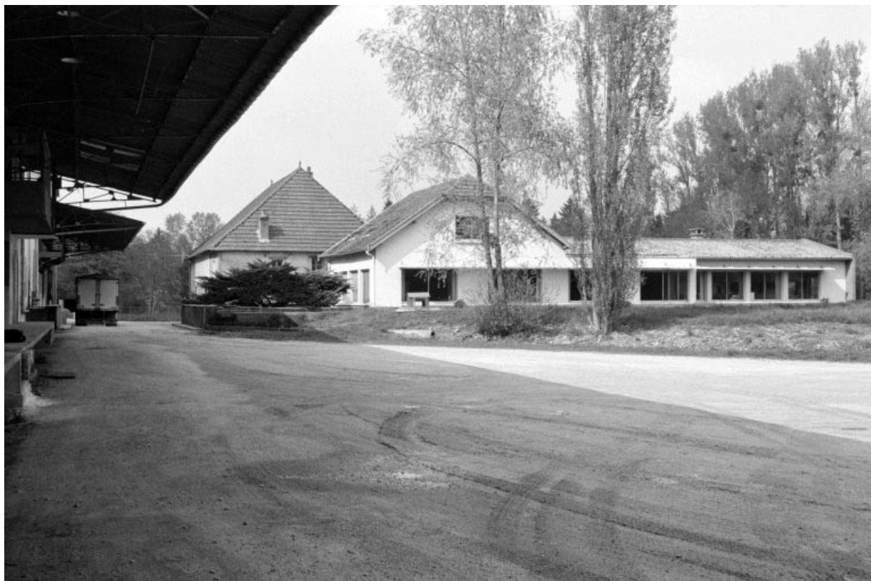
Façade postérieure du bureau.
