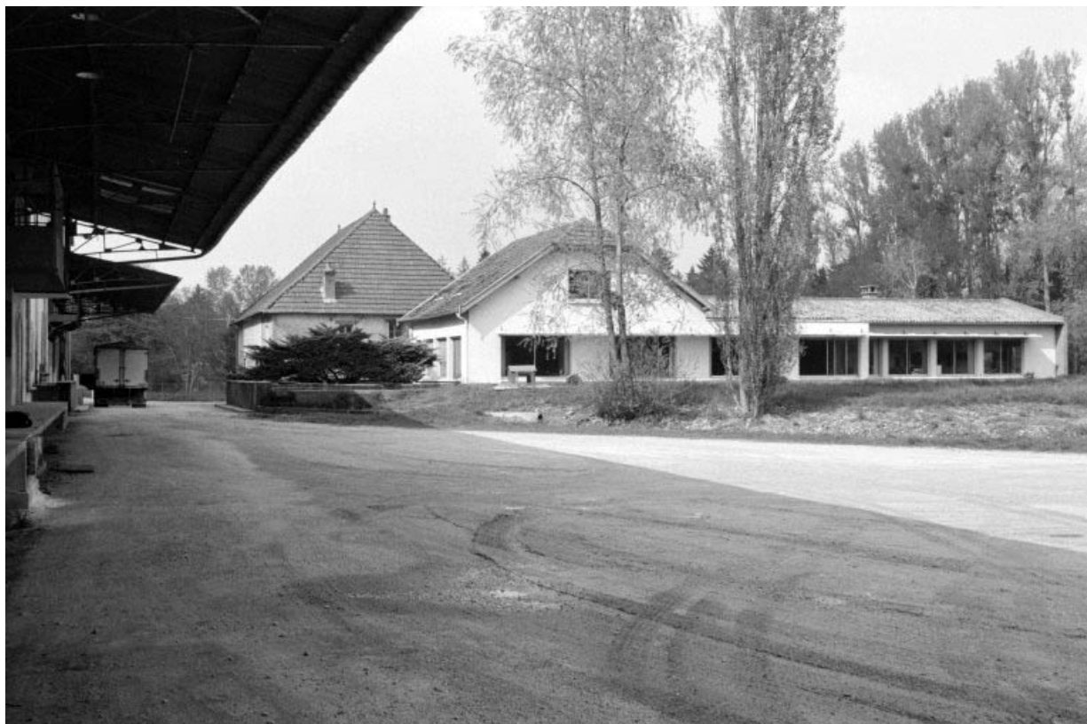
Façade postérieure du bureau.
