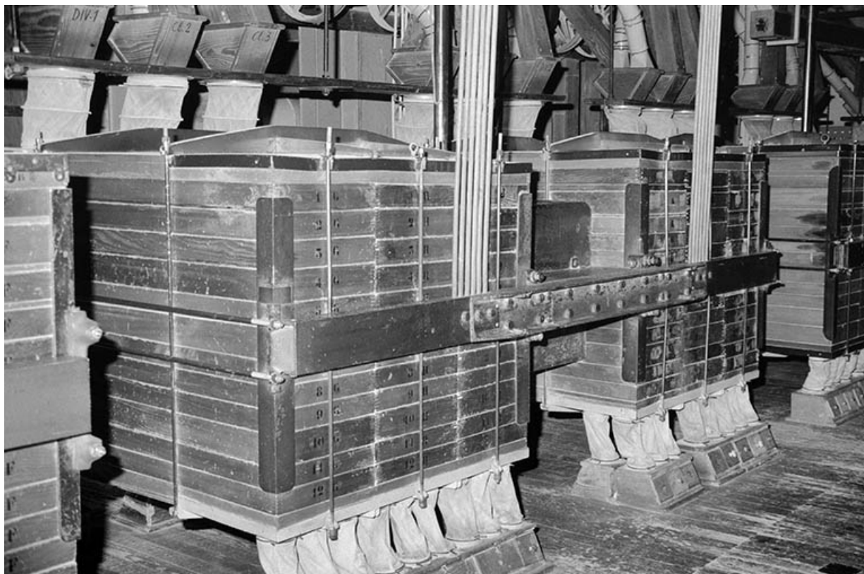
Atelier de fabrication (L), 3e étage : plansichter vu de trois quarts. 39, Parcey rue du Moulin
