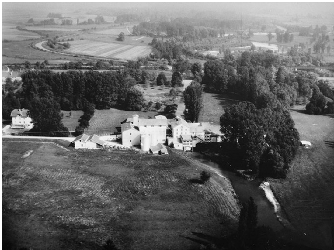
Vue d'ensemble depuis l'ouest (vue aérienne).
