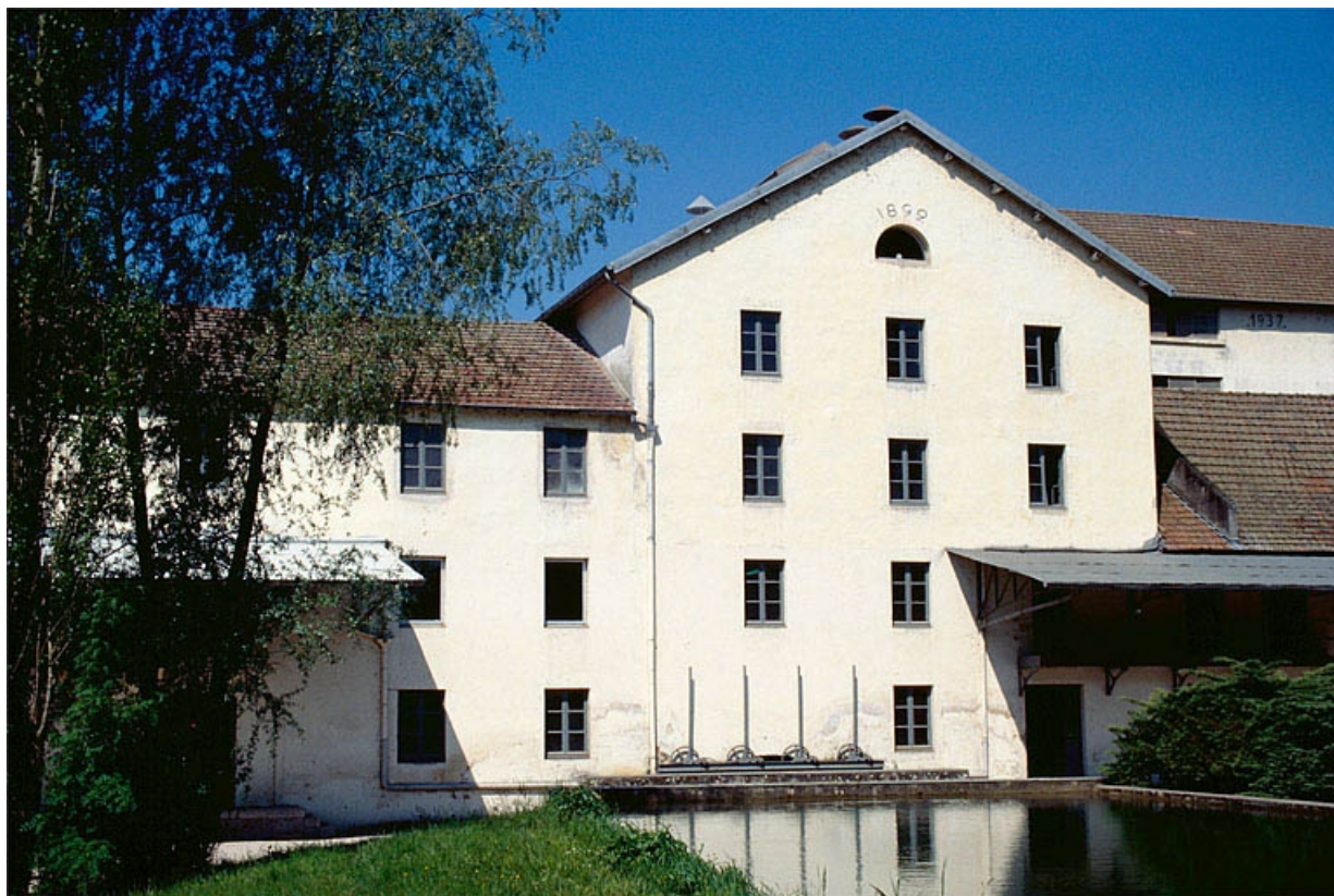
Façade antérieure de l'atelier de fabrication (L).
