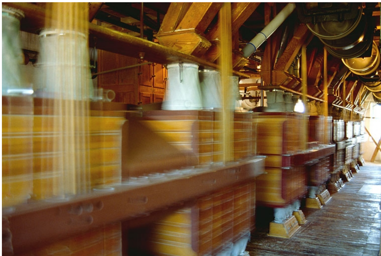
Atelier de fabrication (L), 3e étage : vue d'ensemble des plansichters en fonctionnement. 39, Parcey rue du Moulin
