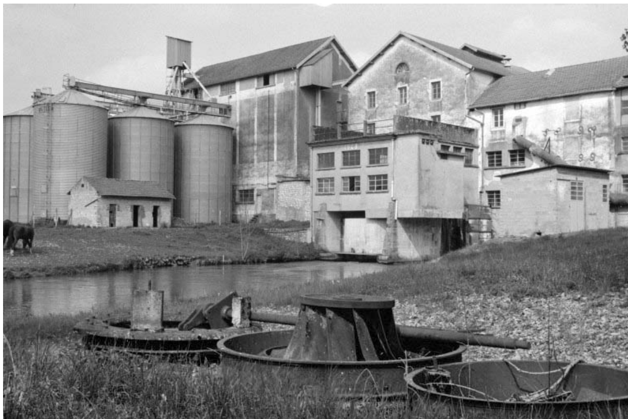
Bâtiment d'eau (J), ateliers de fabrication (L, M) et silos (C, D) vus du sud-ouest. Eléments d'une turbine Singrun au premier plan. 39, Parcey rue du Moulin
