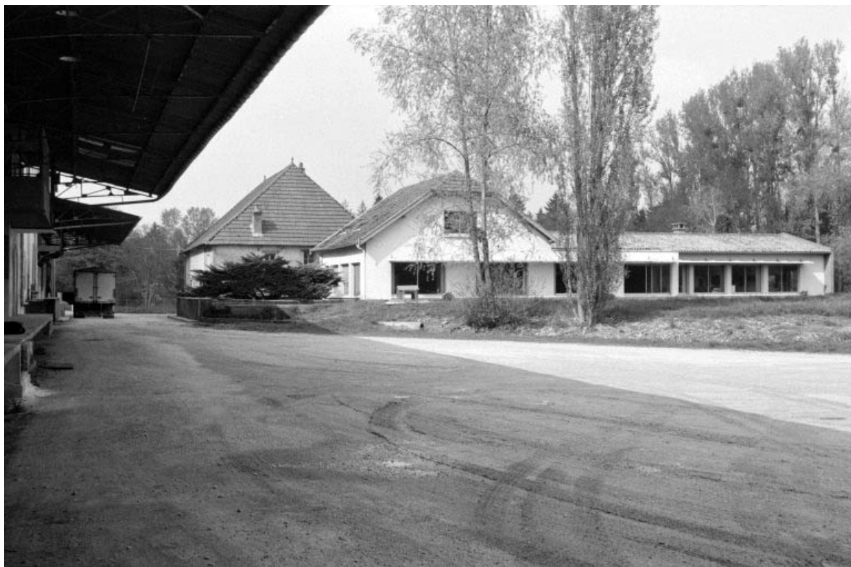
Façade postérieure du bureau.
