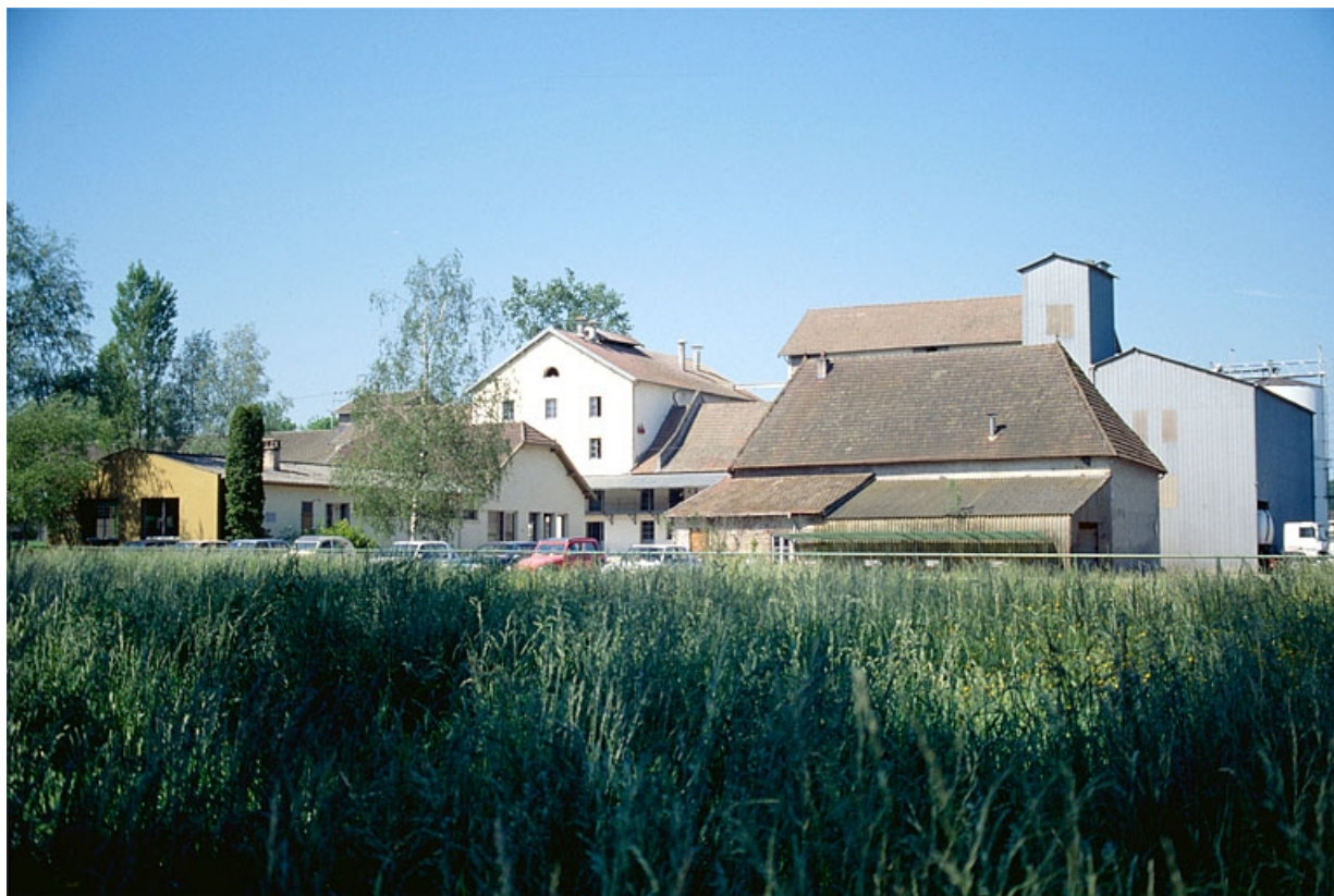
Bureau, atelier de fabrication, atelier de réparation et silos vus du nord-ouest. 39, Parcey rue du Moulin
