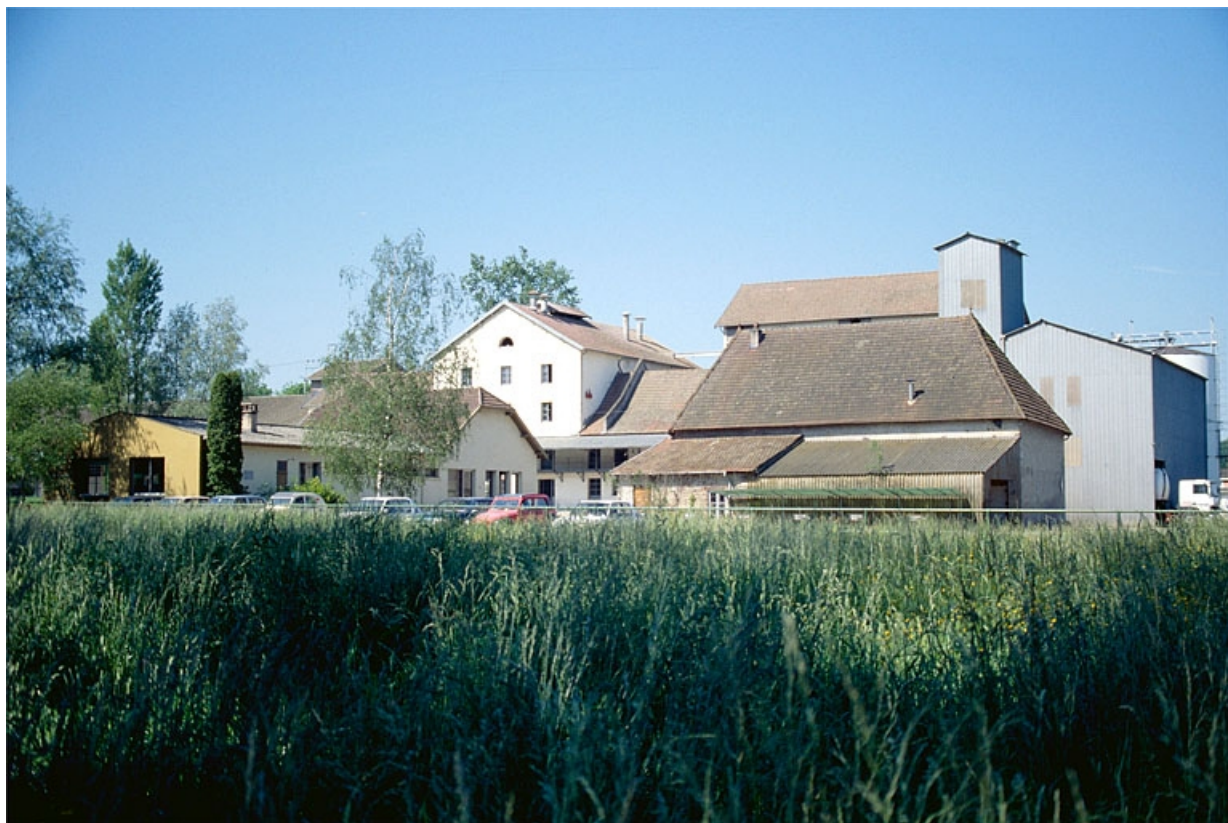
Bureau, atelier de fabrication, atelier de réparation et silos vus du nord-ouest. 39, Parcey rue du Moulin
