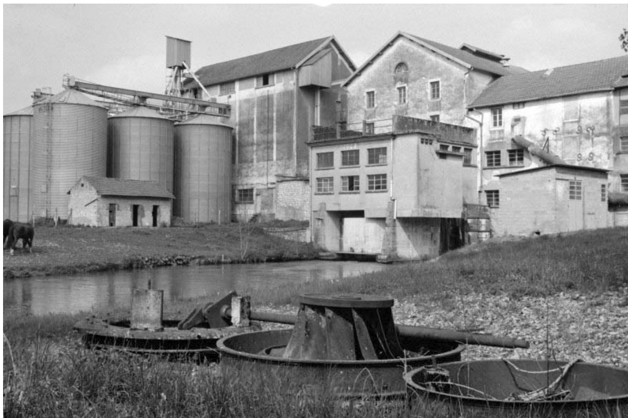
Bâtiment d'eau (J), ateliers de fabrication (L, M) et silos (C, D) vus du sud-ouest. Eléments d'une turbine Singrun au premier plan. 39, Parcey rue du Moulin
