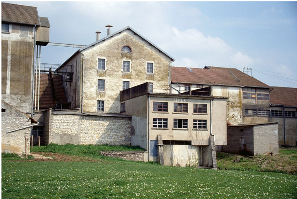
Façade postérieure des ateliers de fabrication (L, M) et du bâtiment d'eau (J). 39, Parcey rue du Moulin
