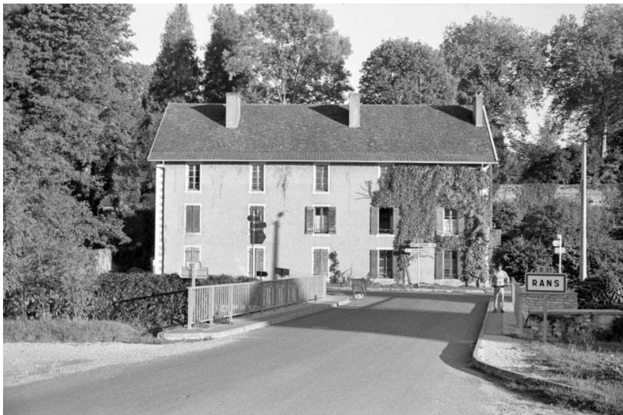
Façade antérieure du logement d'ouvriers (J). 39, Rans
