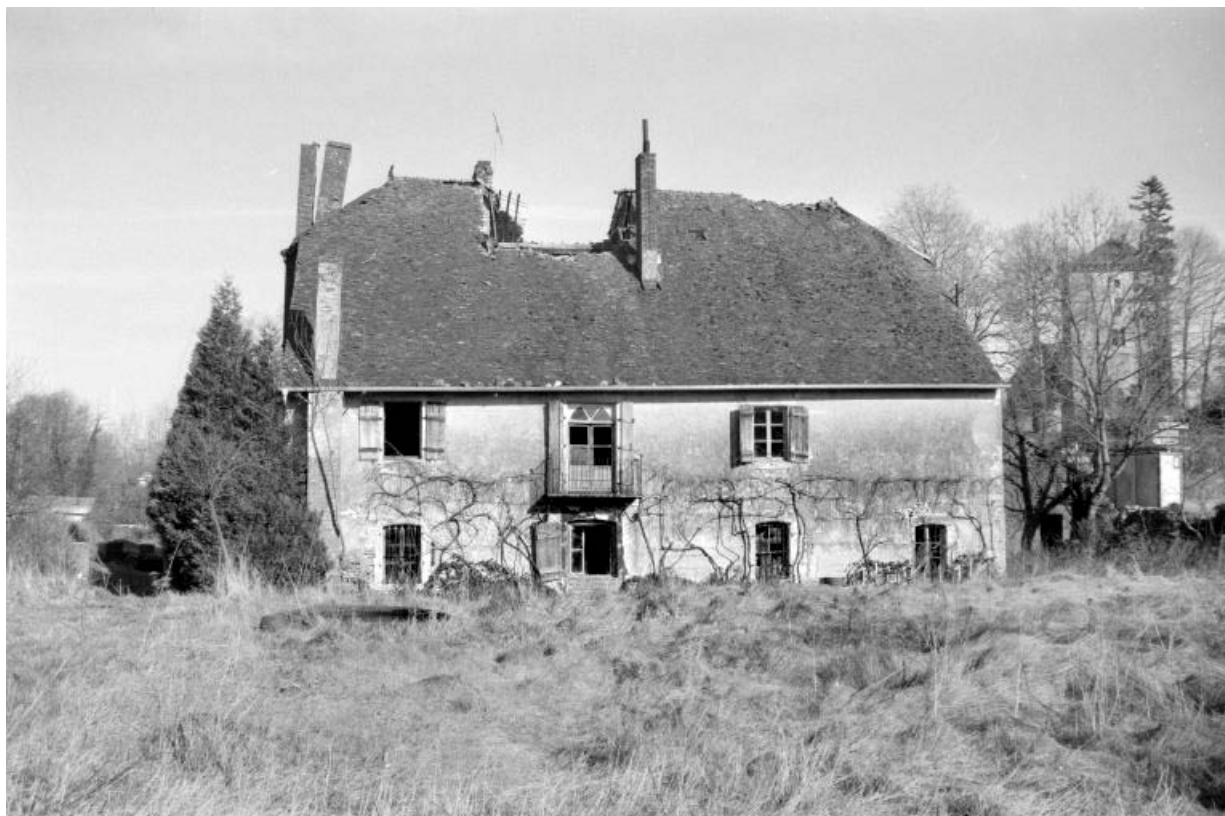
Façade postérieure du logement patronal.
