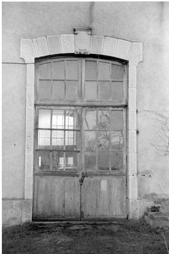
Porte d'entrée de la centrale hydroélectrique.
