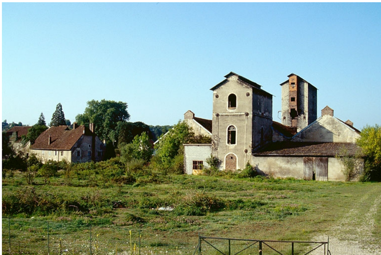
Vue d'ensemble depuis le nord : logement patronal (I) et atelier de fabrication. 39, Rans
