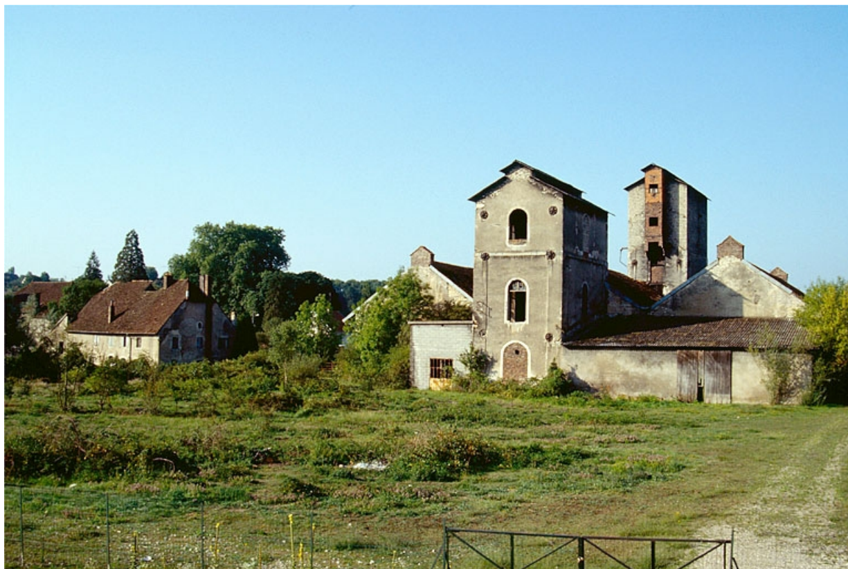
Vue d'ensemble depuis le nord : logement patronal (I) et atelier de fabrication. 39, Rans
