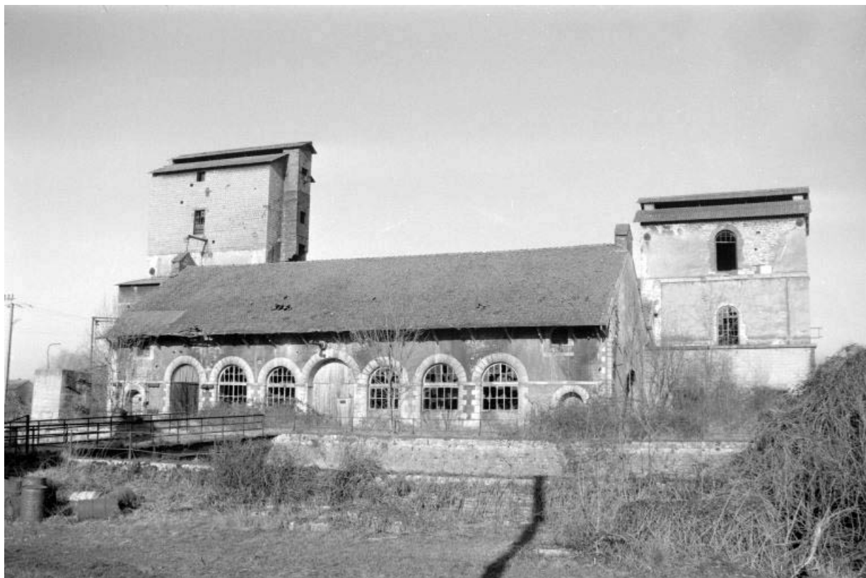
Atelier de fabrication (halle e3) et monte-charge, vus du sud-est. 39, Rans
