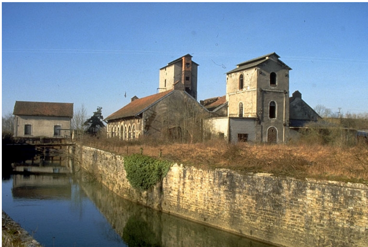
Vue d'ensemble depuis l'est : centrale hydroélectrique (G) et atelier de fabrication (E). 39, Rans
