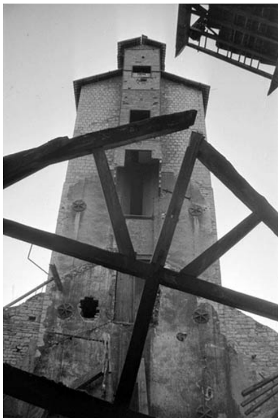
Monte-charge du haut-fourneau au coke (F), vu depuis la halle centrale. 39, Rans
