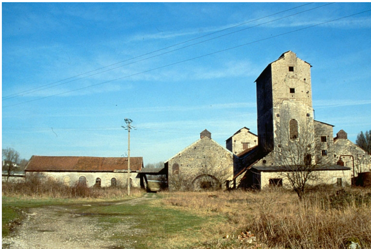
Vue d'ensemble depuis l'ouest : salle des machines (A) et atelier de fabrication. 39, Rans
