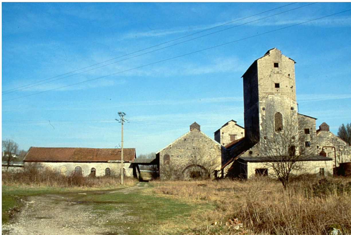
Vue d'ensemble depuis l'ouest : salle des machines (A) et atelier de fabrication. 39, Rans
