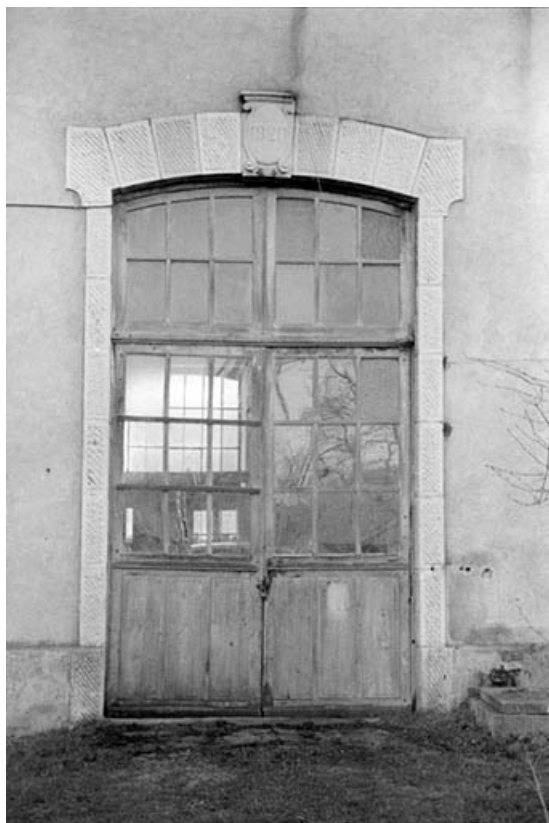
Porte d'entrée de la centrale hydroélectrique.
