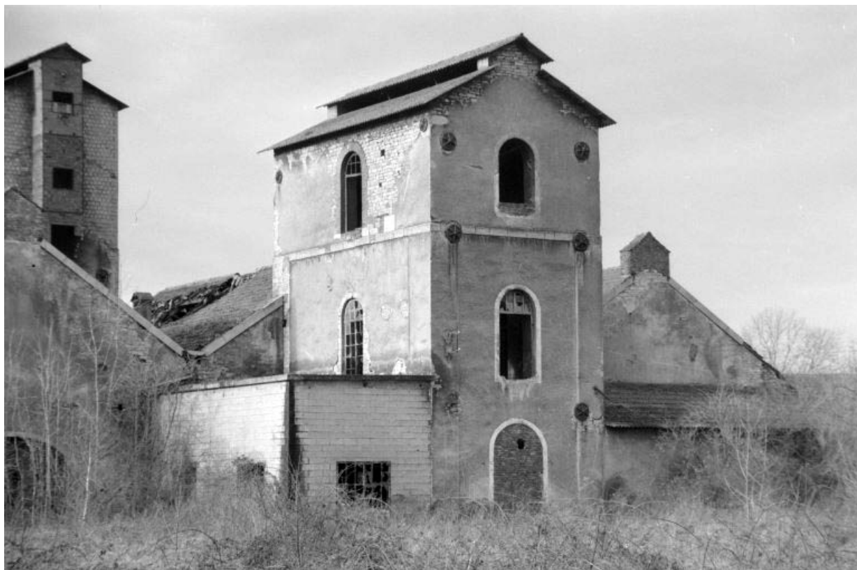
Monte-charge des hauts-fourneaux au bois (D), vu de l'est. 39, Rans
