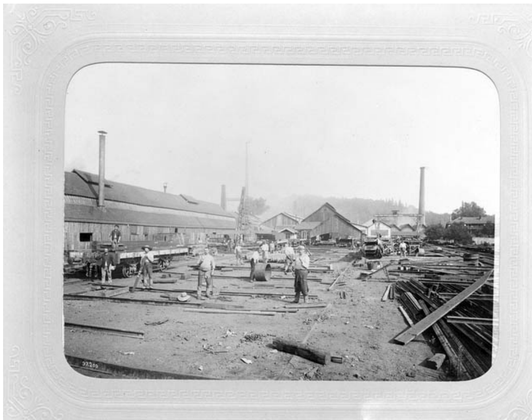
Ouvriers au travail entre l'atelier de construction (à gauche) et la cité ouvrière (à droite), à la fin du 19e siècle. 39, Fraisans rue de la Gare
