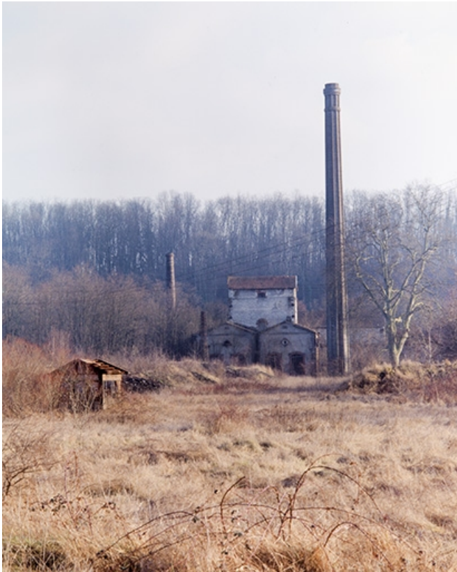
Forge Neuve. Centrale électrique, monte-charge du haut-fourneau et cheminée vus du nord-ouest. 39, Fraisans rue de la Gare
