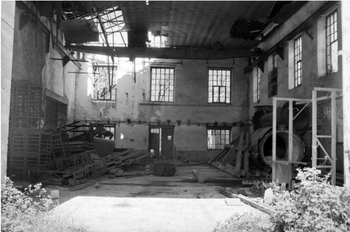
Forge Neuve. Centrale électrique : intérieur de la salle des machines H (ancien bâtiment du haut-fourneau). 39, Fraisans rue de la Gare
