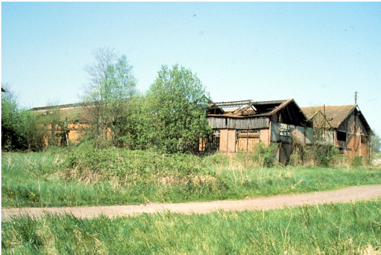
Forge Neuve. Atelier de construction (O) vu de trois quarts gauche.
