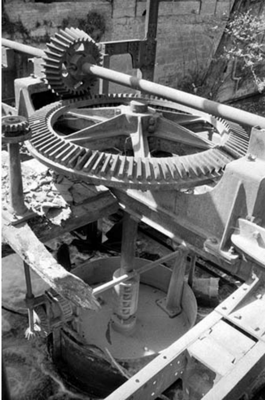
Vieille Forge. Bâtiment d'eau dit le Sénat : détail d'une turbine et de ses engrenages. 39, Fraisans rue de la Gare
