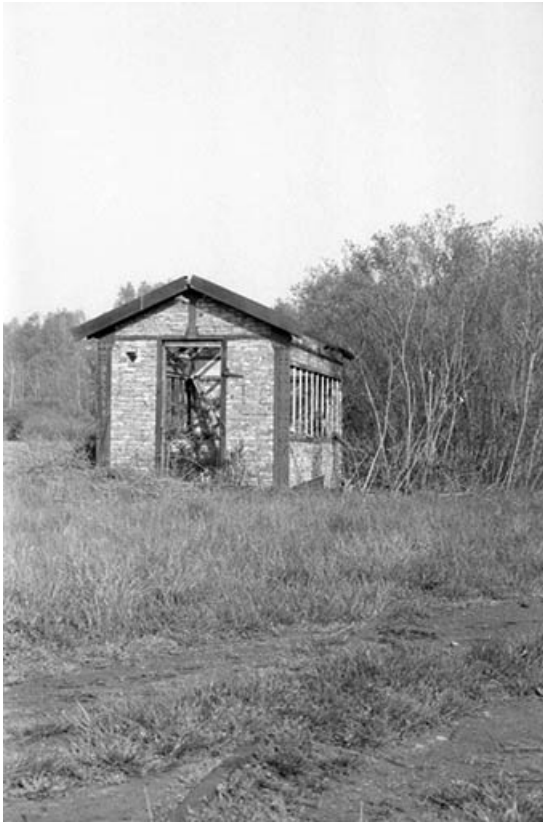
Forge Neuve. Bâtiment (Q) : pont-bascule ?
