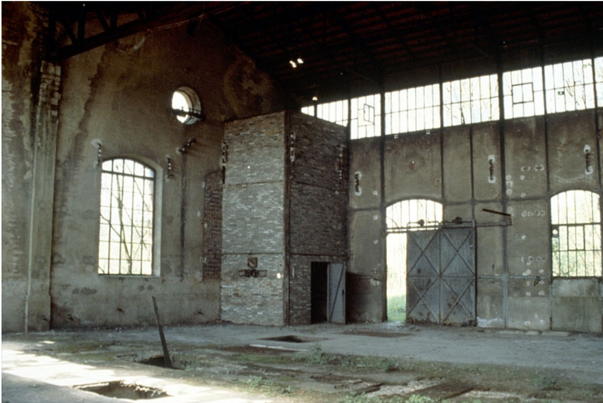
Forge Neuve. Centrale électrique : intérieur de la salle des machines (J). 39, Fraisans rue de la Gare
