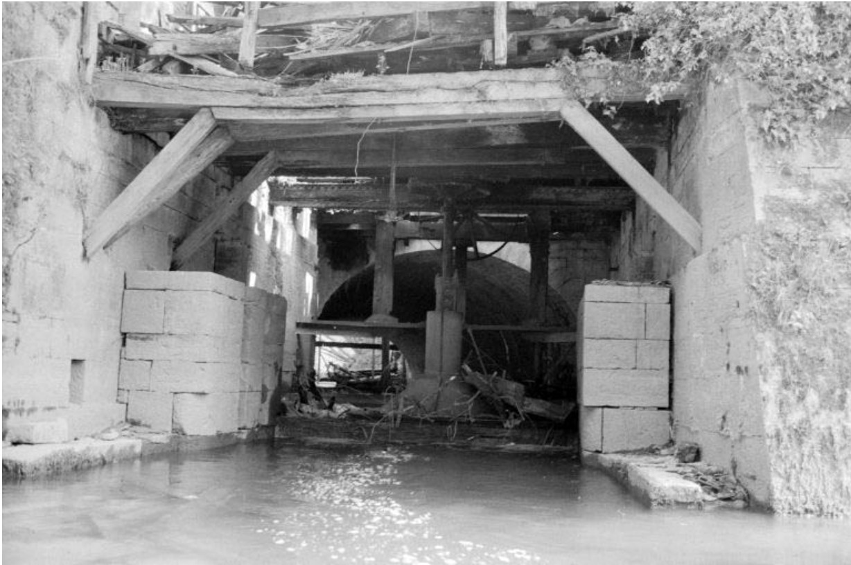
Forge Neuve. Bâtiment d'eau (L) : chambre d'eau et turbine vues du canal de fuite. 39, Fraisans rue de la Gare
