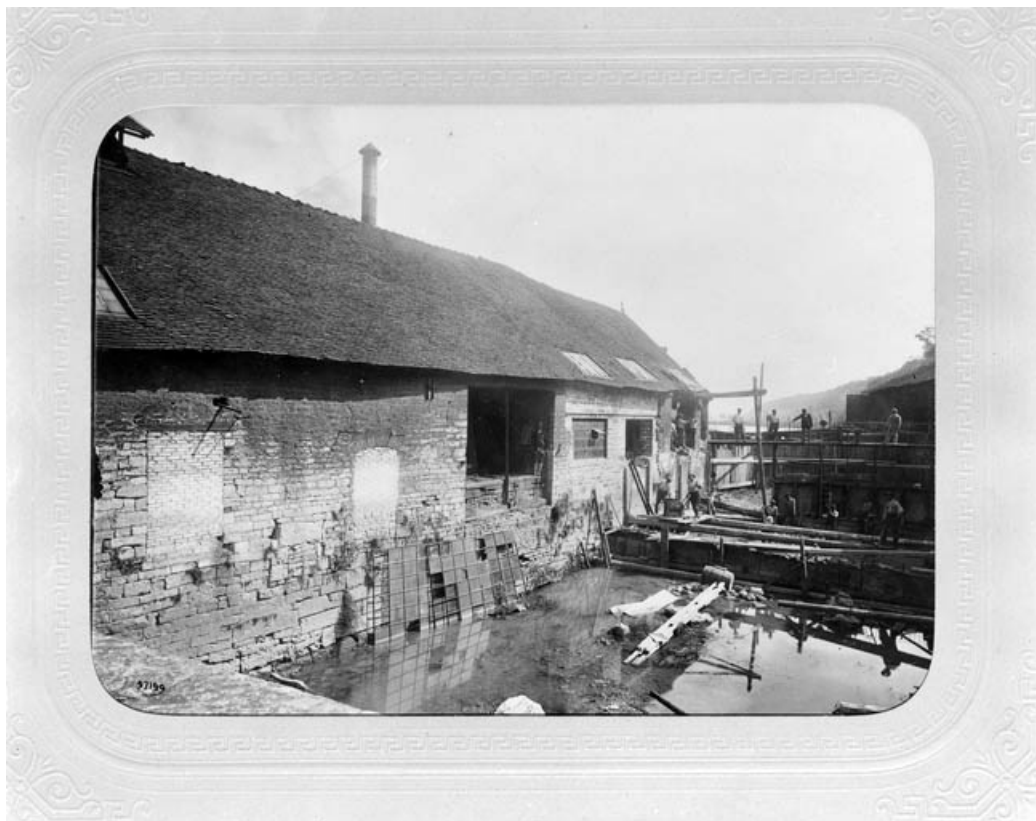
Vieille Forge à la fin du 19e siècle : construction du bâtiment des turbines en avant de la clouterie (à gauche). 39, Fraisans rue de la Gare
