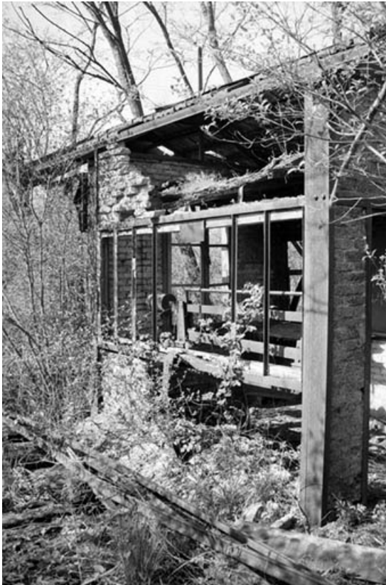
Forge Neuve. Bâtiment du pont-bascule (P).
