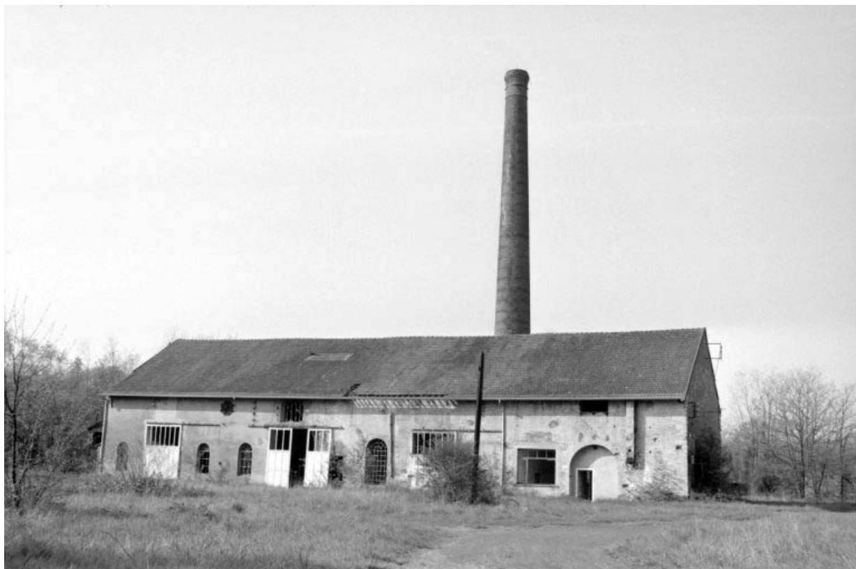
Forge Neuve. Façade antérieure de la chaînerie.
