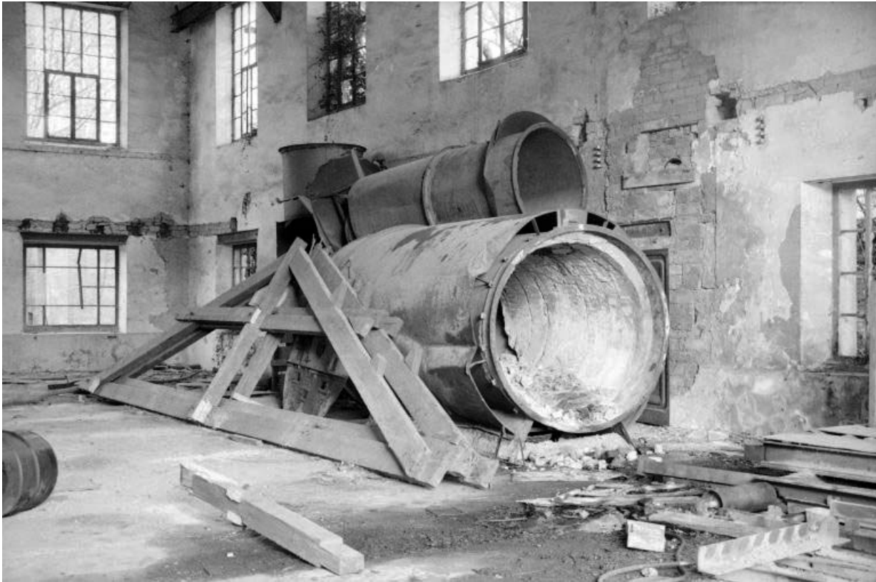
Forge Neuve. Centrale électrique : élément de fourneau (?) dans la salle des machines (H). 39, Fraisans rue de la Gare
