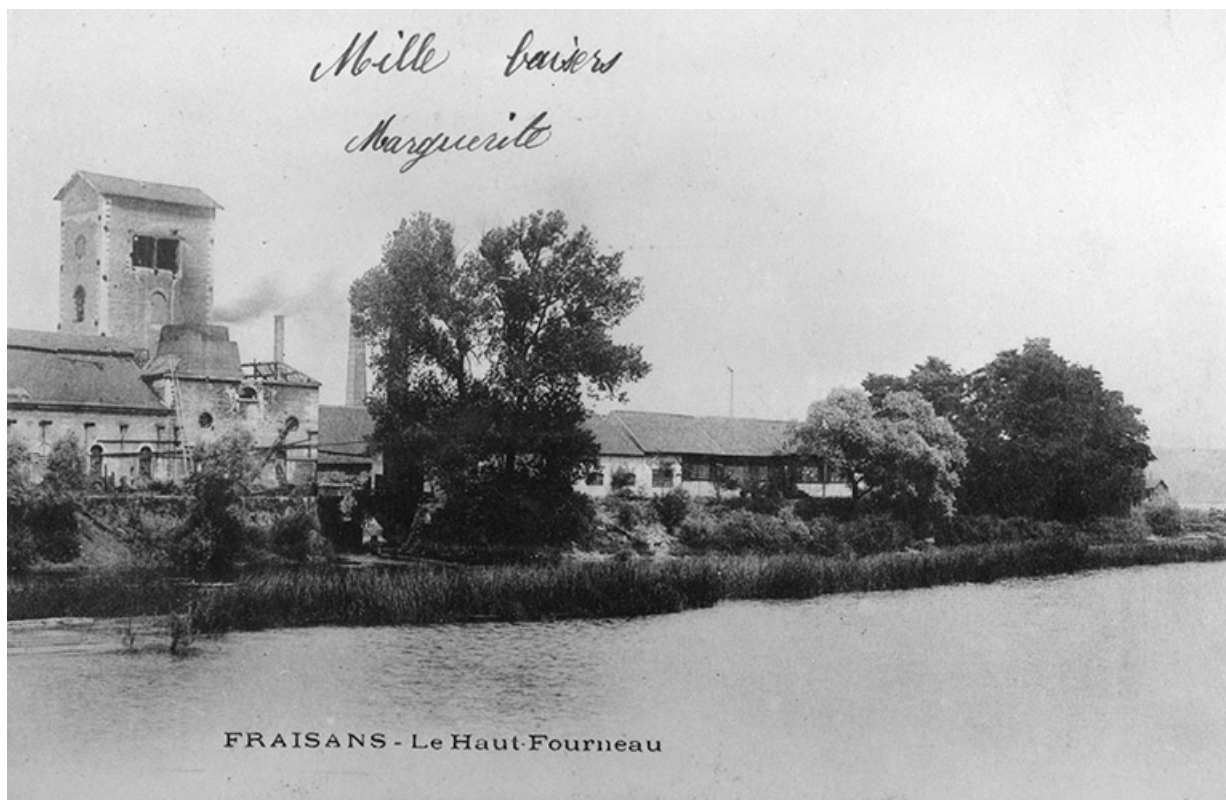
Fraisans. Le Haut-Fourneau vu du sud-est.
