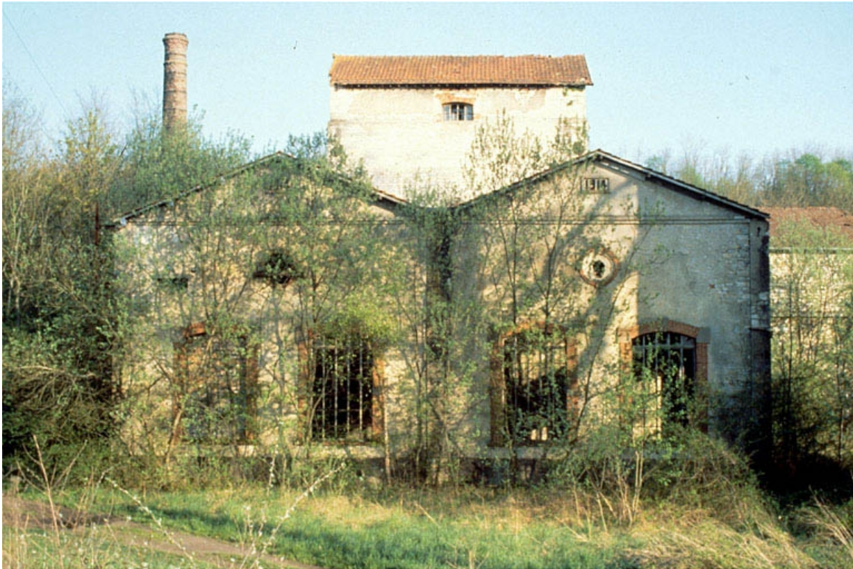
Forge Neuve. Centrale électrique : salle des machines (J).
