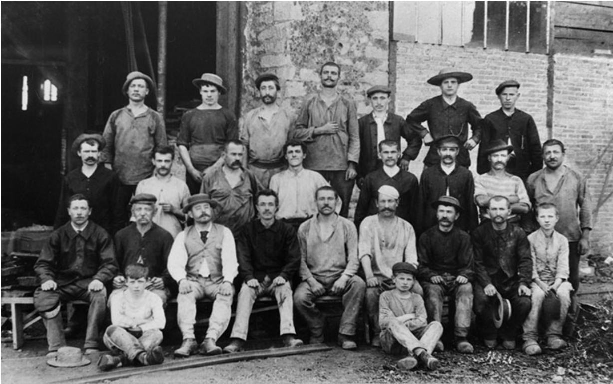
Une équipe de l'atelier de construction.
