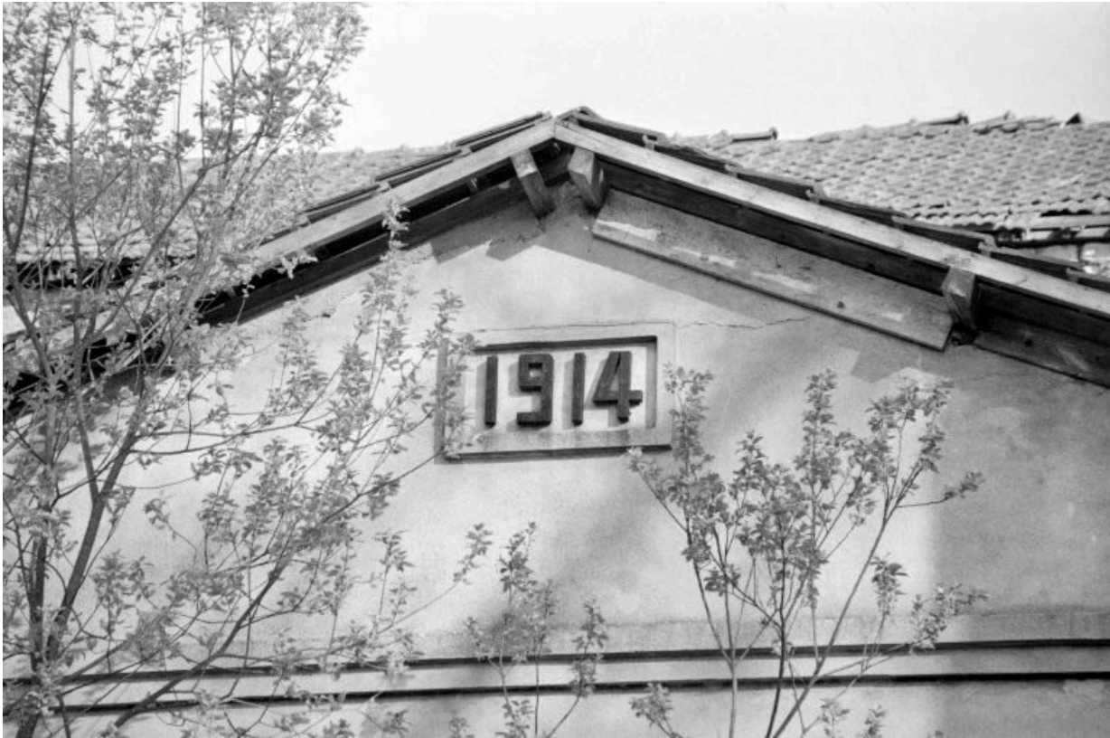
Forge Neuve. Centrale électrique : détail du mur pignon de la salle des machines (J). 39, Fraisans rue de la Gare
