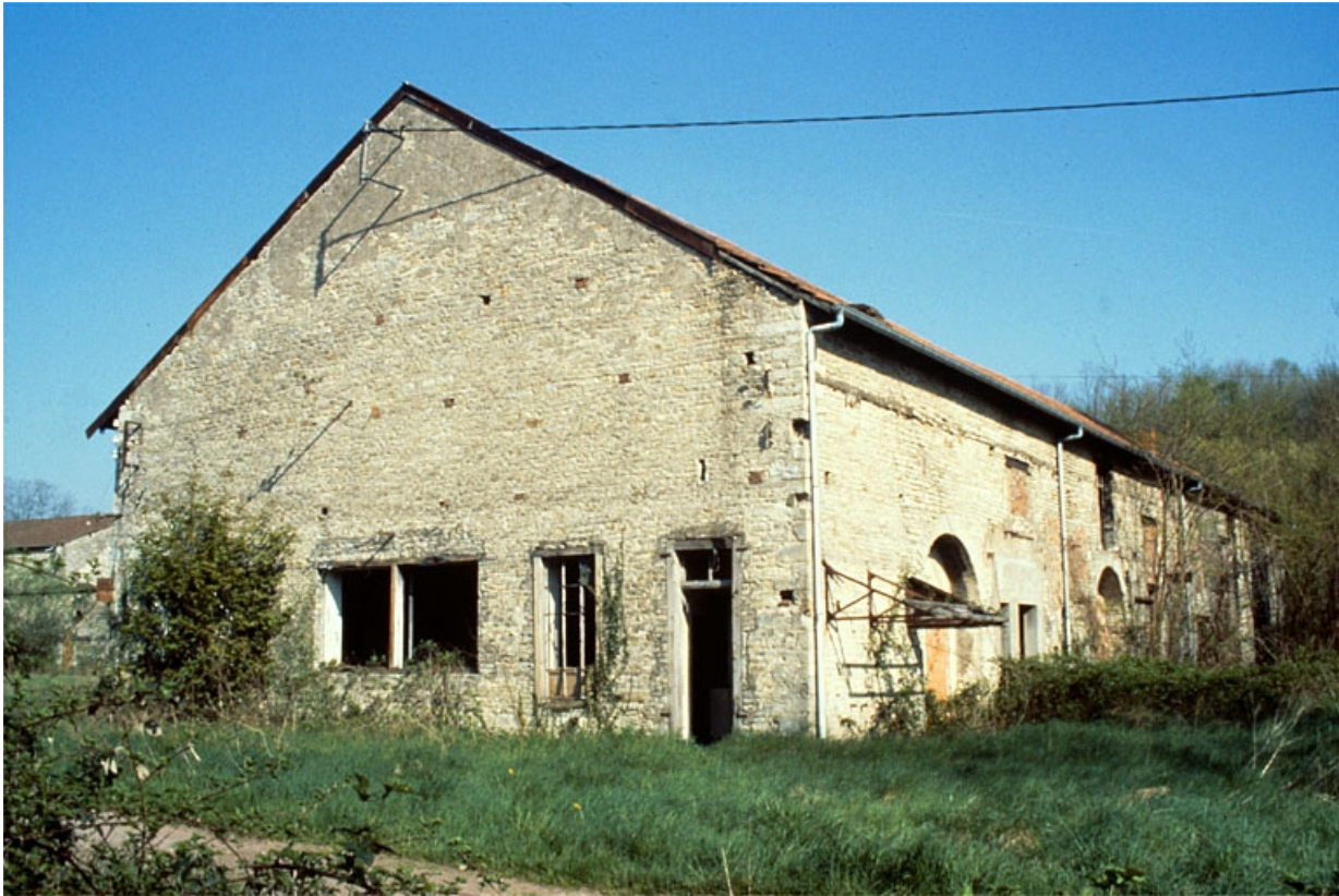
Forge Neuve. La chaînerie : façades postérieure et latérale droite.
