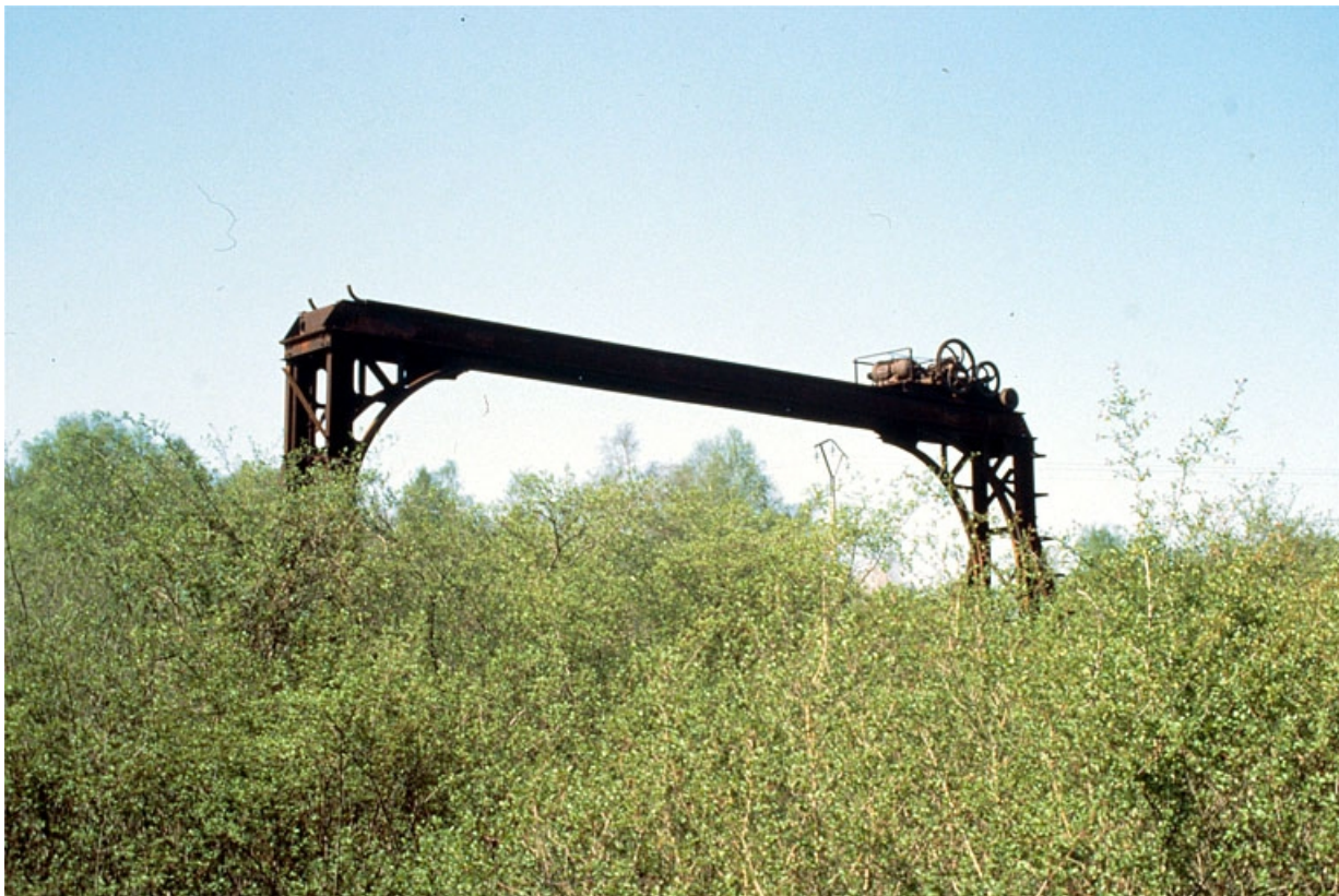
Forge Neuve. Portique roulant.
