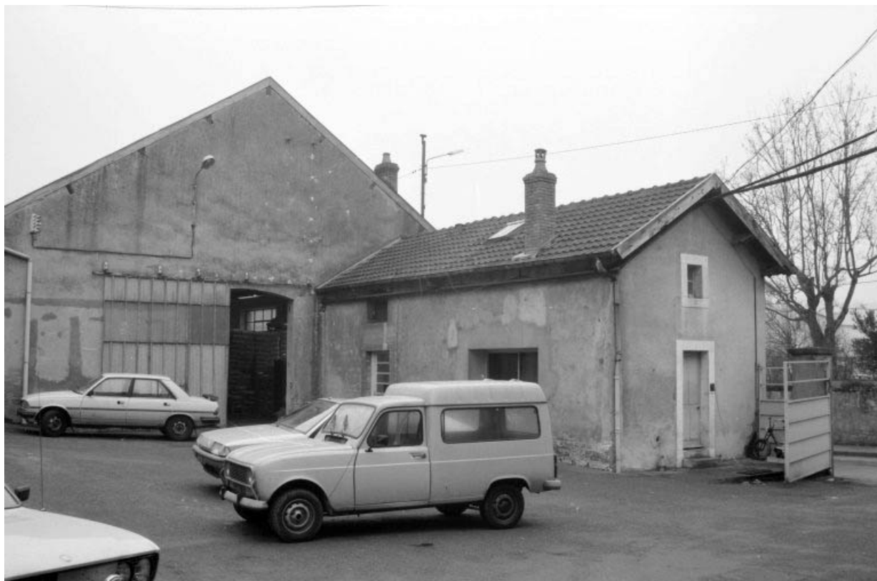
Entrée, cantine et entrepôt (8) vus de l'est.
