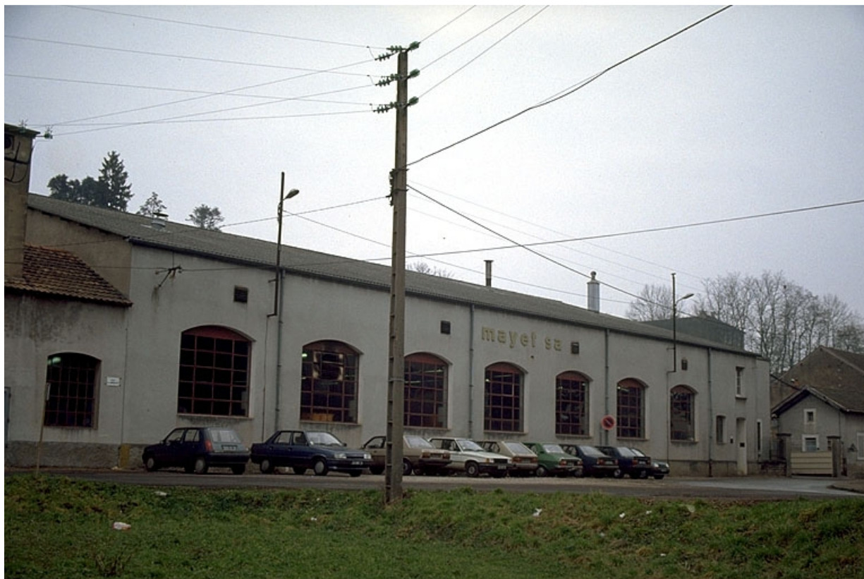
Façade antérieure de l'atelier de fabrication.
