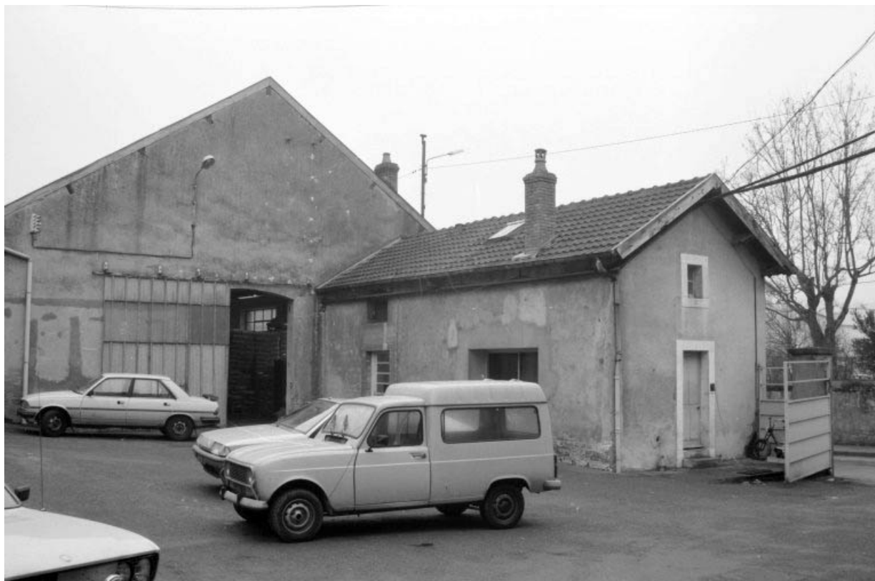
Entrée, cantine et entrepôt (8) vus de l'est.
