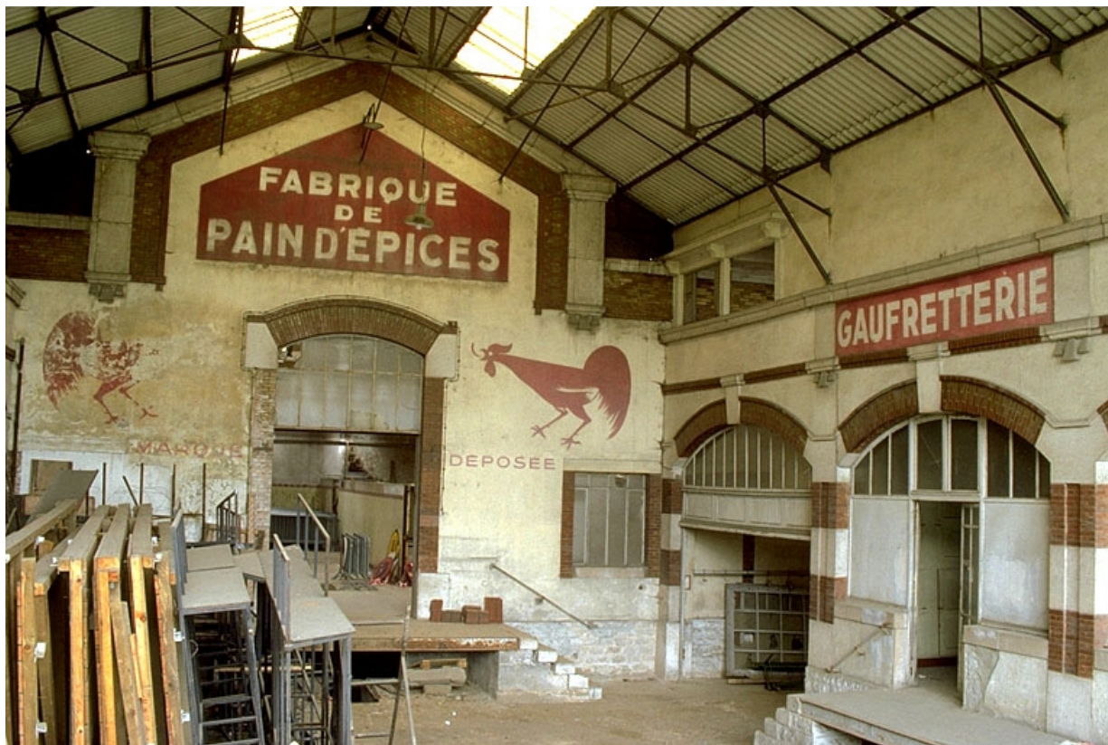
Cour couverte, atelier de fabrication (B2) et corps de bâtiment (A). 39, Dole, 42, 44 boulevard du Président Wilson
