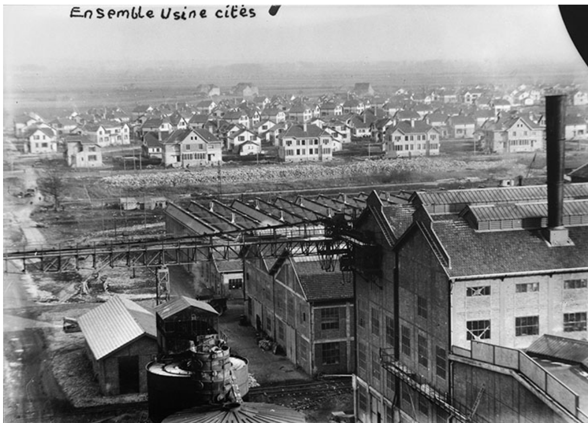
Vue d'ensemble : générateurs de vapeur et d'électricité et ateliers de réparation de l'usine en avant de la cité ouvrière de Tavaux. 39, Tavaux
