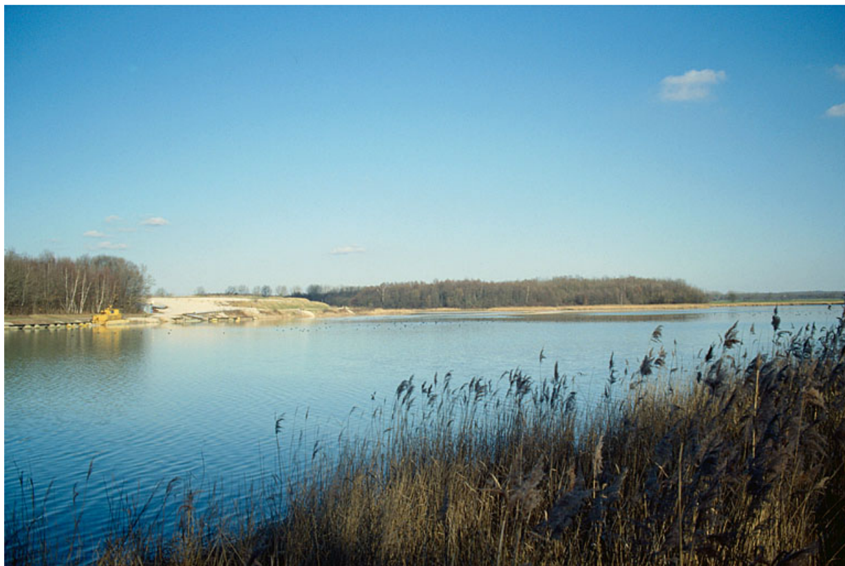
Etang de l'Aillon vu du sud-ouest.
