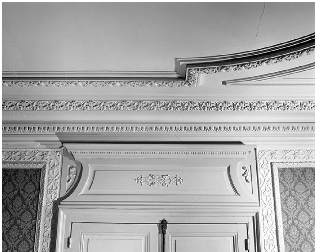
Logement patronal (A), salon : détail des moulures du dessus-de-porte et du plafond.
