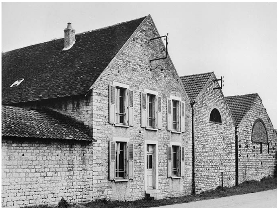
Façade antérieure du bâtiment (J).
