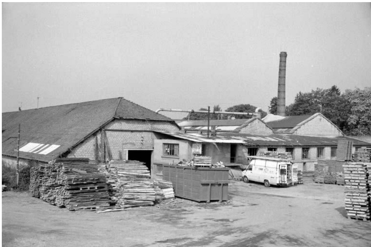
Ateliers de fabrication L, M et N (fabrique de palettes Bourgeois : 5, 7, 9 et 10), vus de trois quarts gauche. 39, Foucherans, 1 à 7 rue des Anciennes Forges
