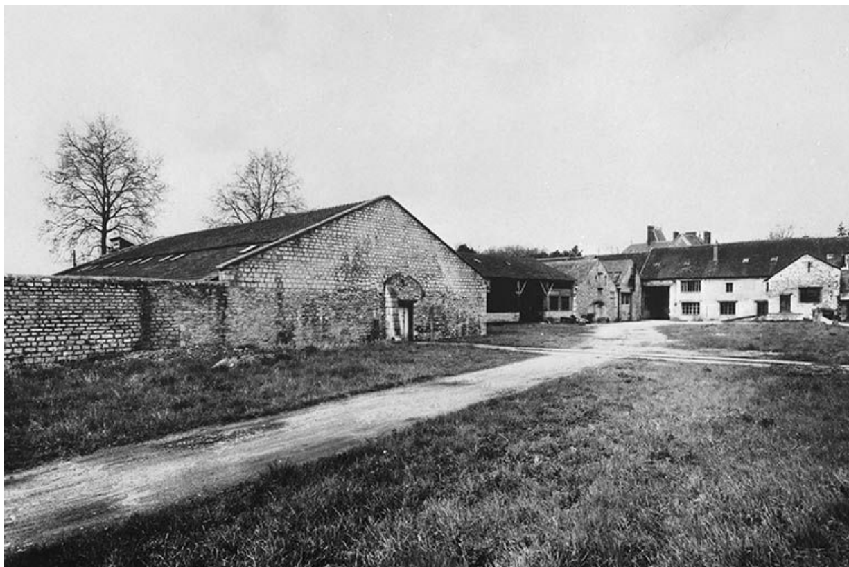
Bâtiments (H et J) et bureau (ancien moulin). 39, Foucherans, 1 à 7 rue des Anciennes Forges
