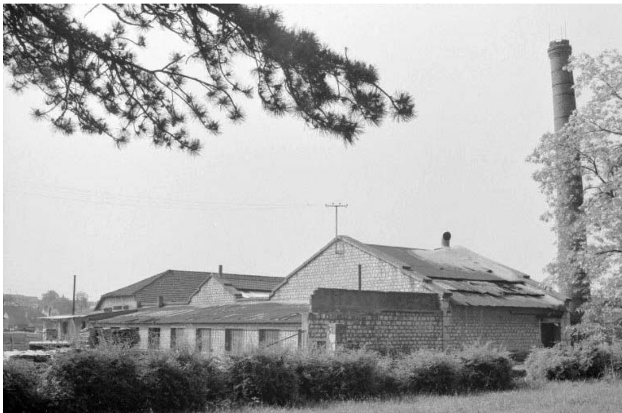
Ateliers de fabrication L, M et N (fabrique de palettes Bourgeois : 5, 7, 9 et 10), vus de trois quarts droit. 39, Foucherans, 1 à 7 rue des Anciennes Forges
