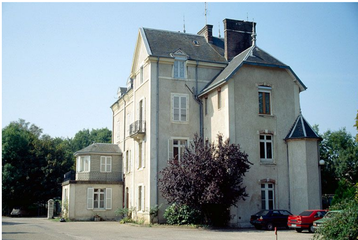
Façade latérale gauche du logement patronal (A). 39, Foucherans, 1 à 7 rue des Anciennes Forges
