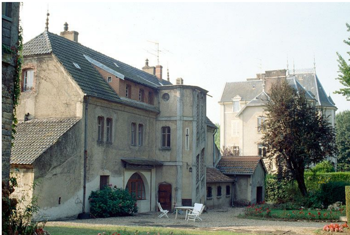
Façade postérieure du logement patronal (B). 39, Foucherans, 1 à 7 rue des Anciennes Forges
