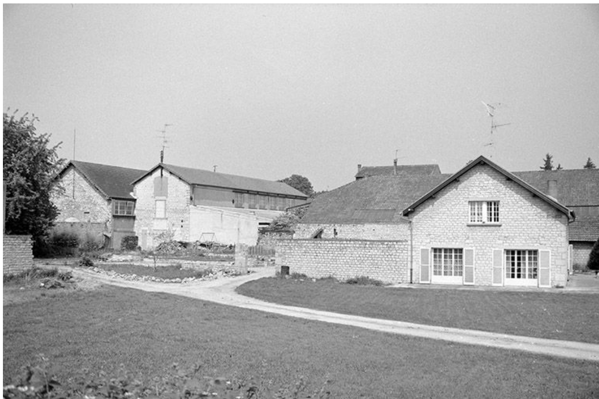
Fonderie (F) et chaufferie (P) vues de l'est.
