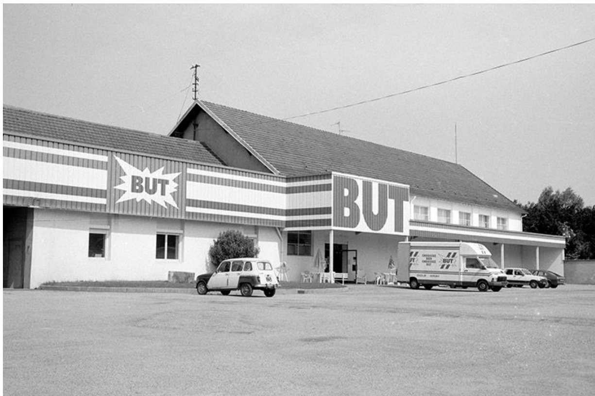
Magasin de commerce BUT (ancienne fonderie F2 et F3) vu de trois quarts gauche.
