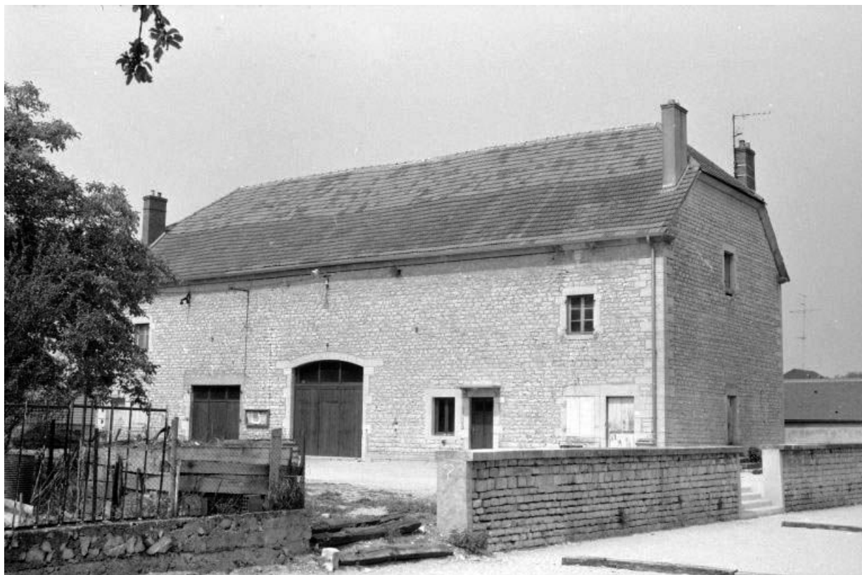
Ferme (W) dite "la maison Belin" vue de trois quarts droit. Cadastre : 1980 AI 31. 39, Foucherans, 1 à 7 rue des Anciennes Forges
