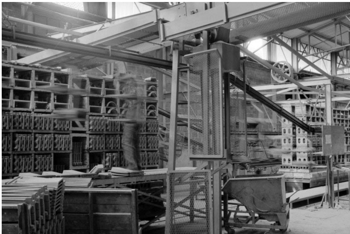
Atelier (K) : chargement de wagonnets.
