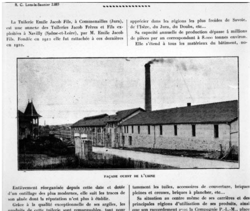
Façade ouest de l'usine, milieu des années 1920.
