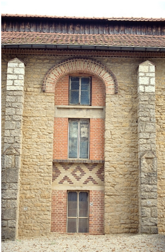
Atelier (A) : détail d'une travée étroite.
