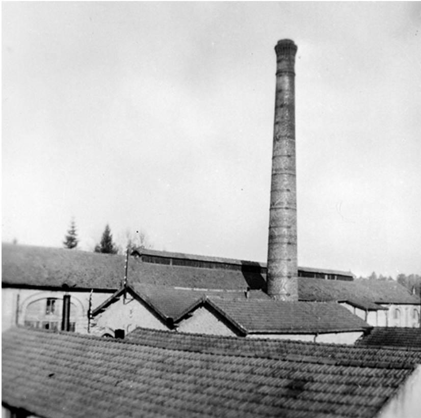
Ateliers et cheminée vus de l'est.
