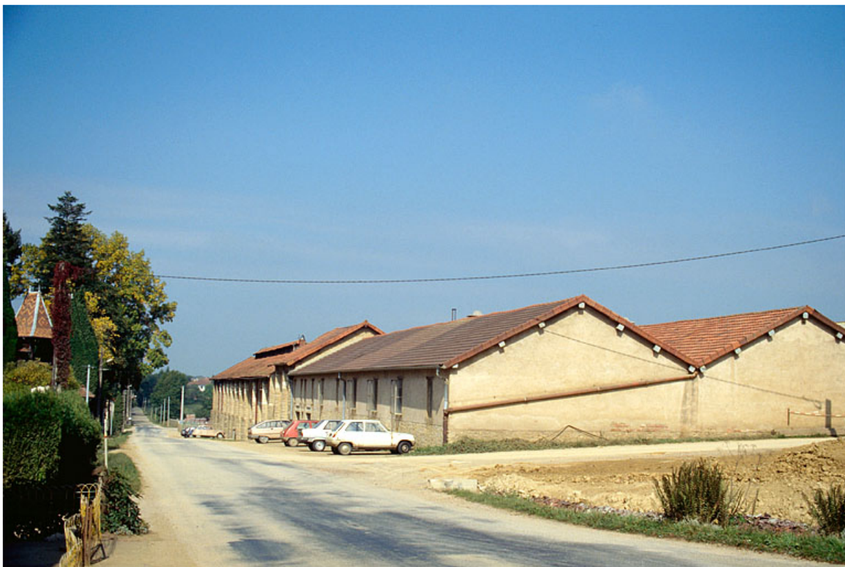
Ateliers de fabrication (A et B), vus du sud.
