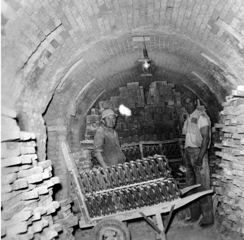
Déchargement du four Hoffmann.
