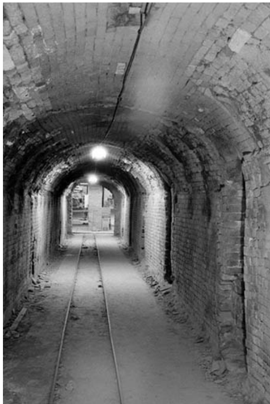
Atelier (A) : intérieur de l'ancien four Hoffmann.
