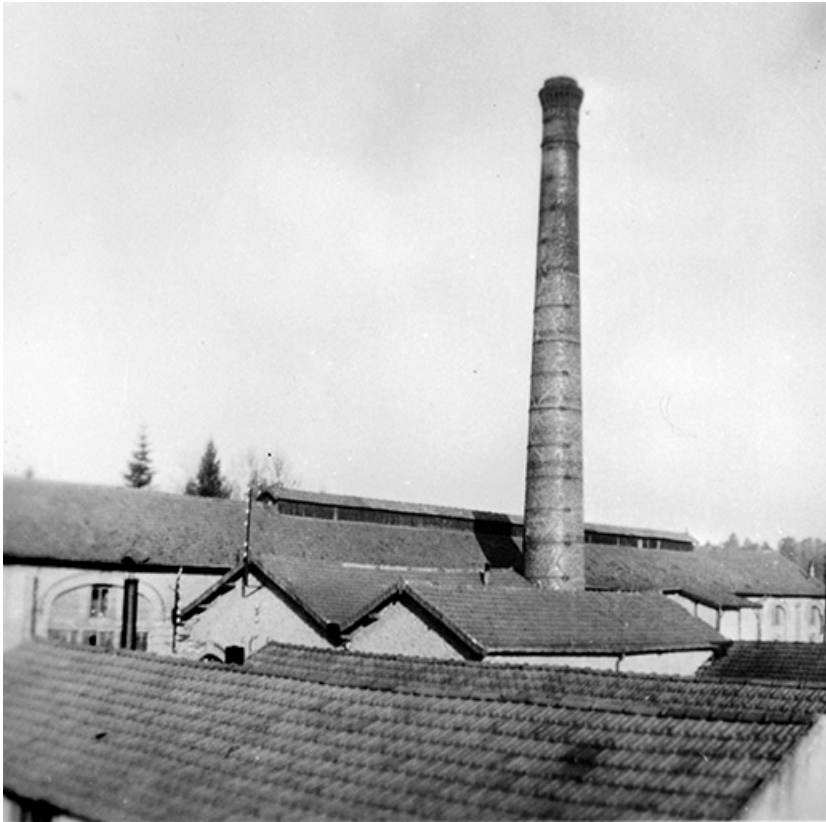
Ateliers et cheminée vus de l'est.
