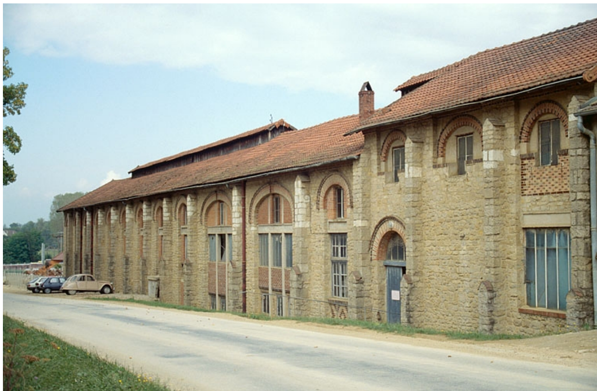
Atelier (A) : façade sur route.
