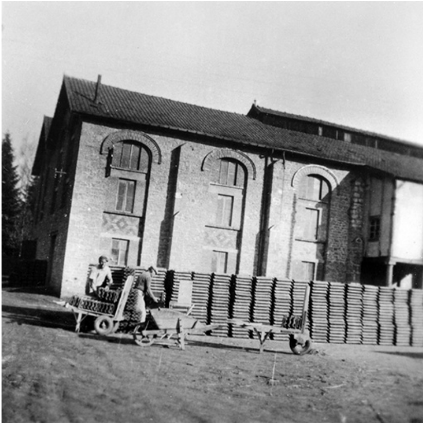
Stockage des tuiles cuites en plein air.
