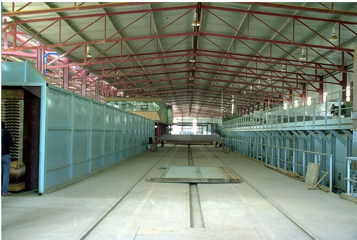
Atelier (M) : tunnel sécheur à gauche, four à bassin à droite.
