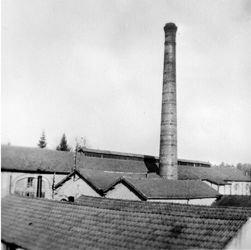
Ateliers et cheminée vus de l'est.
