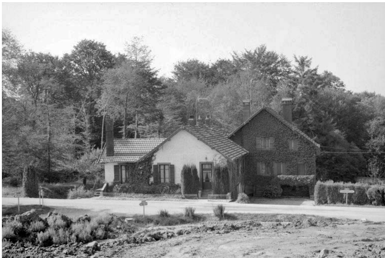
Logement d'ouvriers (Q, Q'), vu de l'est. 39, Commenailles, lieudit : la Tuilerie
