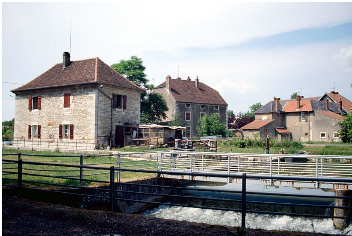
Ancien logement patronal (9) et logements d'ouvriers (7), en arrière de l'écluse et de la maison éclusière.
