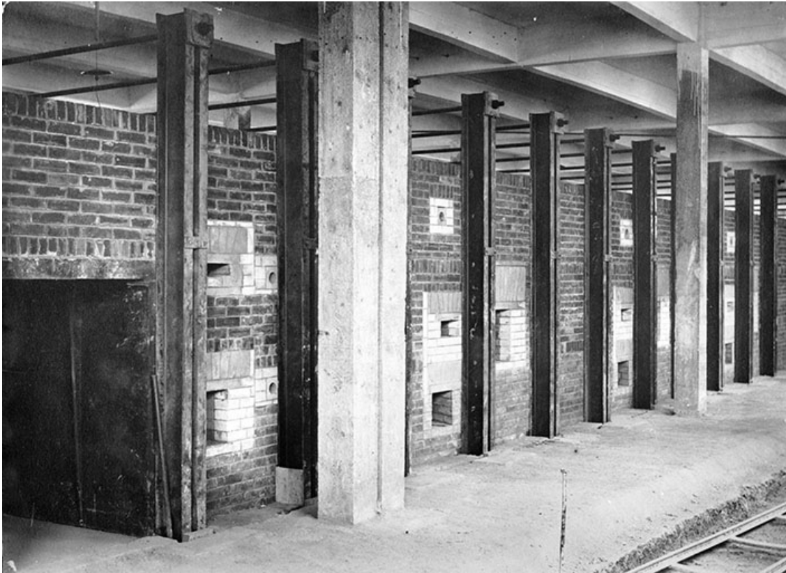
Four Dressler en construction : vue latérale.
