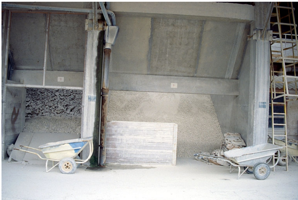
Hangar à terre (18) : détail des silos ouverts.
