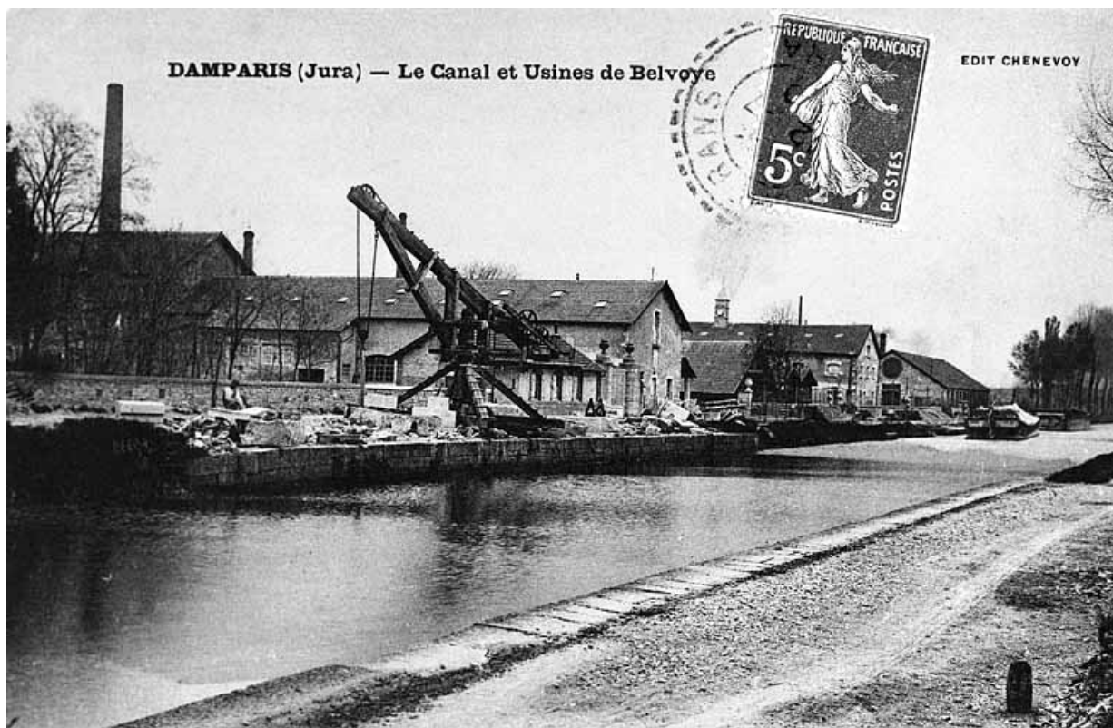
Damparis (Jura). Le Canal et Usines de Belvoye.
