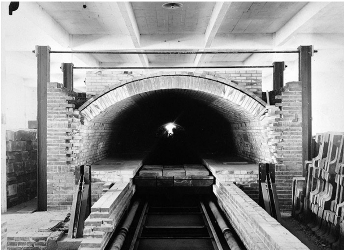
Four Dressler en construction : vue de face.
