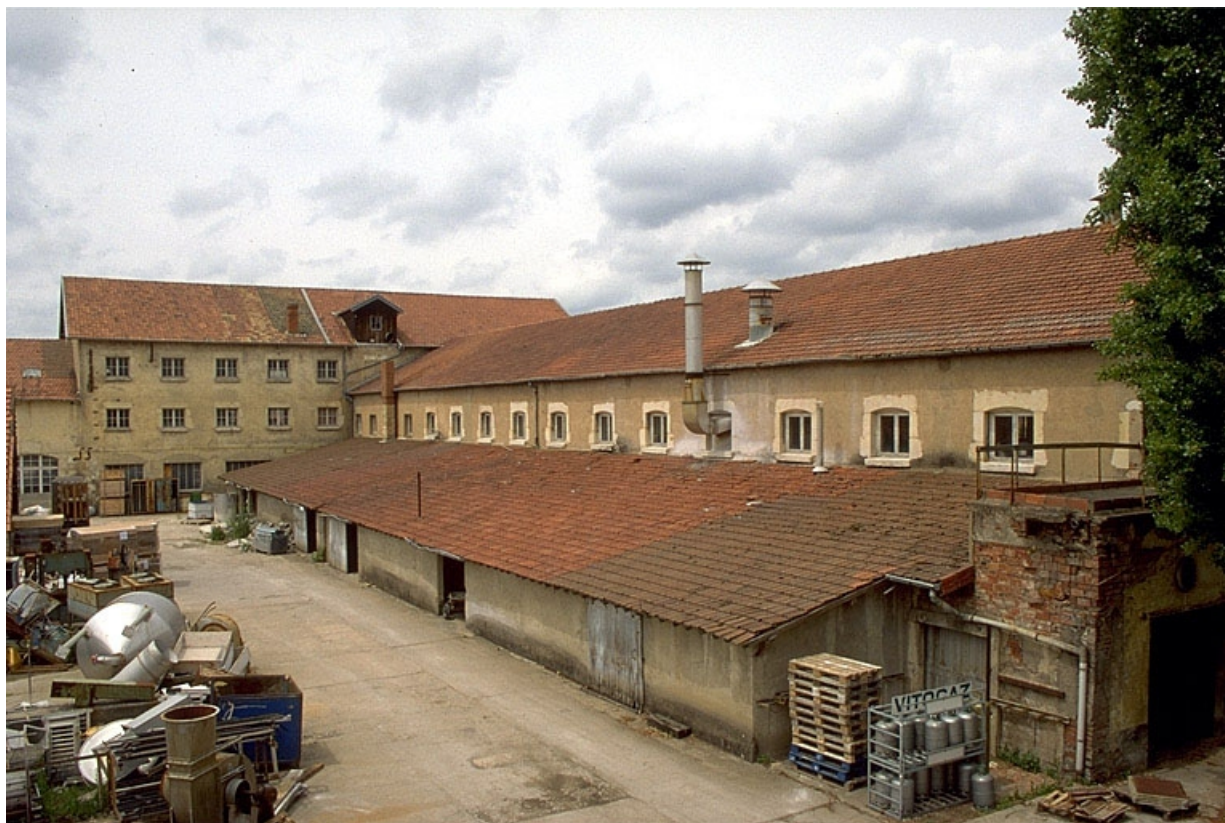
Vue partielle de l'atelier (27), depuis l'est.
