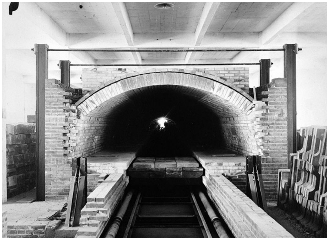
Four Dressier en construction : vue de face.
