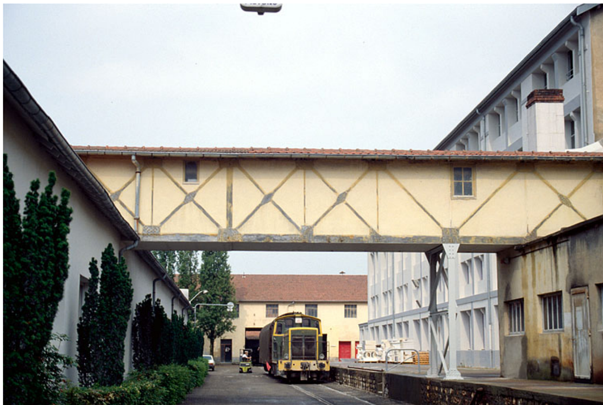
Façade antérieure de l'atelier (42), passerelle et locomotive.
