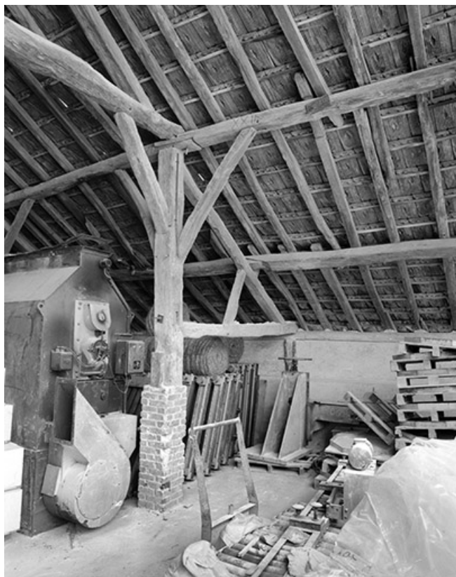
Charpente du hangar à terre (25) : détail d'un poteau.
