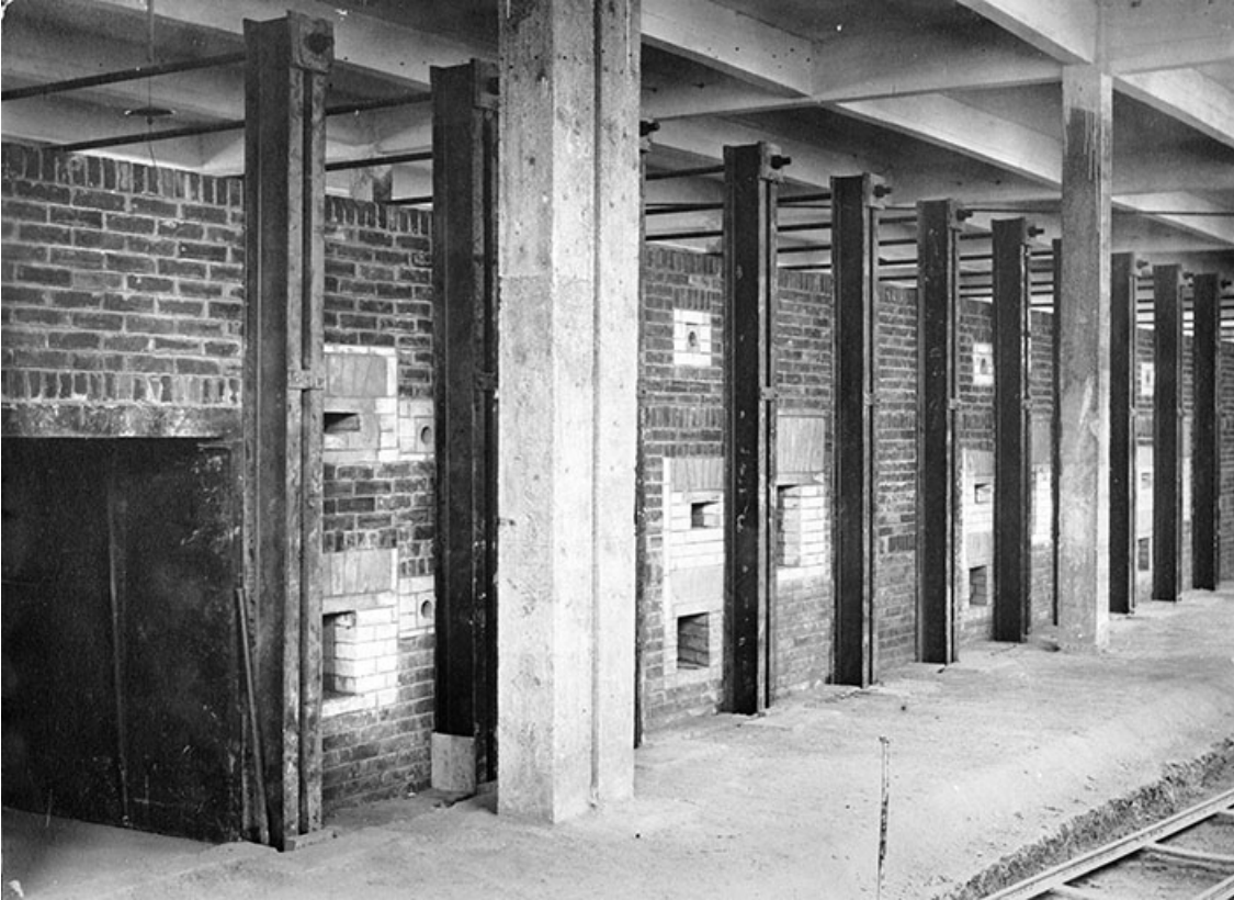
Four Dressler en construction : vue latérale.
