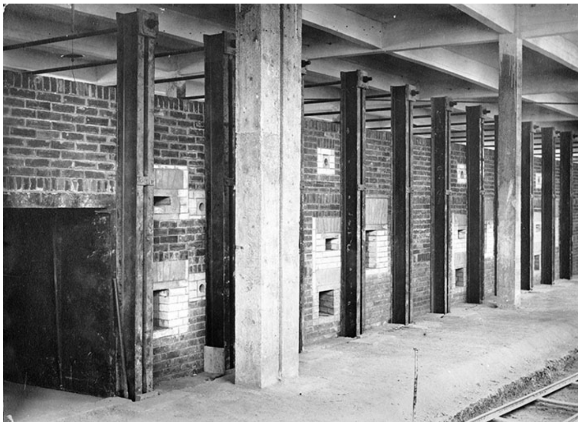
Four Dressler en construction : vue latérale.
