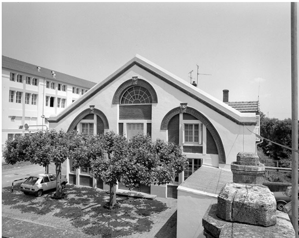
Façade antérieure des bureaux, vue de trois quarts droit.
