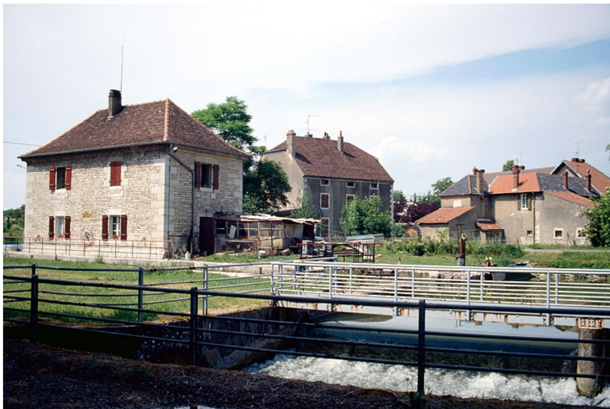
Ancien logement patronal (9) et logements d'ouvriers (7), en arrière de l'écluse et de la maison éclusière.
