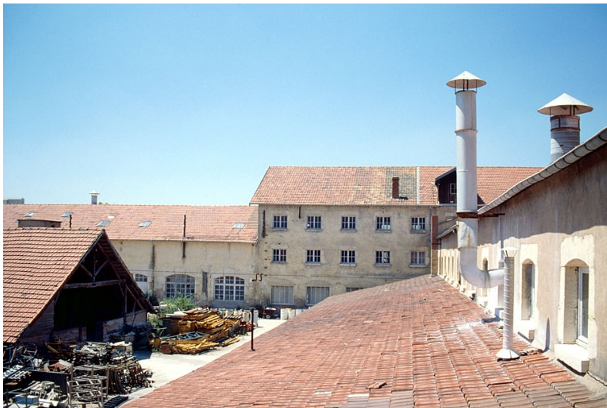
Vue partielle de l'atelier (27), depuis l'est.
