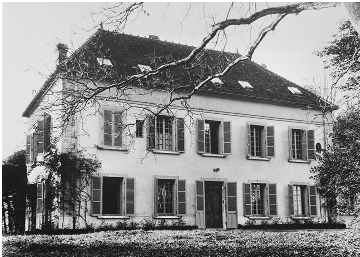
Logement patronal du Clos de Belvoie, façade antérieure.
