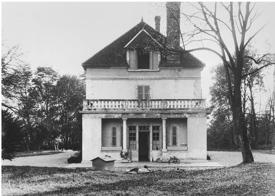
Logement patronal du Clos de Belvoie, façade latérale droite.
