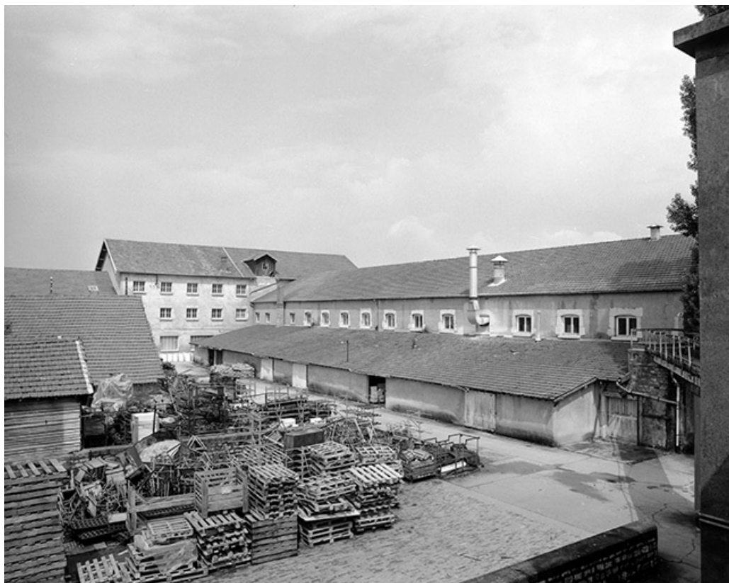
Atelier de préparation des émaux (27) et laboratoire (26), vus depuis le "cochon" (22). 39, Damparis, 4 rue du Moulin, lieudit : Belvoir
