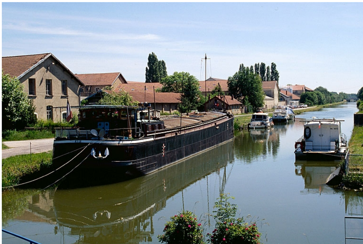
Vue d'ensemble de l'usine, depuis l'écluse.
