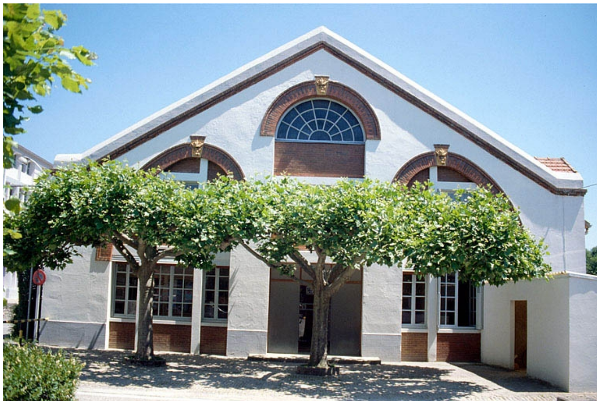
Façade antérieure des bureaux, vue de face.
