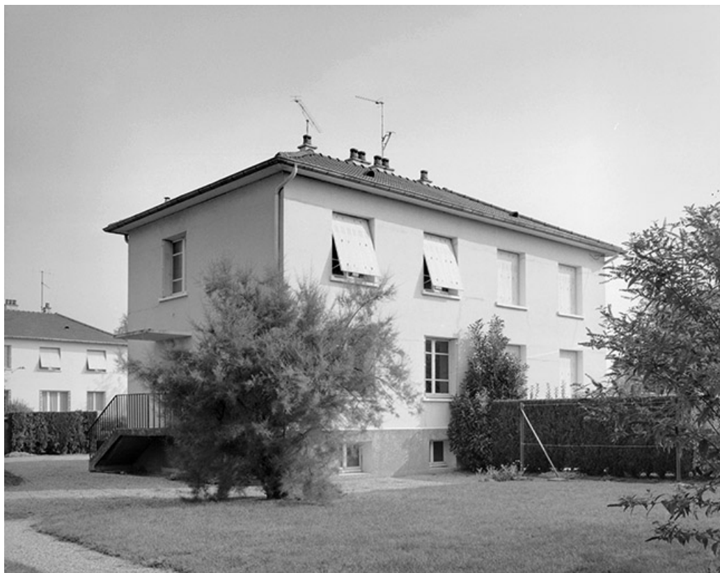
Maison de même genre, 18, 20 rue Buffon, façade postérieure et face droite.
