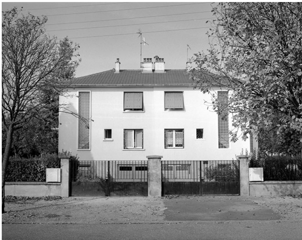
Maison de même genre, 38, 40 avenue Général Leclerc, façade antérieure vue de face.
