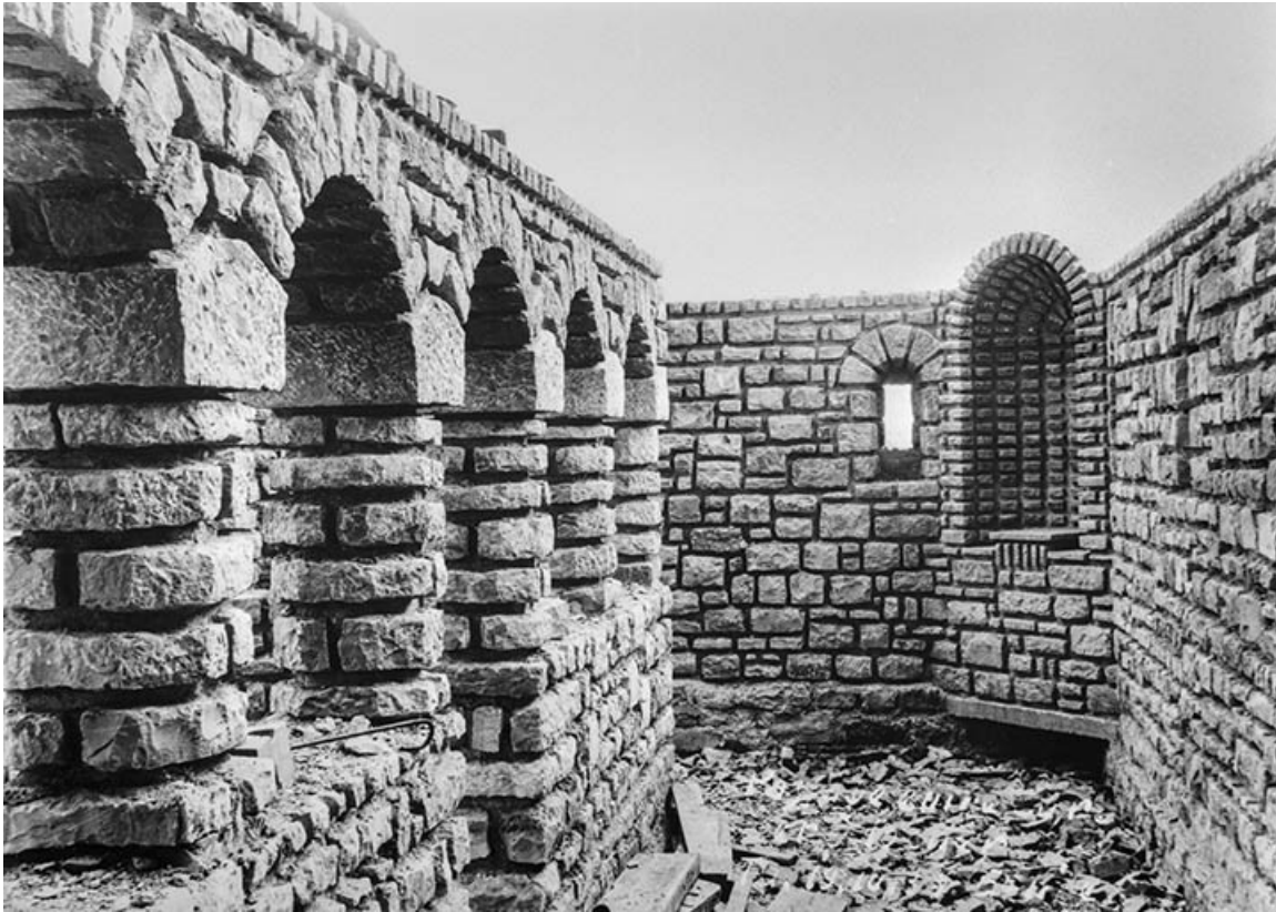
Travaux de construction de l'église, galerie reliant l'église au presbytère.
