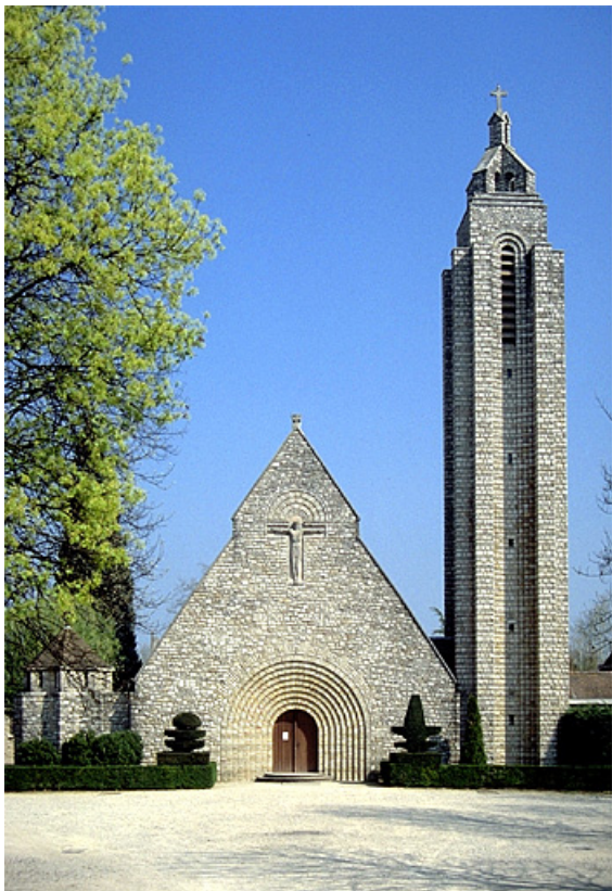
Façade antérieure, vue de situation.
