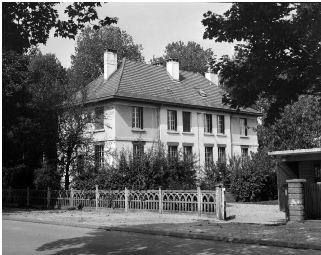
Façade postérieure et face droite d'une maison identique, 45, 47 avenue de la République. 39, Tavaux, 6, 8 avenue Albert 1er, lieudit : Tavaux Cité
