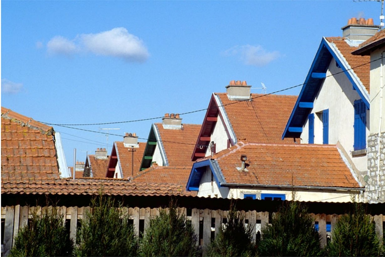
Façades postérieures des maisons de type 10A, rue de Belvoye, prises depuis la place Jeanne d'Arc. 39, Damparis, lieudit : Cité des Carrières
