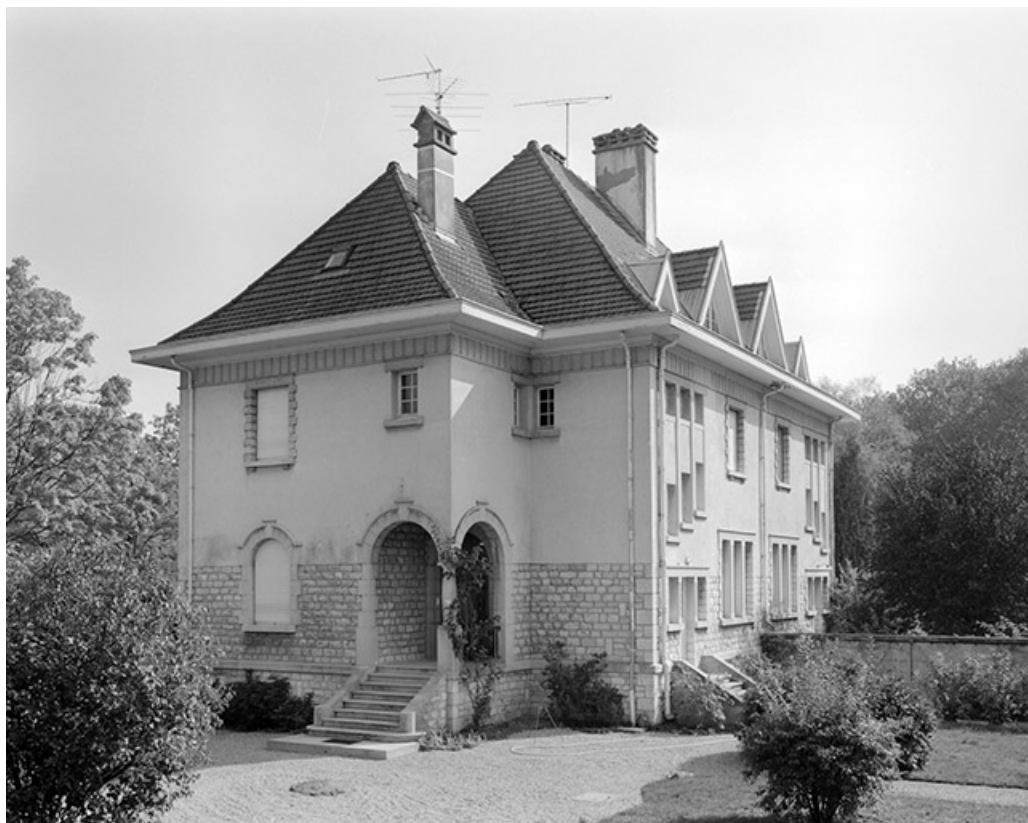
Façade postérieure et face droite.
