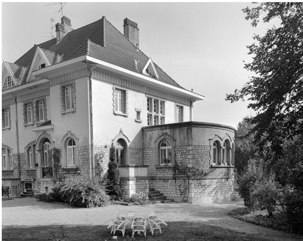
Face latérale droite de la maison 2, 4 avenue Alfred Solvay.
